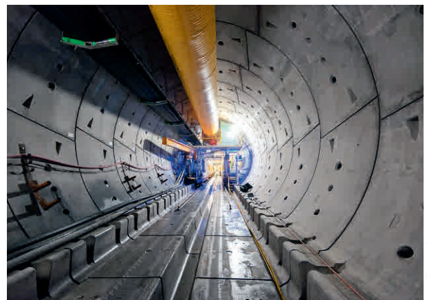
9 Tübbingauskleidung Sicherheitsstollen Safety gallery segmental lining
