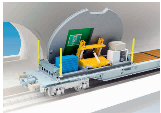
9 Schienengebundener Einbau Rail-bound installation
