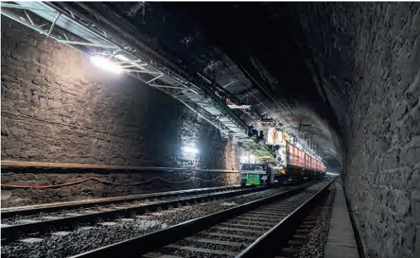
11 Stationärer Betonzug im Tunnel Stationary concrete train in tunnel
