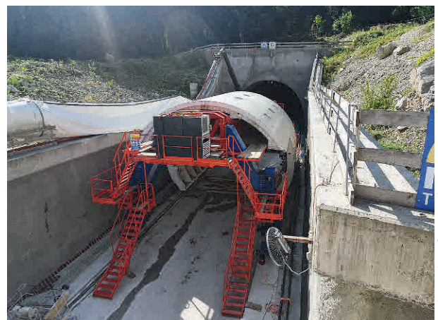
19 Montage du coffrage outil – Tunnel dans la tranchée couverte nord Assembling the tunnel tool formwork in north cut-and-cover tunnel
