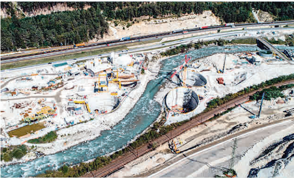
6 Pozzi di accesso per il sottoattraversamento del fiume Access shafts for the undercrossing of the river
