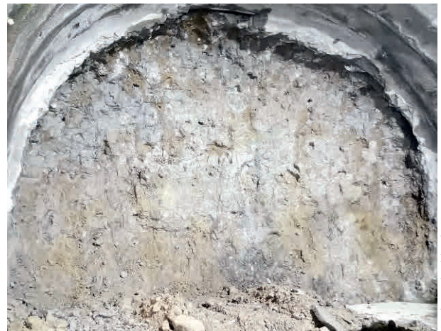
16 Fronte di scavo classe di scavo C1 con QSJ Excavation front for excavation class C1 with QSJ
