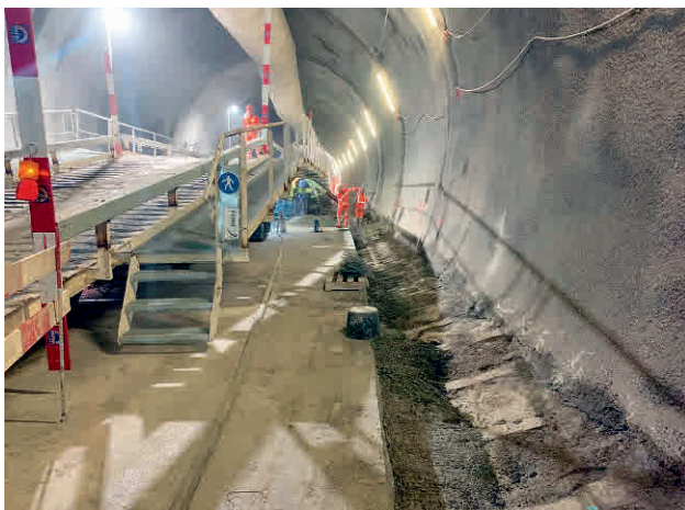
17 Travaux de radier définitif sous le pont de bétonnage Final-invert work under the concreting bridge
