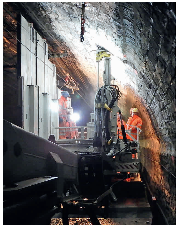
3 Bohren der Anker für Monorailschienen mit Ankerzug Drilling the anchors for monorail tracks with anchor train
