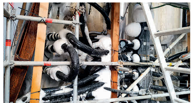
10 Impianto per le sonde congelatrici Implant for the freezing probes
