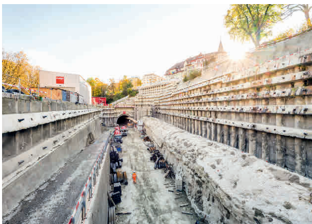
9 Baugrube Wildpark mit Sicht auf freigelegten Schanzentunnel Wildpark construction pit with a view of the excavated Schanzen Tunnel
