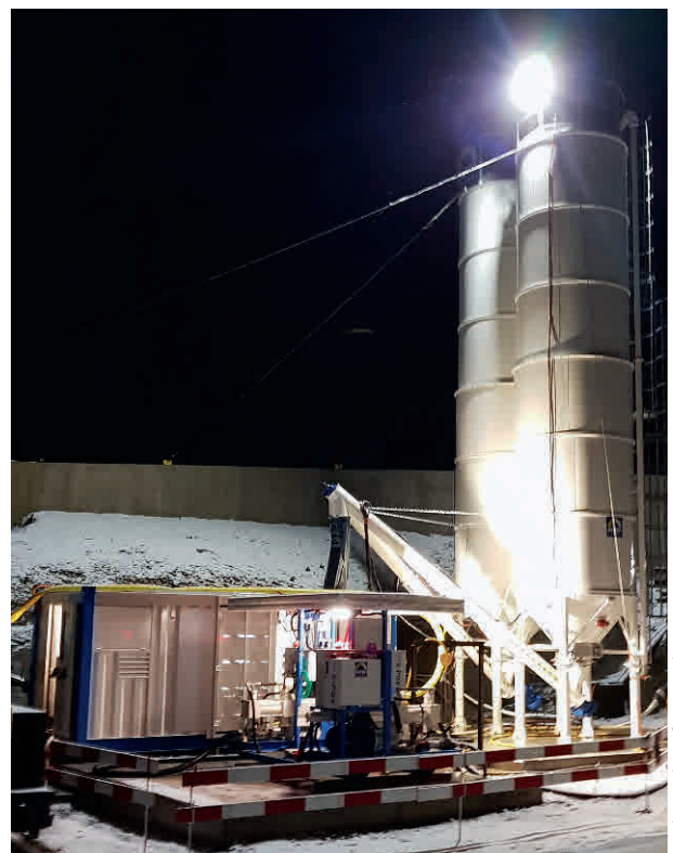
11 Installation de production du coulis de ciment Cement grout production plant
