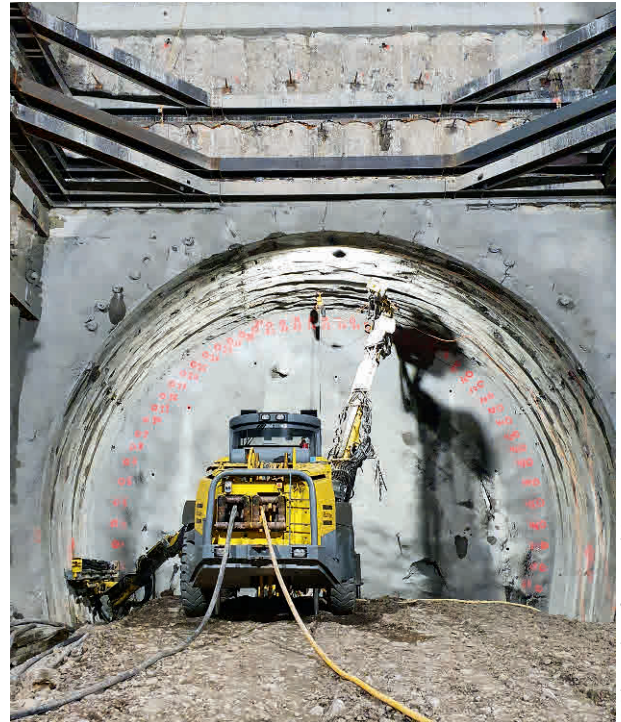
20 Étape 72 – réalisation de la voûte parapluie – Jumbo L2C Stage 72 – construction of the pipe roofing umbrella arch – Jumbo L2C
