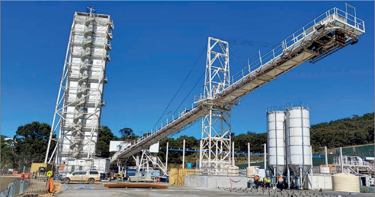
SNOWY 2.0 (Australien) - 3 Förderbandanlagen zur Erweiterung des Pumpspeicherwerkes in den Snowy Mountains www.rowa-ag.ch
