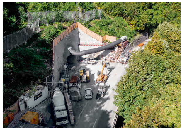
14 Voreinschnitt Tiefenwinkel Tiefenwinkel pre-cut
