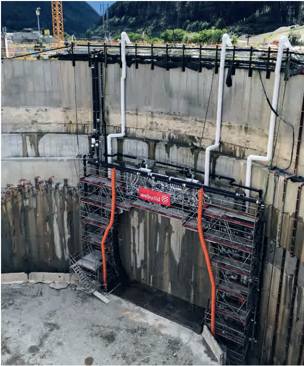
9 Predisposizione del portale per il congelamento Predisposition of the portal for freezing
