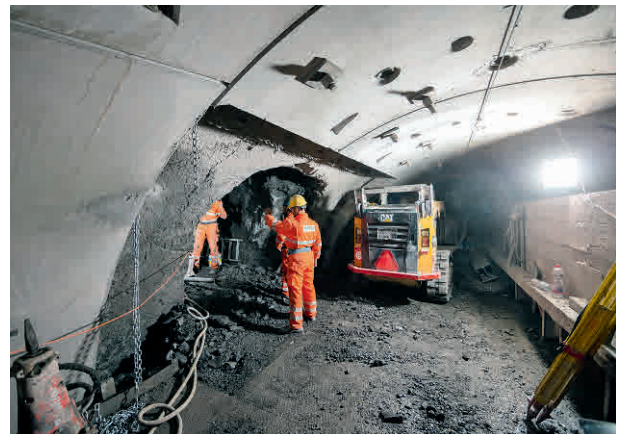
11 Ausbrucharbeiten auf der Arbeitsplattform Breakout work on the working platform
