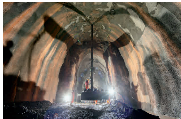
16 Bohrkopf Raise Boring Lüftungsschacht Raise boring cutterhead for ventilation shaft
