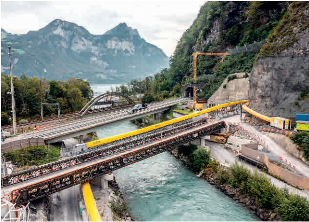
7 Hilfsbrücke zum Voreinschnitt Gäsi Auxiliary bridge for Gäsi pre-cut
