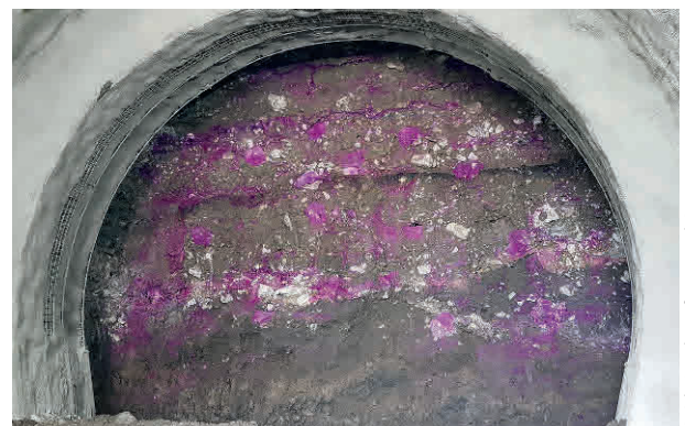
15 Mise en évidence de la diffusion du coulis de ciment par projection de phénolphtaléine Demonstration of the spread of the cement grout via phenolphthalein spray
