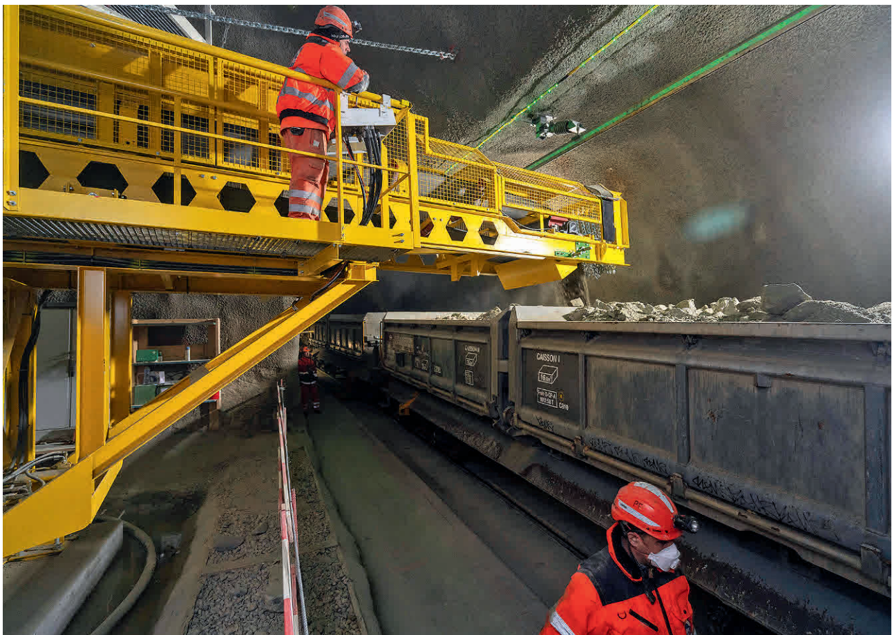
13 Chargement du marin en souterrain, tunnel de Tridel : chantier LEB - 2020 Underground muck loading, Tridel tunnel: LEB construction site – 2020
