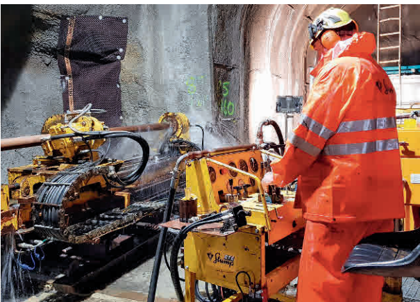
3 Esecuzione sondaggio geognostico a carotaggio continuo da parte di Stump AG Probe drilling with continuous coring by Stump AG
