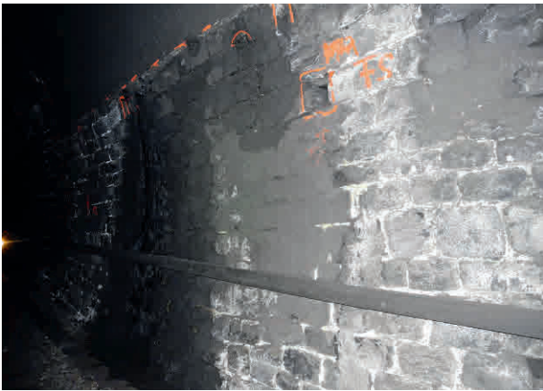
3 Nassstelle mit Wassereintritt, Bahntunnel Wet patch with water ingress, railway tunnel
