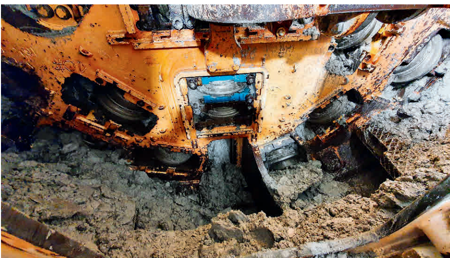
8 Materiale all'interno della testa della TBM al momento del fermo a Tm 451 Material inside the TBM cutterhead at the time of the stop at tunnel metre 451
