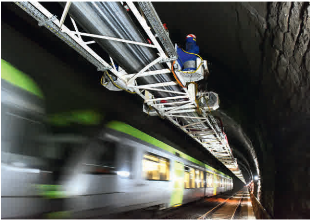
7 Überspannung Bauabschnitt mit Monorail-Förderband Spanning construction section with monorail conveyor belt
