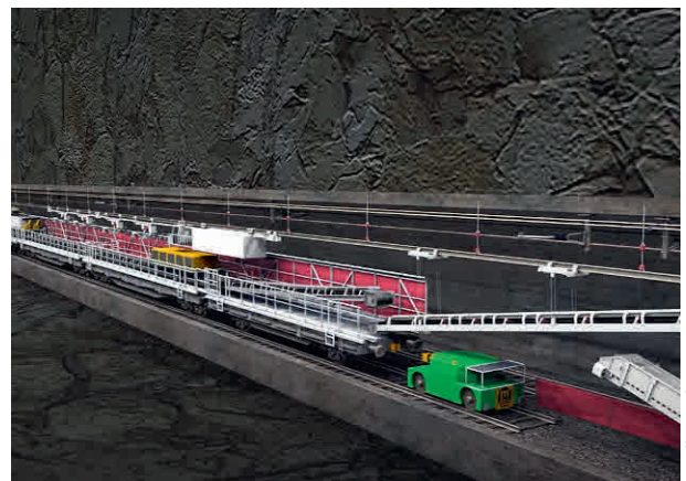
6 Übergabe Beton von Betonzug auf Monorail-Förderband Transferring concrete from concrete train on monorail conveyor belt
