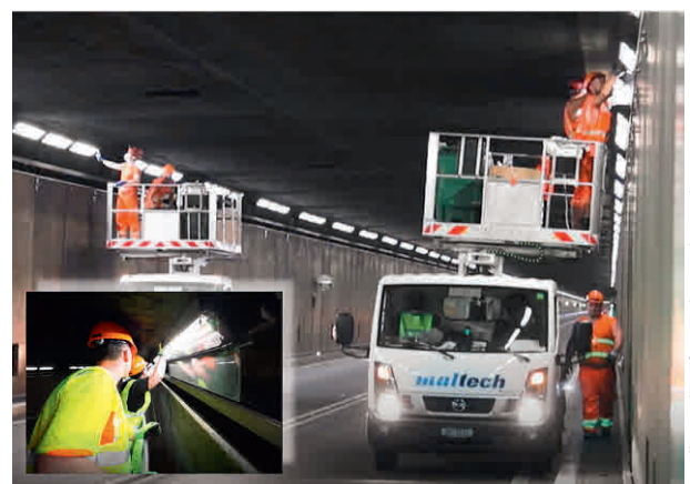
4 Ersatz der Durchfahrtsbeleuchtung durch das System «Retrofit» Replacement of the transit lighting with the “Retrofit” system
