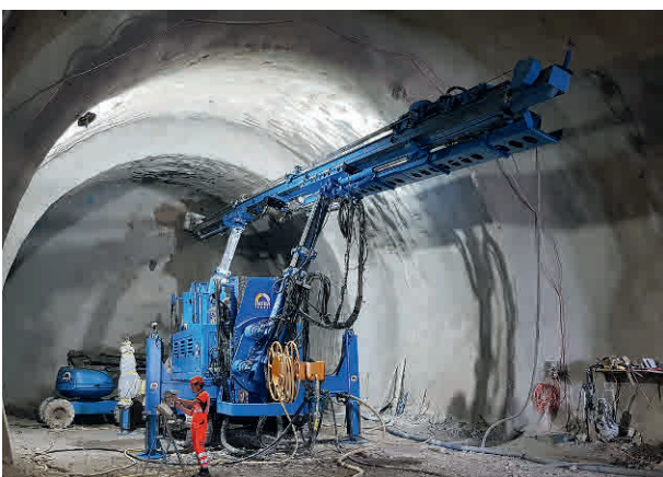
13 Foreuse pour réalisation du jet-grouting Drill for conducting jet-grouting
