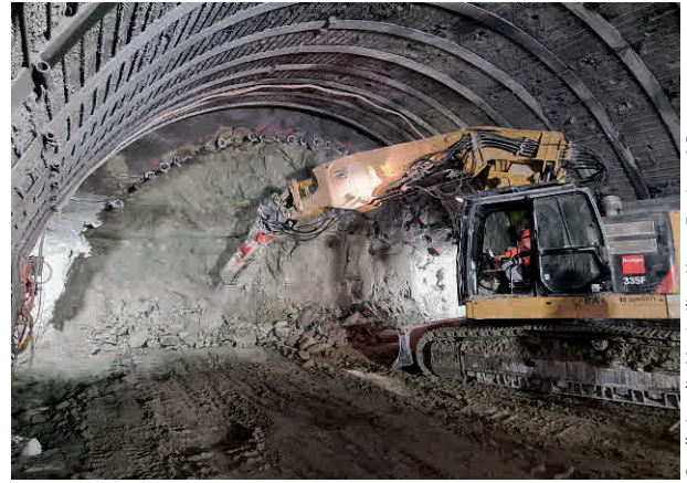
4 Doppelspurtunnel Bierhübeli, Kalottenvortrieb Bierhübeli twin-track tunnel, top heading excavation
