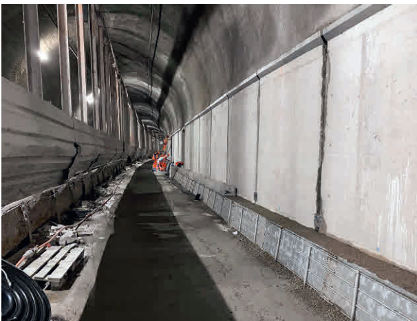
10 Mauerwerkseratz und Sohlenabsenkung, Bahntunnel Masonry replacement and invert lowering, railway tunnel
