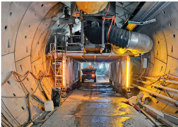
10 Arbeitsplattform für den Ausbruch der Abluftstollen Working platform for breakout of the exhaust galleries
