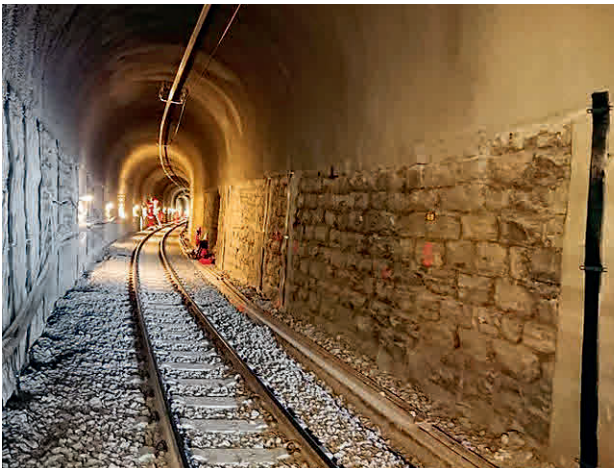
9 Entwässerungsschlitz inkl. Planausschnitt, Bahntunnel Drainage slots incl. plan detail, railway tunnel
