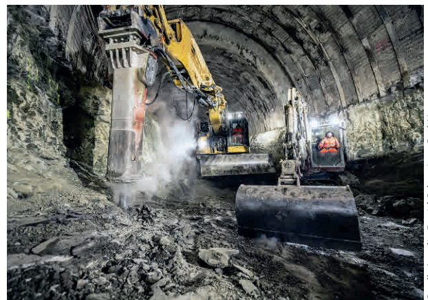
5 Strossenabtrag Abschnitt 4 Bench removal, Section 4
