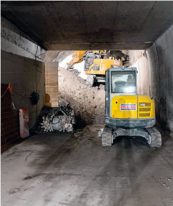
13 Überfirstungsarbeiten Kreuzungsbereich Hofwald Work to raise the tunnel roof at Hofwald intersection
