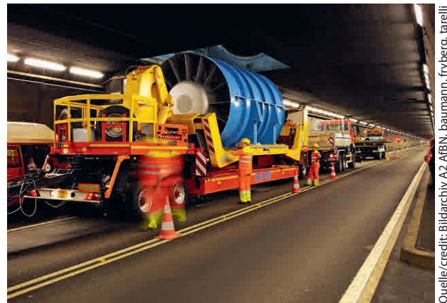
3 Austausch Lüftungsventilator Exchange of ventilation fan
