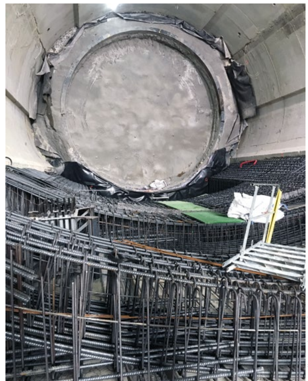
7 Anfahrkaverne Station La Dhuis, Stirnwand mit Anfahr-dichtung Launching Chamber Station La Dhuis, Starting Sealing in Front Face
