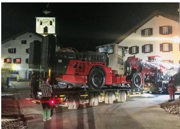
6 Nächtlicher Antransport eines Bohrwagens durch Bergün Night-time transport of a drill jumbo through Bergün
