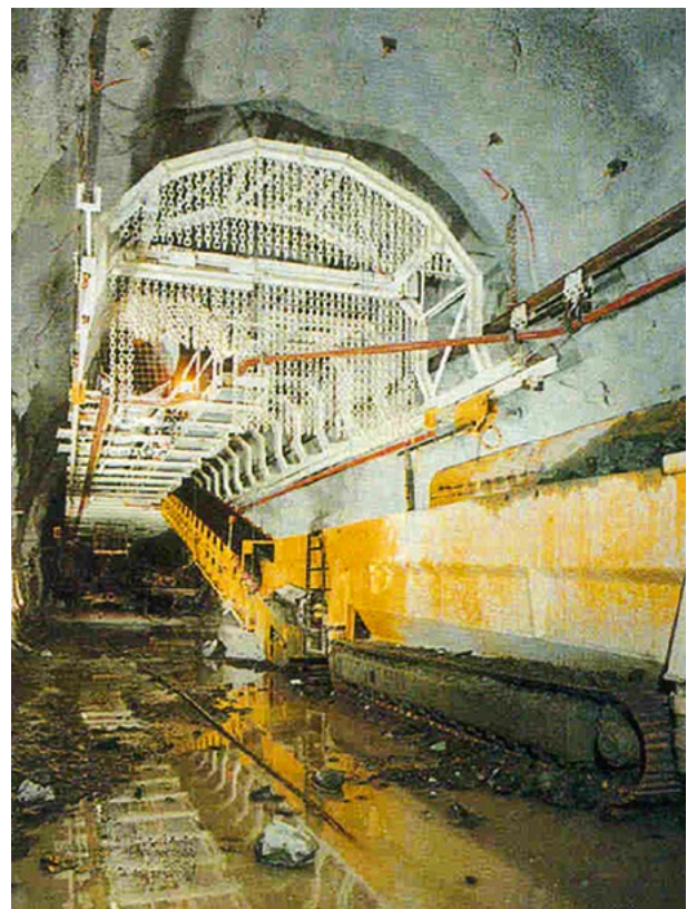
3 Hängebühne, Vereinatunnel Süd Hanging scaffold, Vereina Tunnel South
