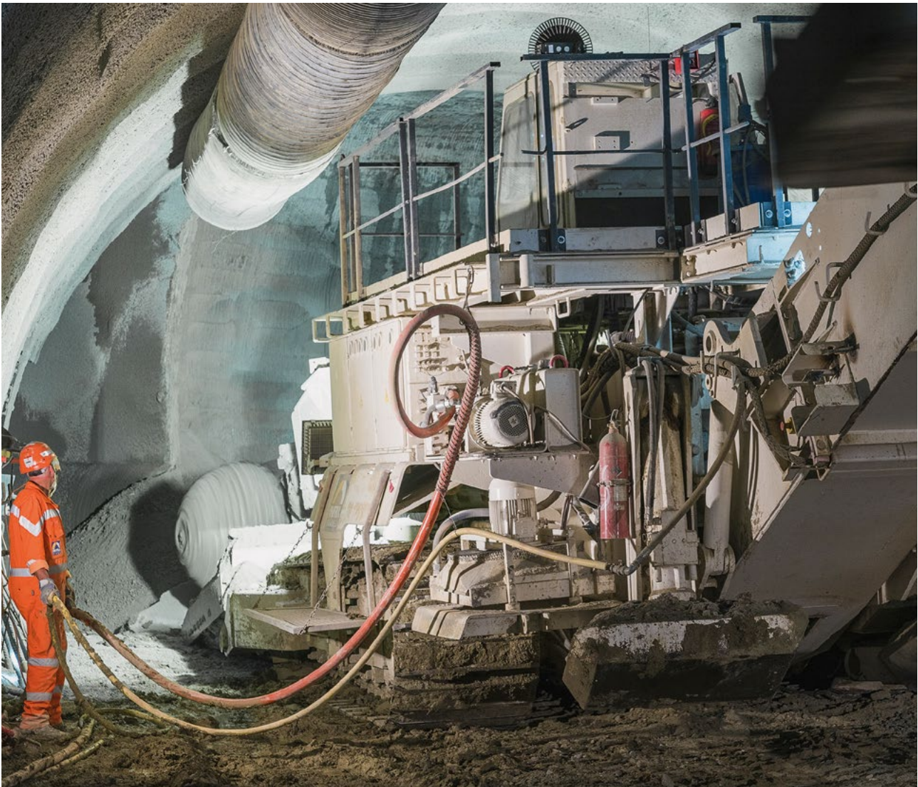
6 Excavation de la calotte avec la haveuse Eickhoff ET 450 Excavation of the heading with the Eickhoff ET 450 roadheader
