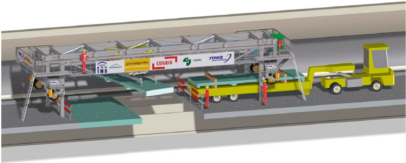
8 Baustelle zur Sanierung der durch den Brandfall vom 24. März 1999 geschädigten Fahrbahn am Mont-Blanc-Strassentunnel Construction site for the renovation of the carriageway of the Mont Blanc road tunnel damaged by the fire on 24 March 1999
