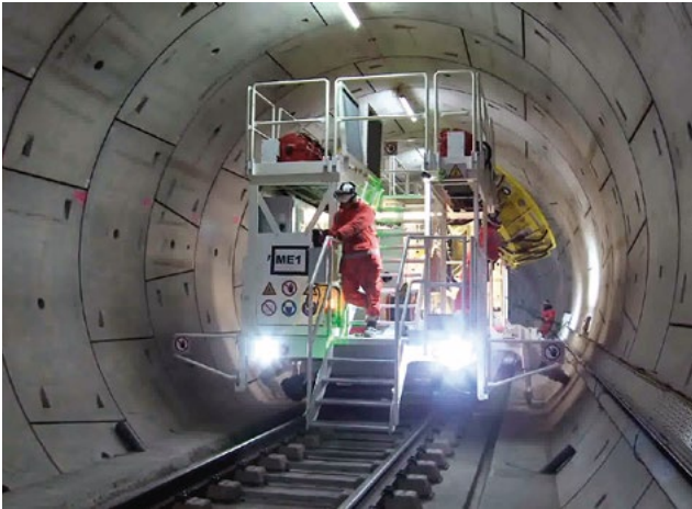
6 Crossrail C610: Umsetzen des selbstfahrenden Bohrwagens (links); Bohrstaub wird direkt an jedem Bohrloch abgesaugt (rechts) Crossrail C610: Relocation of the self-driven drilling jumbo (left); drilling dust is suctioned off directly at each borehole (right)
