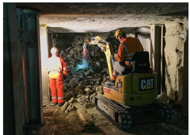
15 Setzungsmindernde Massnahmen PostParc – Vortriebsarbeiten aus dem Posttunnelsystem Settlement-reducing measures for PostParc – excavation work from the postal tunnel system
