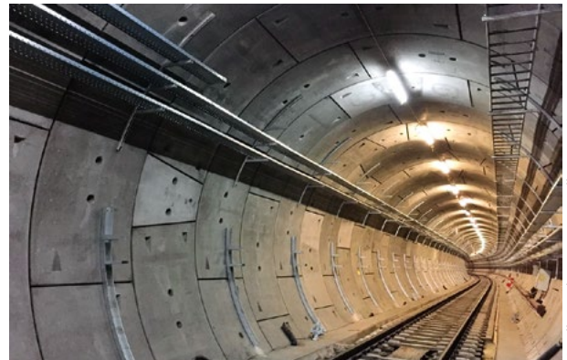
7 Crossrail C610: befestigte Halterungen für die elektromechanischen Systeme Crossrail C610: Secured brackets for the electromechanical systems
