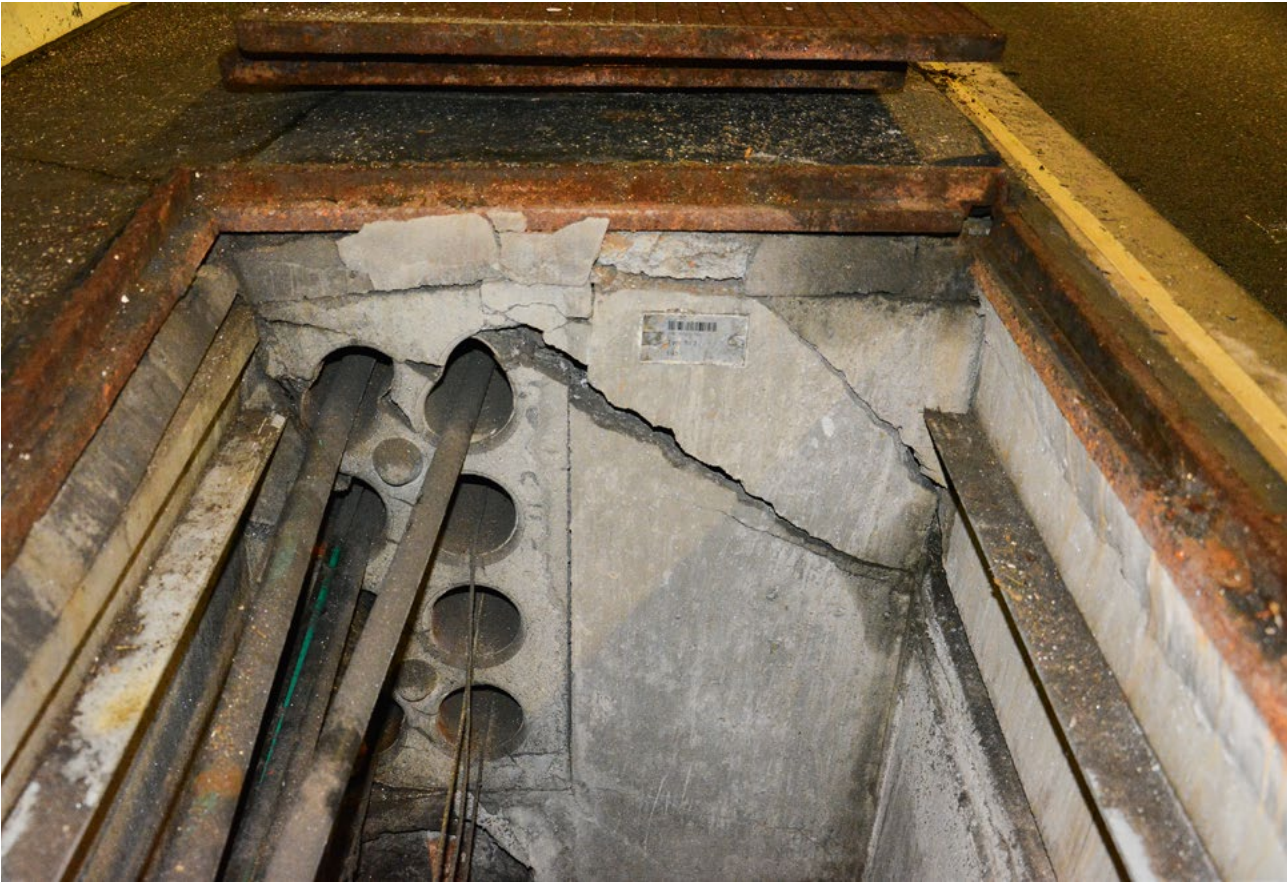
2 Schubrisse in Kabelzugschacht Thrust cracks in cable shaft
