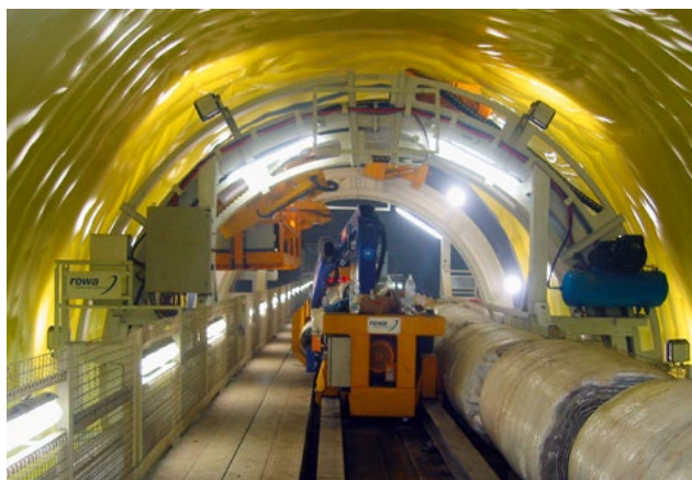
4 Wurm am Installationsplatz Bodio des Gotthard-Basistunnels (links); Arbeitsbereich Gewölbeabdichtung (rechts) Worm at the Bodio installation location of the Gotthard Base Tunnel (left); vault-seal work area (right)
