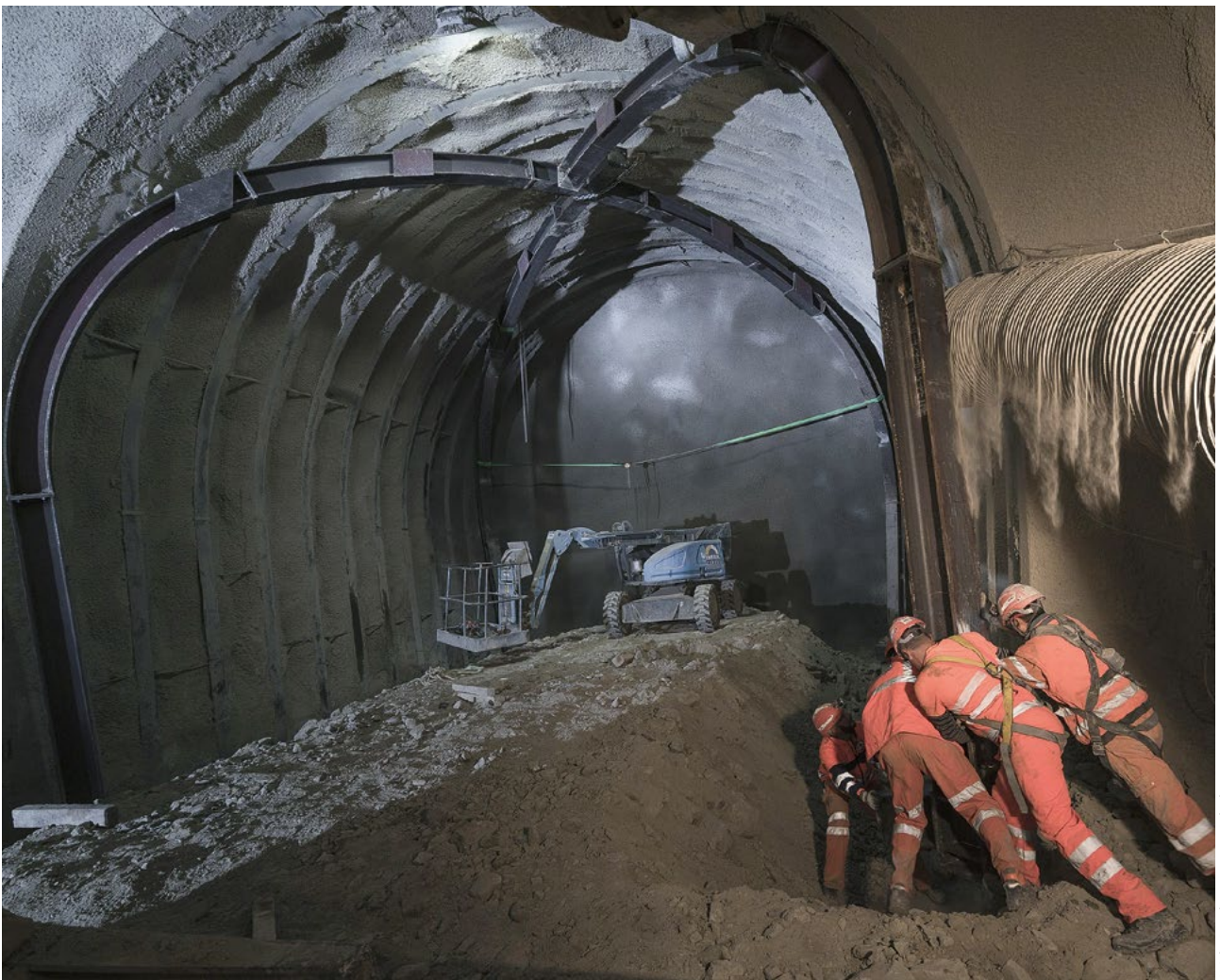
5 Mise en place des cintres métalliques formant l'ogive Implementation of the metal arches forming the ogive
