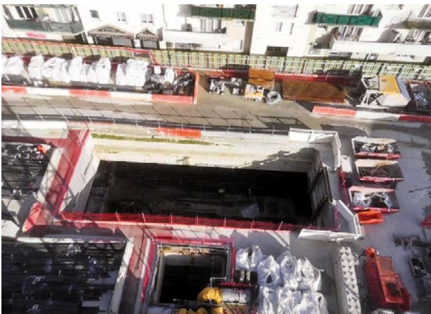
10 Station «Serge Gainsbourg» mit Deckel und Hauptöffnung zur Demontage der TVM “Serge Gainsbourg” station with cover and main opening for dismantling of the TBM
