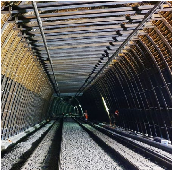
23 Bestehender RBS-Schanzentunnel – Verstärkung mit Stahlbögen Existing RBS Schanzentunnel – reinforcement with steel arches
