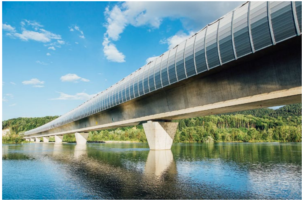
5 Drauquerung im Taktschiebeverfahren Drau river crossing – incremental launch method
