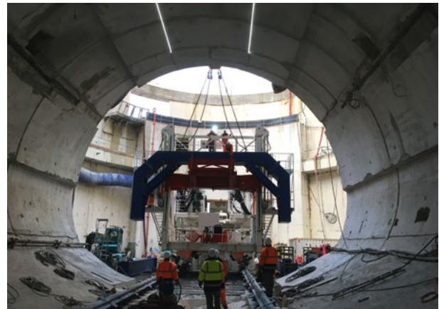
8 Startschacht, Montage Rückstife mit selbst entwickeltem Hebegerät Starting Shaft, Assembly of Thrust Frame with special developed lifting device
