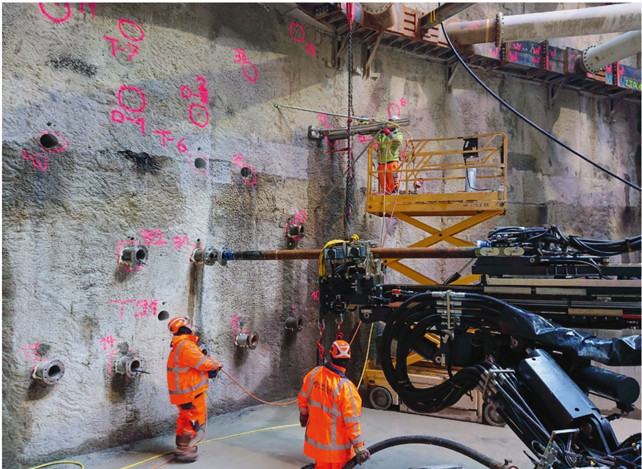
12 Stollen Laupenstrasse – Bohrarbeiten für die Gefriermassnahme Laupenstrasse Tunnel – drilling works for ground freezing
