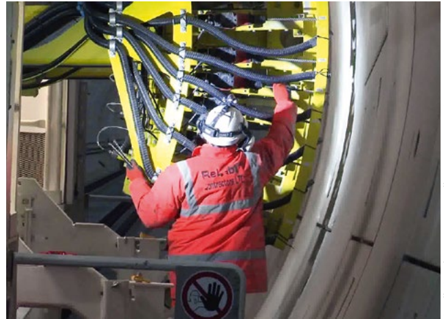
6 Crossrail C610: Umsetzen des selbstfahrenden Bohrwagens (links); Bohrstaub wird direkt an jedem Bohrloch abgesaugt (rechts) Crossrail C610: Relocation of the self-driven drilling jumbo (left); drilling dust is suctioned off directly at each borehole (right)
