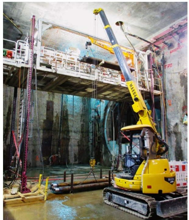
13 Richtbohranlage auf ihrer Hubarbeitsbühne Directional drilling system on work platform
