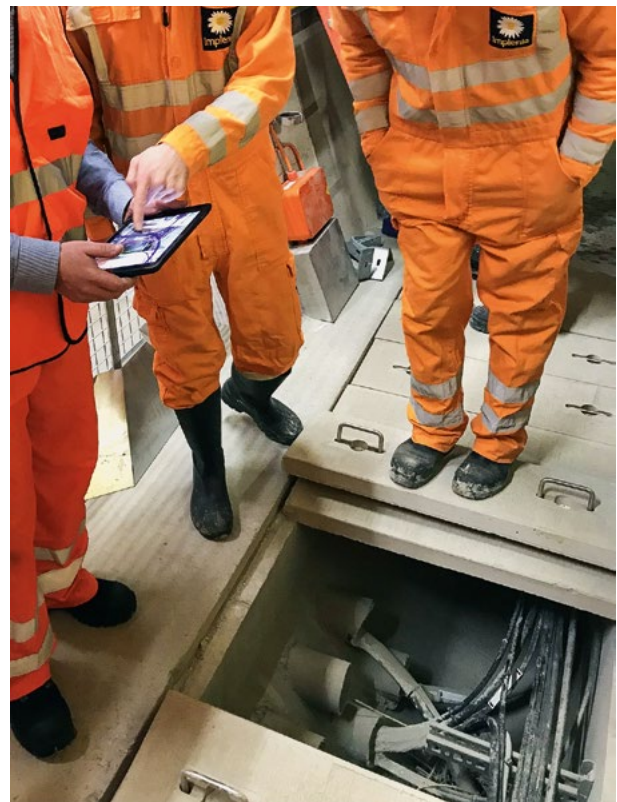
10 AR-Anwendung auf der Baustelle AR application on the construction site
