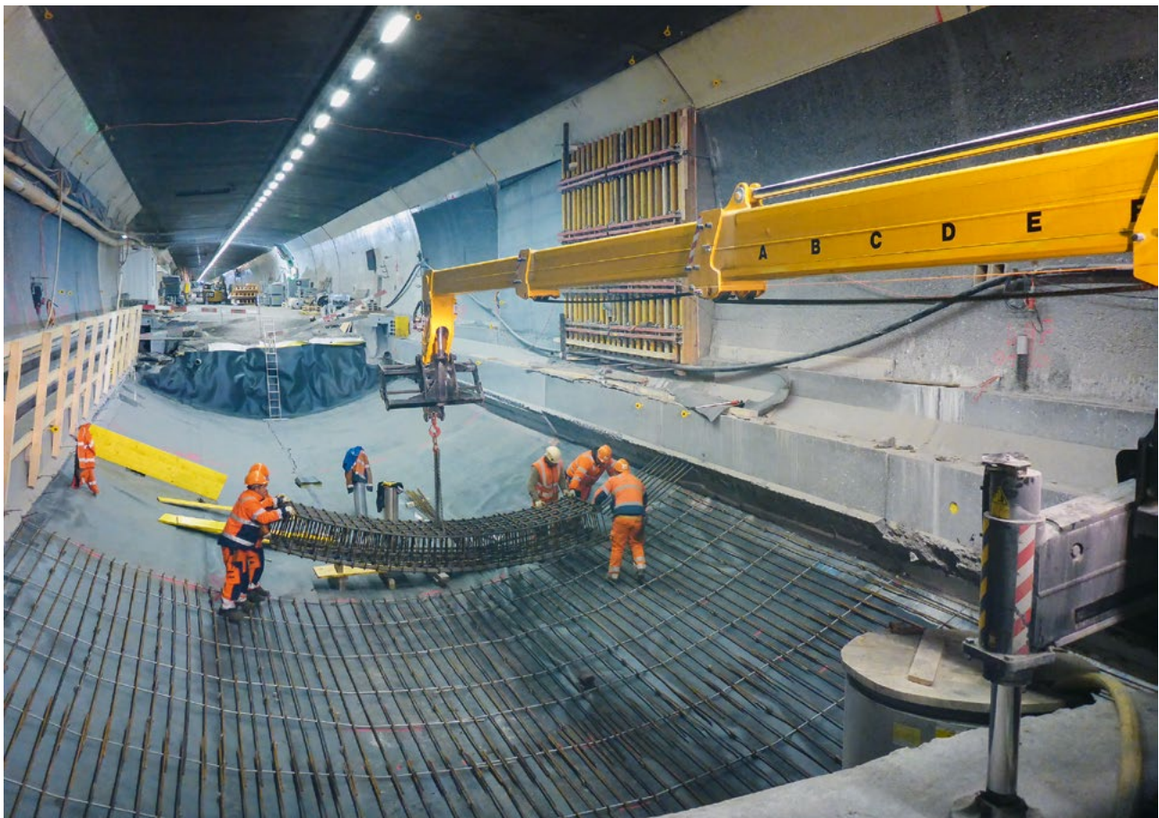
4 Verlegen der vorgefertigten Armierungskörbe im Sohlgewölbe Laying the pre-manufactured reinforcement cages in the invert
