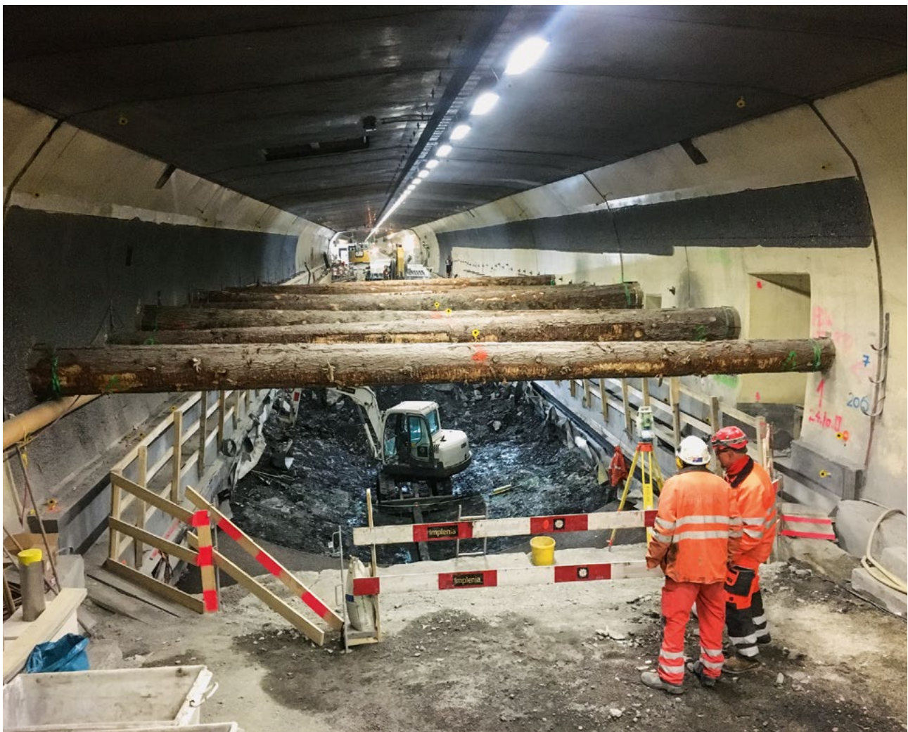
6 Horizontalspriessung mittels Holzstämmen Horizontal bracing using tree trunks
