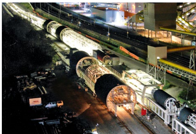
4 Wurm am Installationsplatz Bodio des Gotthard-Basistunnels (links); Arbeitsbereich Gewölbeabdichtung (rechts) Worm at the Bodio installation location of the Gotthard Base Tunnel (left); vault-seal work area (right)
