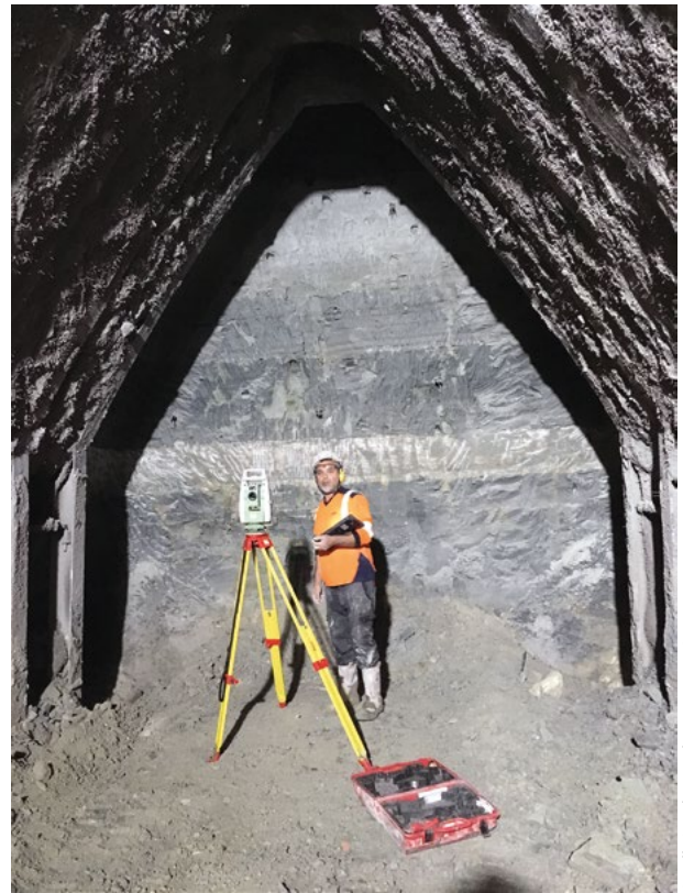
17 Profilkontrolle Profile check
