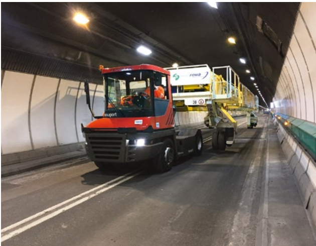
10 Einfahrt des Portalkrans als Anhänger hinter einer Terminal-Zugmaschine (links); einsatzbereiter Portalkran mit ausgefahrenen Abstützungen (rechts)
