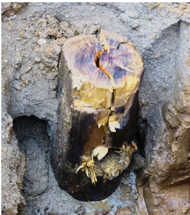
17 Original-Gründungspfahl, im Test durchbohrt Original foundation pile, drilled through in test
