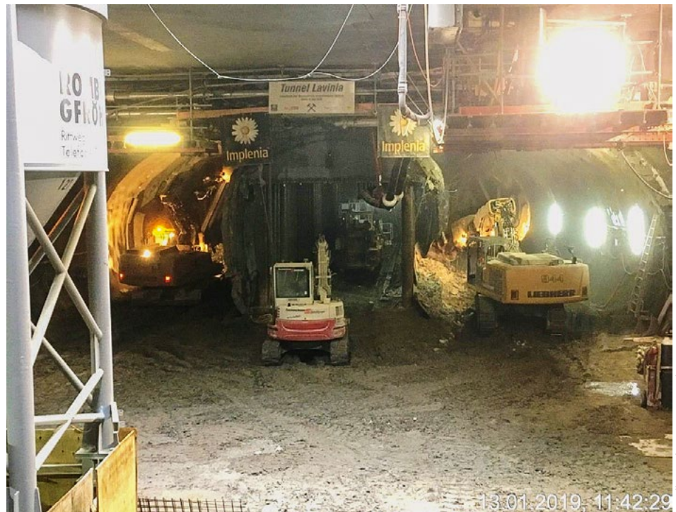
23 Vortrieb der Bahnsteighalle im gefrorenen Boden unter dem Spreekanal Platform hall excavation in frozen ground under the Spree Canal
