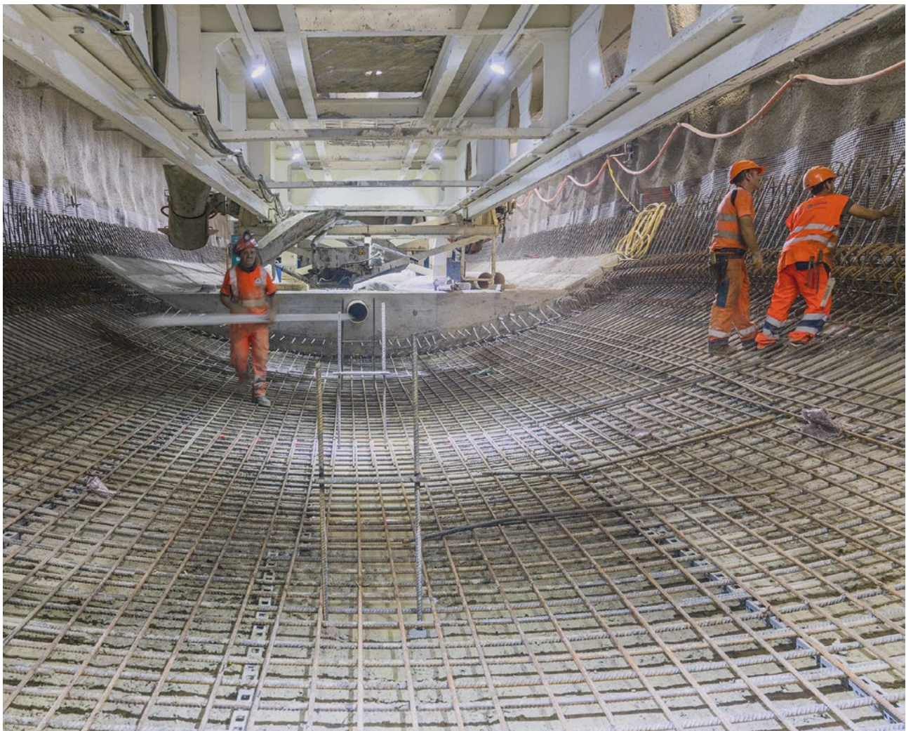
7 Ferrailage du radier contre-voûté sous le pont de franchissement Reinforcement of the invert under the bridge
