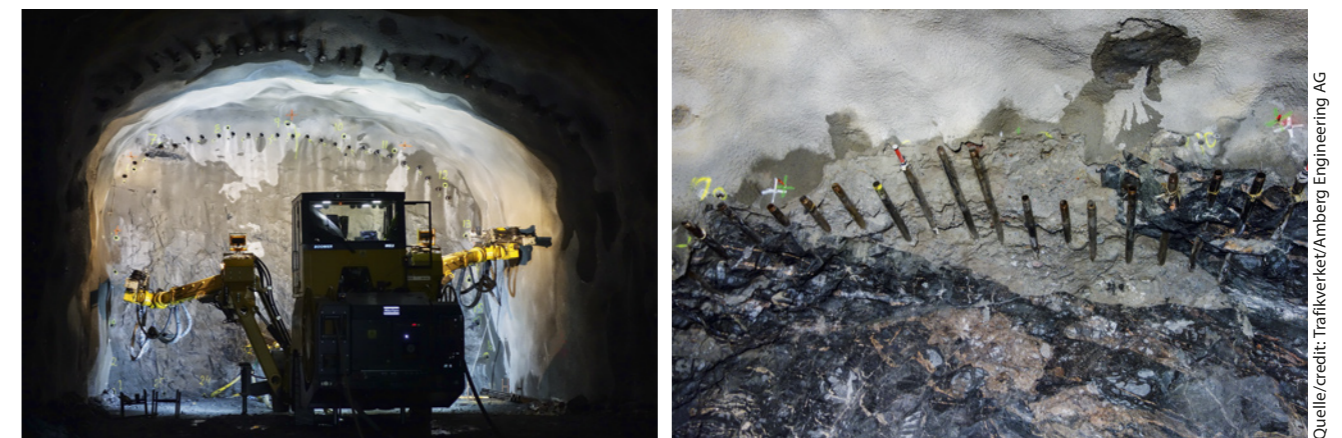
10 Bohren des Rohrschirms und des Jetgrouting-Körpers in der Ortsbrust der Rampe 412 Drilling the pipe roof umbrella and the jet grouting body at the work face of ramp 412
