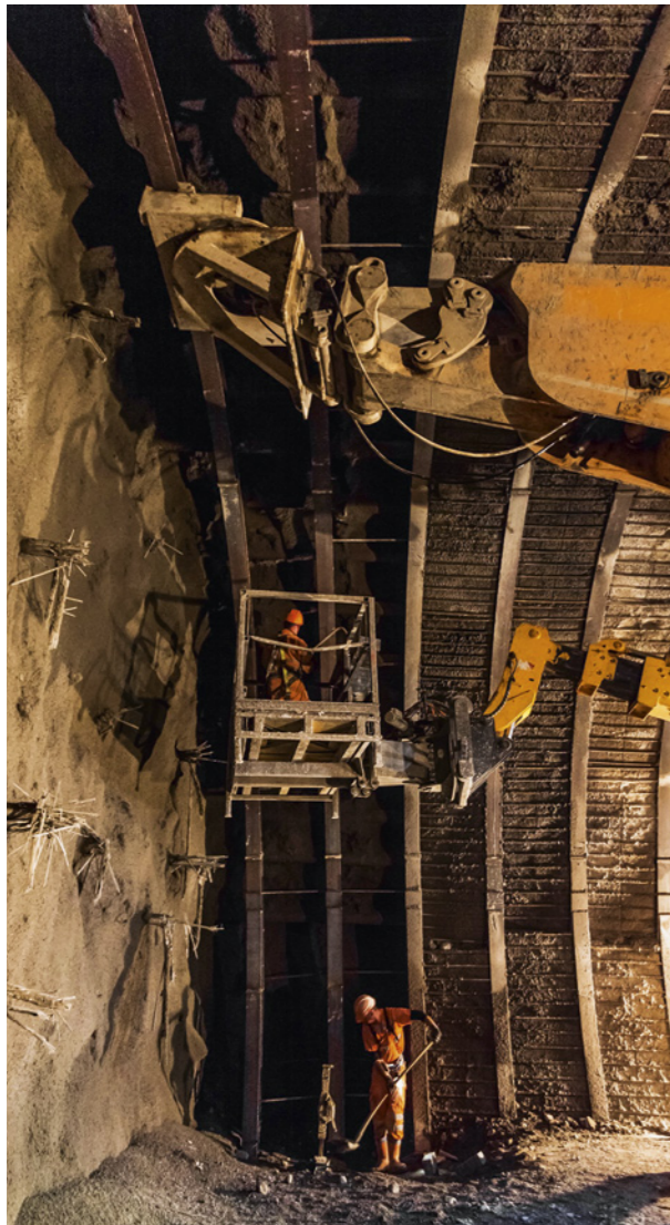
9 Travaux de soutènement Reinforcement works
