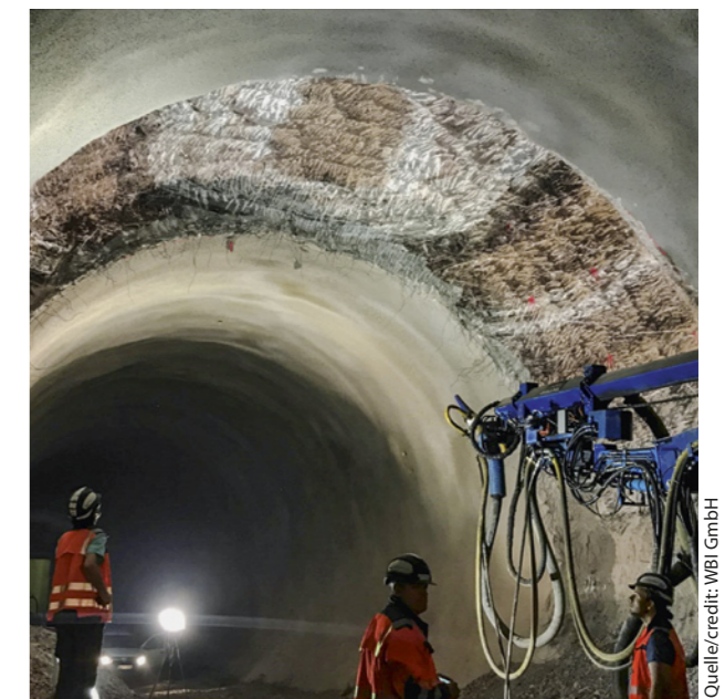
14 Herstellung eines Dammrings Construction of a shotcrete sealing ring
