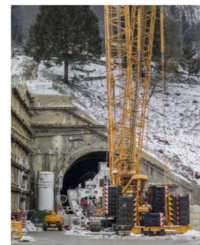
10 Montage der TBM im Voreinschnitt Schinznach Assembling the TBM in the Schinznach cutting
