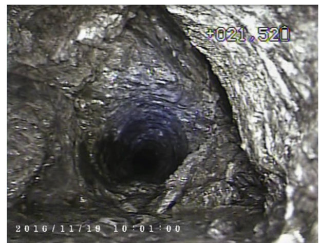
7 Kamerabefahrung Camera inspection
