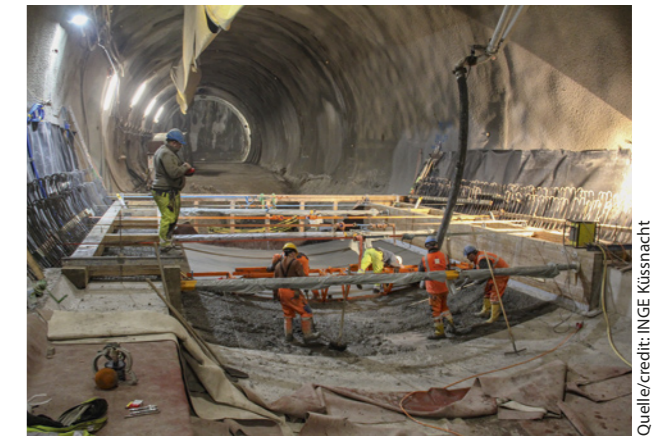
10 Betonage der Sohle während des eingestellten Vortriebs
