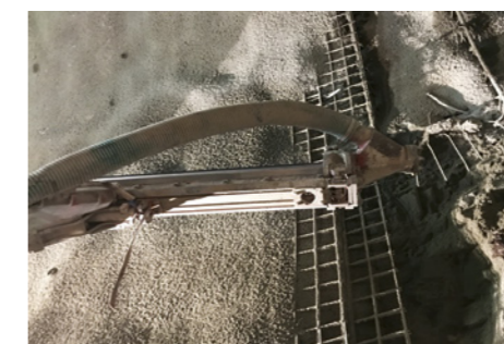
a. Absaugung Staub am Bohrlochmund
