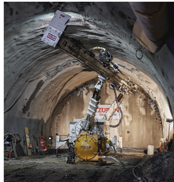
12 Lafettenbohrgerät zur Erstellung von verrohrten Bohrungen und Jettingsäulen Drilling rig for creating cased boreholes and jet-grouting columns
