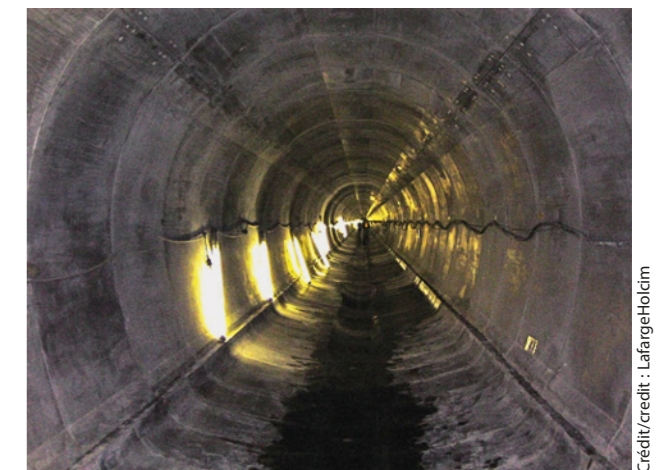
3 a-b Galerie d'évacuation d'eau avant/après réfection avec du BFUP préfabriqué – Tunnel d'irrigation Shin-yahagigawa – Japon Water disposal tunnel before/after repair with precast UHPC – Shin-yahagigawa irrigation tunnel – Japan
