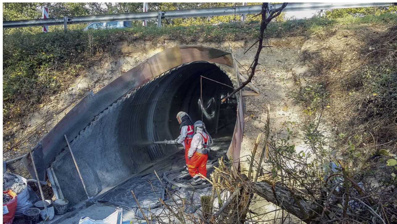
4 Réfection d'un conduit métallique Repair of a metal culvert
