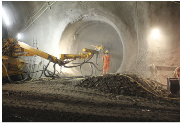
9 Sicherung der Querverbindung zum Fluchtstollen. Der Vortrieb erfolgte im Schutz eines Spiessschirms
