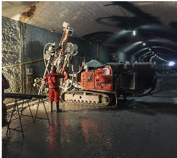
12 Ausführung Jettingarbeiten (Baugrundverbesserung unter Mittelwand) Performance of jet-grouting work (improvement of ground under the centre wall)
