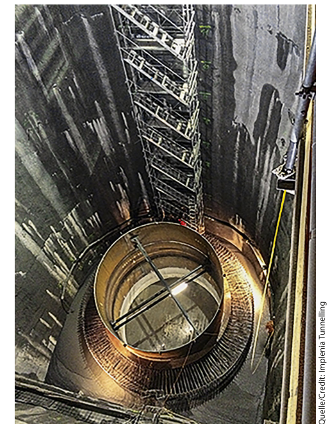
12 Pumpspeicherkraftwerk Nant de Drance, 2014 Nant de Drance pumped-storage power plant, 2014
