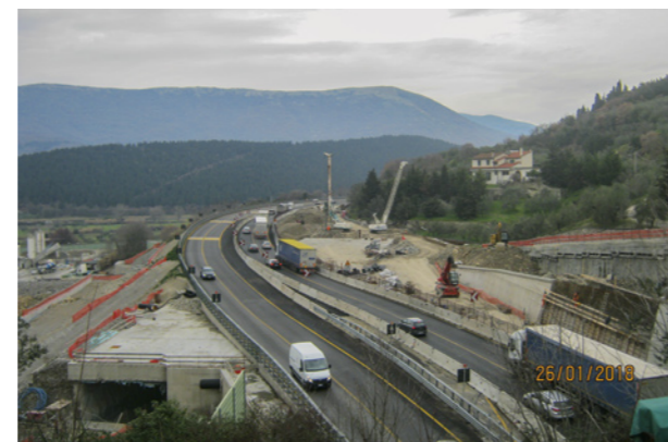
4 Deviazione e realizzazione dei pali nella tratta nord
