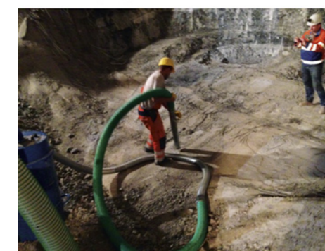
c. Reinigen der Sohle durch Absaugen
