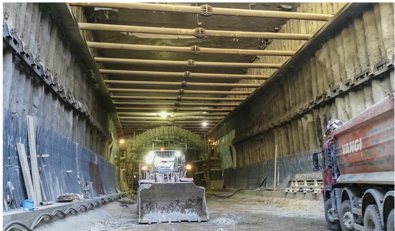
5 Realizzazione della galleria policentrica tra le paratie, sotto il solettone Construction of the polycentric tunnel between the walls, under the slab
