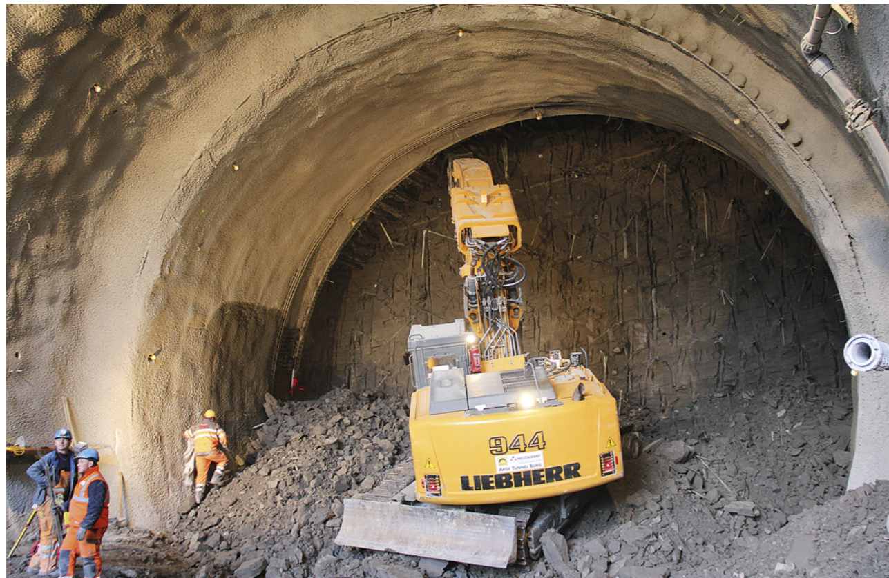
7 Vollausbruch mit abgetrepter Ortsbrust mittels Tunnelbagger. Die Arbeitshöhe war mit herkömmlichem Gerät noch zu bewältigen. Full excavation with stepped working face using tunnel excavator; the working height was yet to be overcome with conventional equipment
