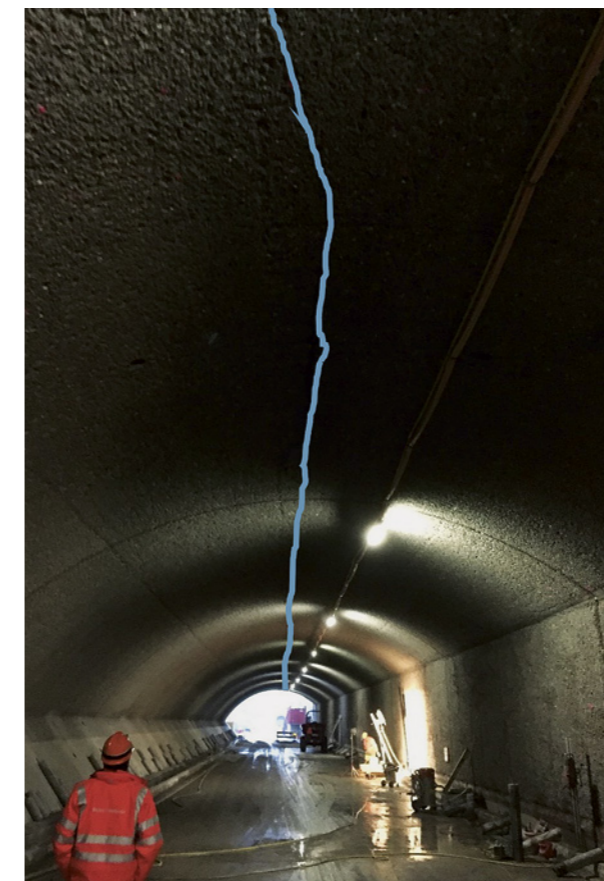
8a/b Riss im First (blau hervorgehoben)/Kernbohrung (Firstbereich, mit Hüllrohr) Crack in the roof (emphasised in blue)/drilling core (roof area, showing electrical conduit)
