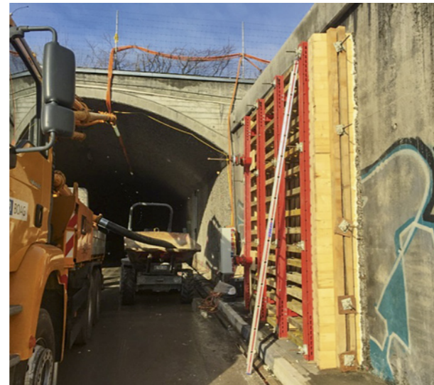
13 Vorversuch SCC-Vorbeton (Mittelwand beziehungsweise Antirezirkulationswand) Preliminary testing, in situ SCC concrete (centre wall / anti-recirculation wall)
