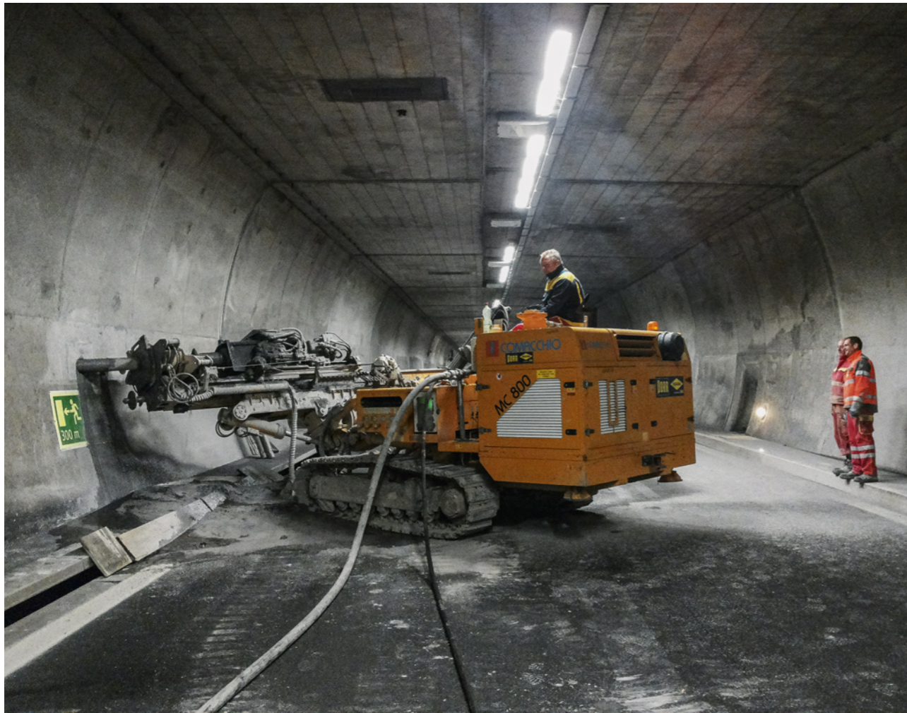
12 Vorauserkundungen ab dem bestehenden Strassentunnel Advance exploration from the existing road tunnel
