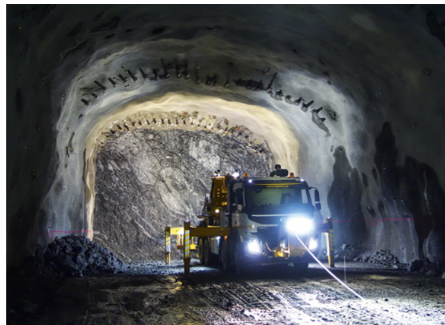
11 Rohrschirm und Jetgrouting in der Ortsbrust der Rampe 411 Pipe roof umbrella and jet grouting at the face of ramp 411
