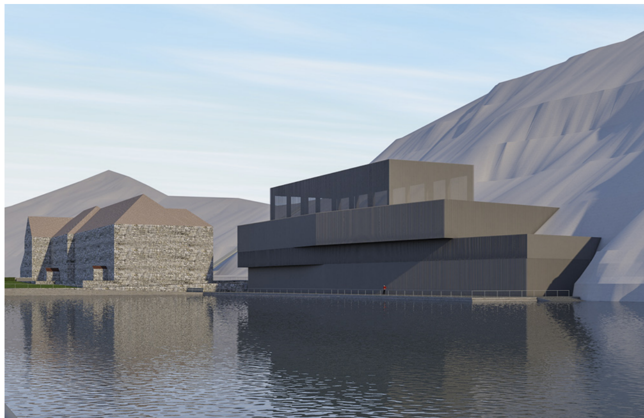
10 Fotomontage der neuen Kraftwerkszentrale Ritom SA Photo composition of the new Ritom SA powerhouse
