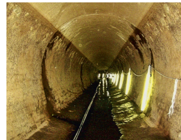
3 a-b Galerie d'évacuation d'eau avant/après réfection avec du BFUP préfabriqué – Tunnel d'irrigation Shin-yahagigawa – Japon Water disposal tunnel before/after repair with precast UHPC – Shin-yahagigawa irrigation tunnel – Japan
