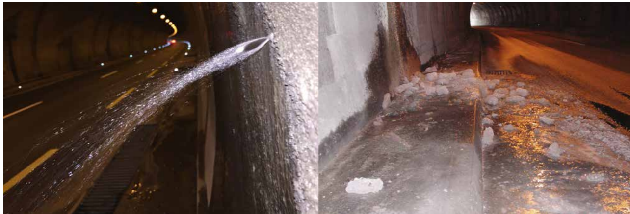
17 Drückendes Wasser und Vereisung im Tunnelinnenraum, Taubenlochschlucht [13] Pressurised water and freezing in the tunnel interior, Taubenlochschlucht [13]
