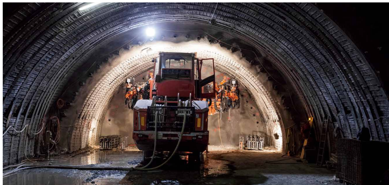
Tunnel de Pinchat
