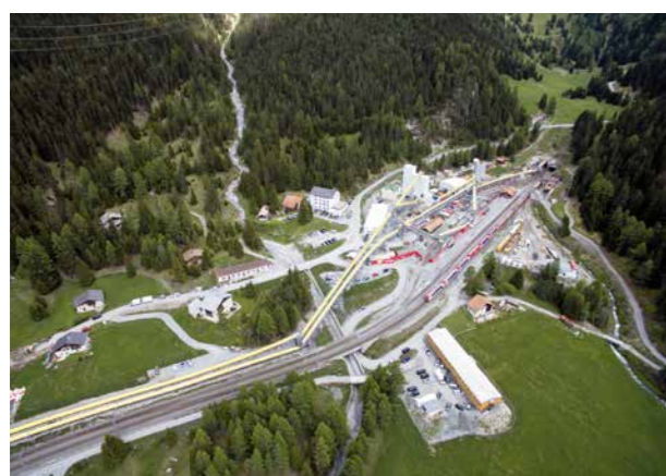
3 Förderbandanlagen Installationsplatz Preda Preda conveyor belt system installation site
