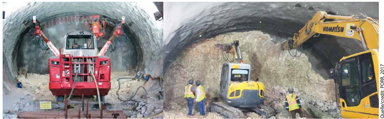
11 Herstellung Rohrschirm (links) und Ausbruch (rechts) Production of pipe umbrella (left) and excavation (right)
