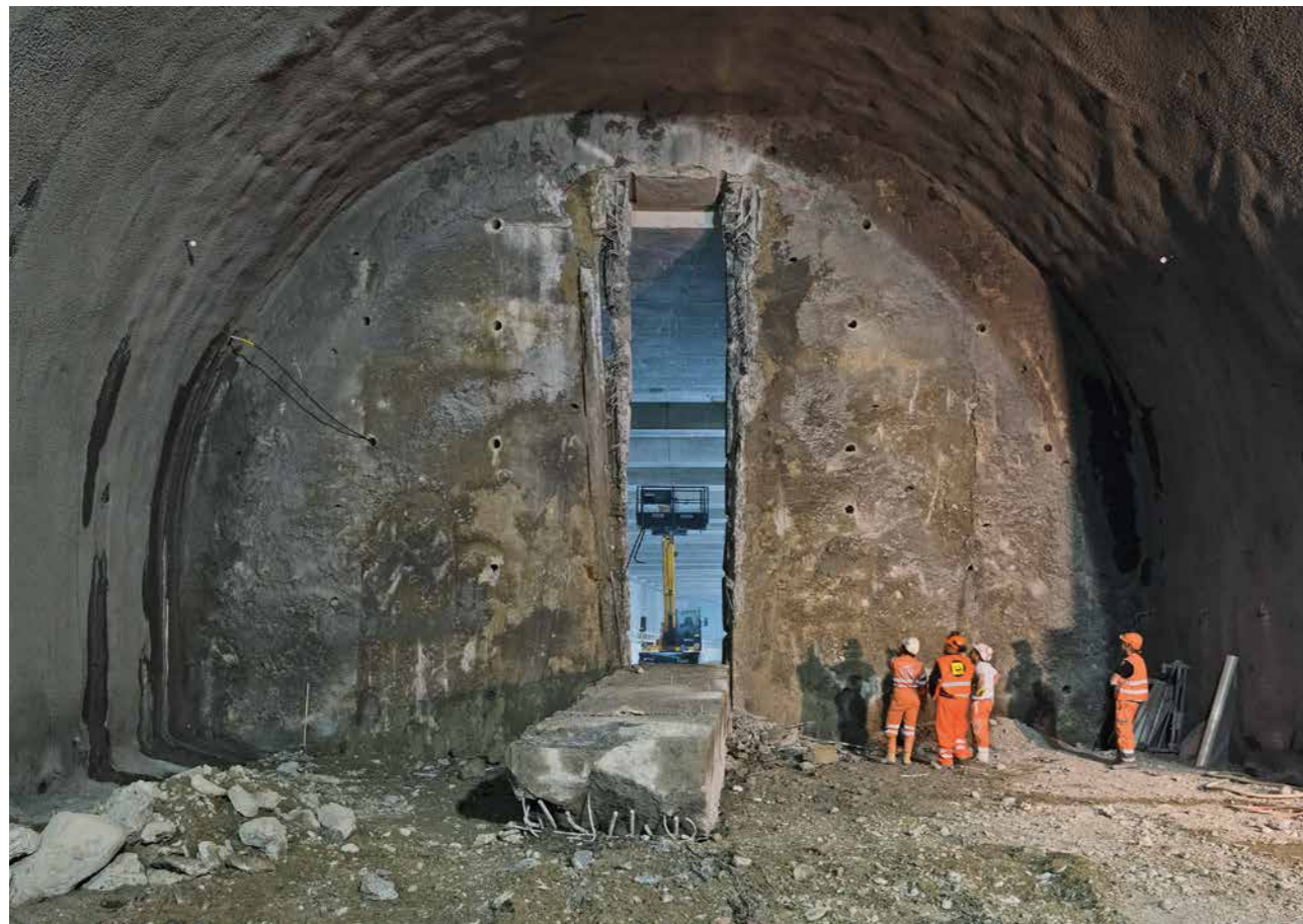
5 Durchschlag zur Haltestelle Champel-Hôpital Breakthrough to Champel-Hôpital station
