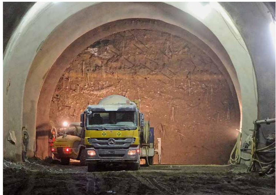
11 Ortsbrustaufnahme in der Zone élargie Face in the élargie zone
