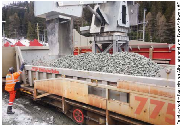
13 Schotterverlad Gravel load
