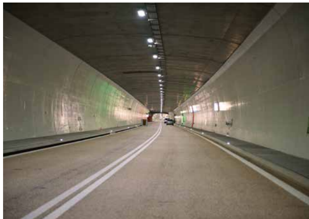
5 Tunnel Lungern mit LED, hellem Belag und weissen Wänden Lungern tunnel with LEDs, light pavement and white walls
