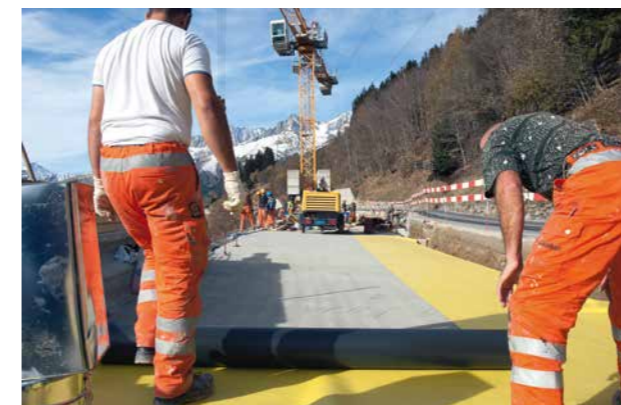
4 Tagbautunnel – Verkleben der Membrane Cut-and-cover tunnel – bonding the membrane
