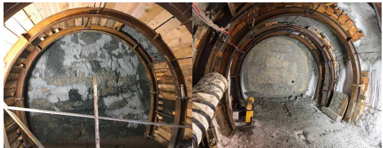
6 Photos des deux galeries traitées par jet-grouting (à gauche) et par congélation (à droite) Pictures of the two tunnels treated by jet-grouting (left) and freezing (right)
