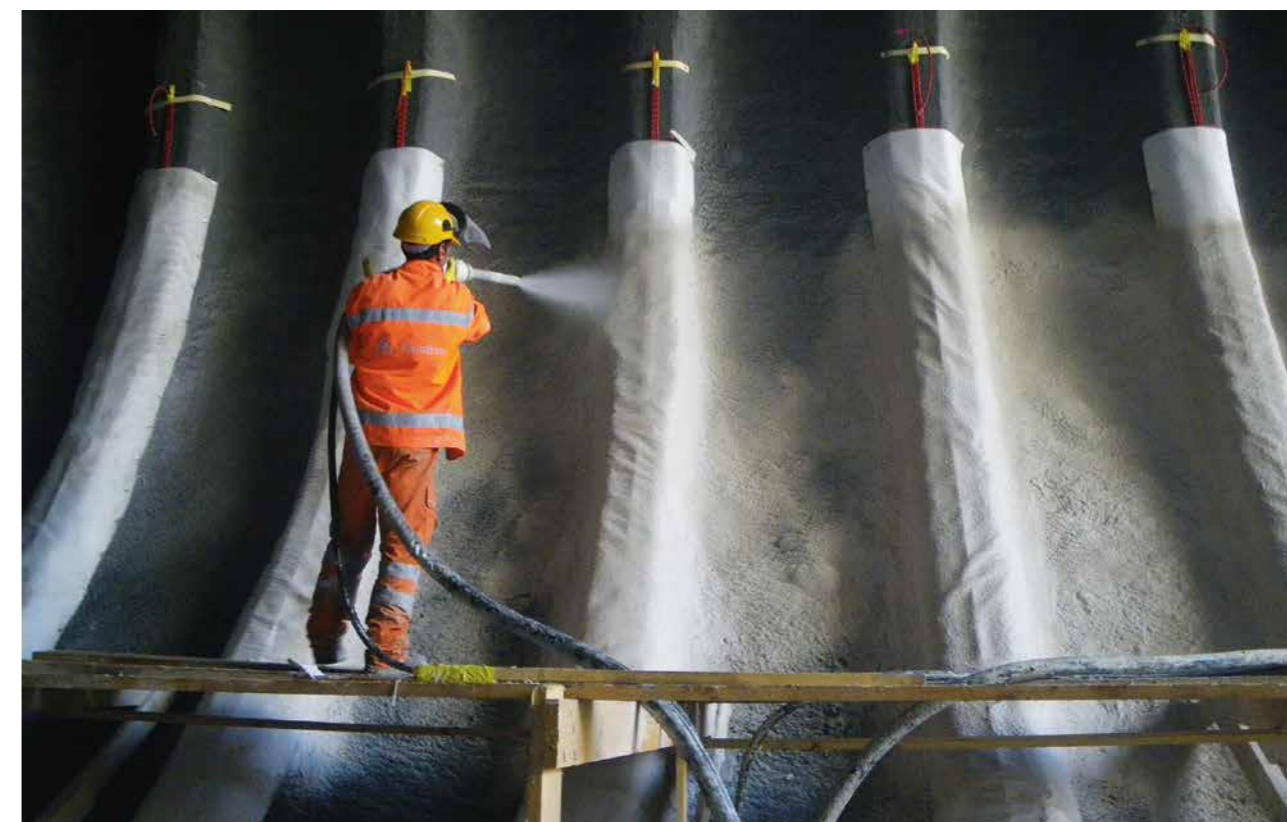
6 Spritzabdichtung und Injektionsschläuche im Bereich Stahleinbau Spray-on sealing and grouting hoses in steel installation area
