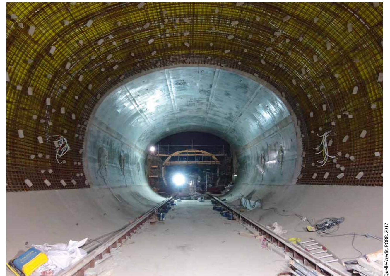
12 Innenschale Strassenunterführung Inner lining of underpass
