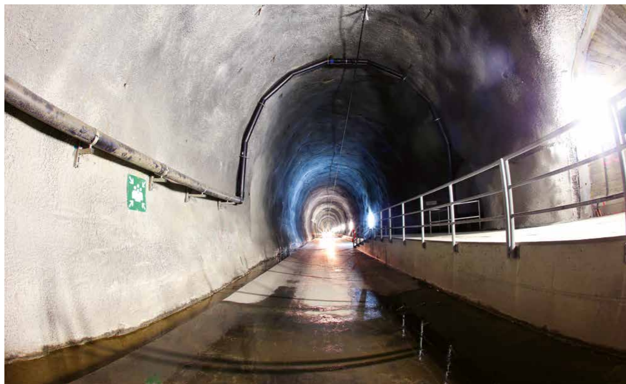
10 Rohbautunnel West mit Fluchtrampe aus einer Querverbindung The unfinished west tunnel with an escape ramp from a cross passage
