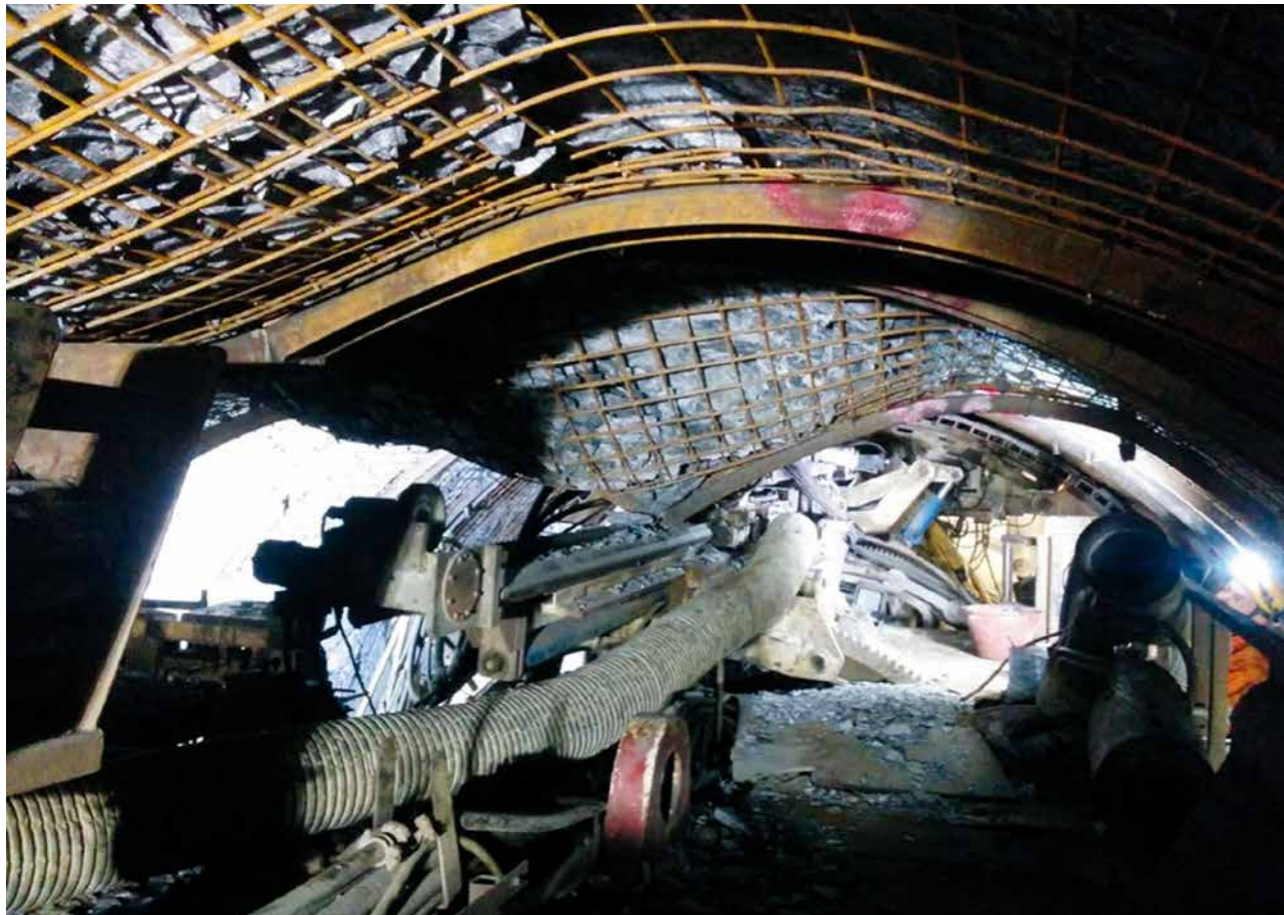
11 Evento di rottura fragile verificatosi alla progressiva metrica 4'200 circa. Brittle fracture event which occurred at approx. metre 4,200
