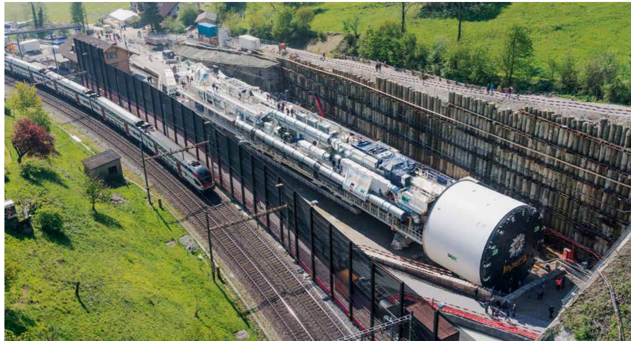
9 Flugaufnahme fertig montierte TBM Aerial view of assembled TBM
