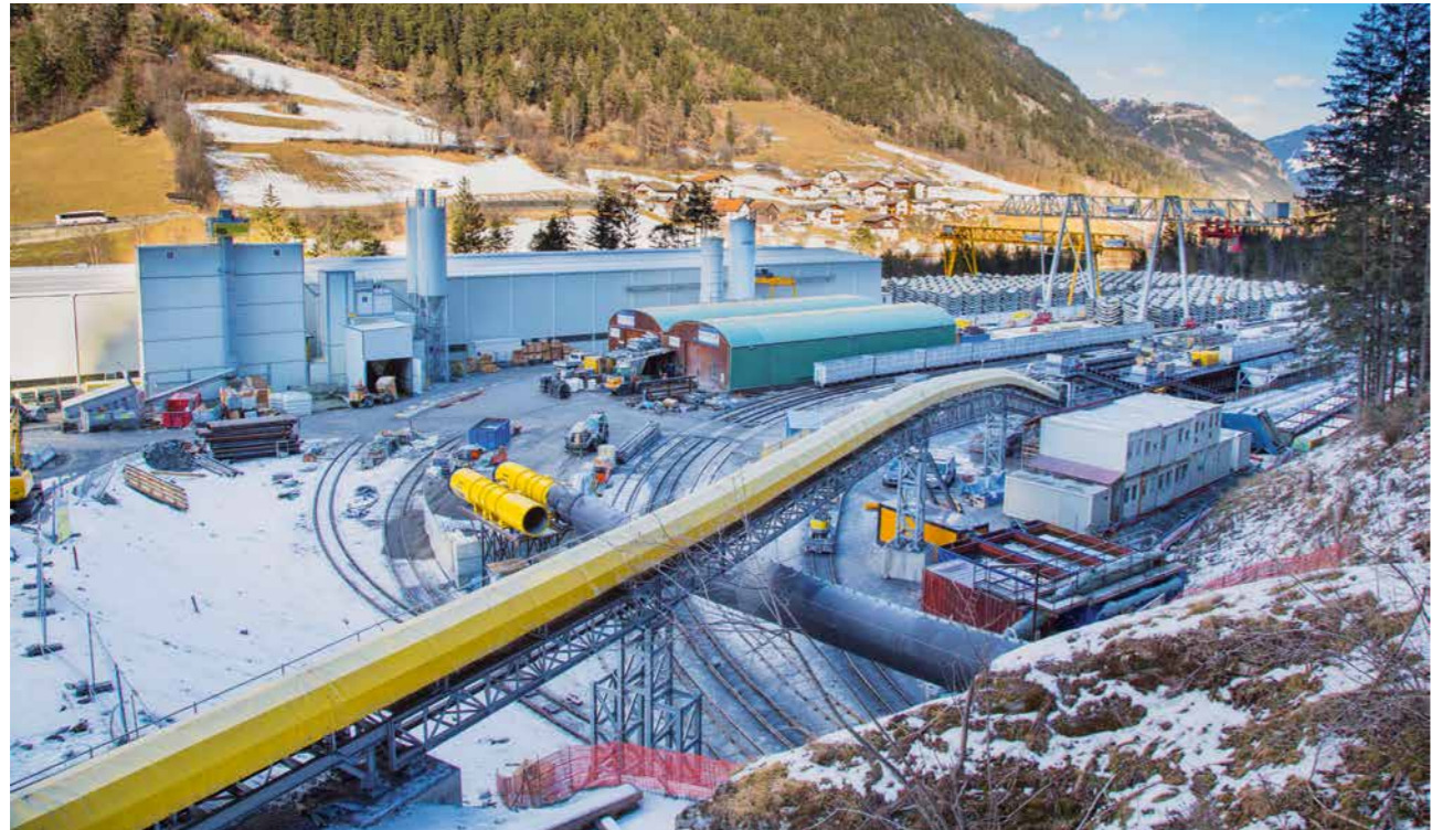
4 Baustelleneinrichtungsfäche Maria Stein Construction site equipment area at Maria Stein
