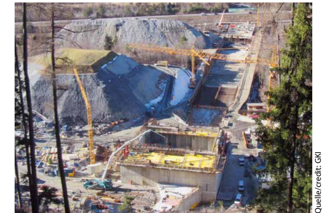
3 Übersicht Krafthaus mit UW-Kanal Overview of the powerhouse with its tailrace channel
