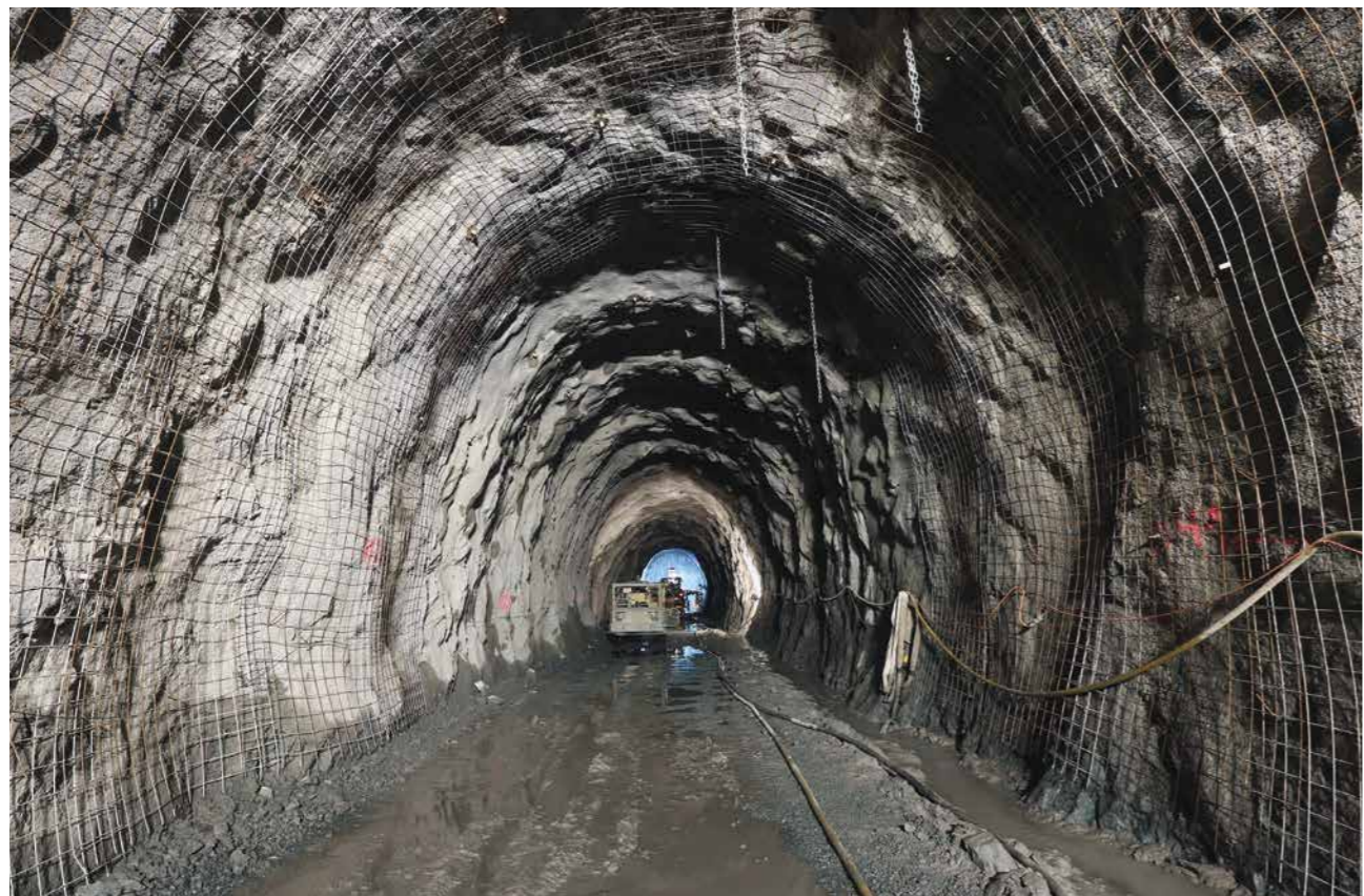
11 Sprengvortrieb Spinas Spinas blasting
