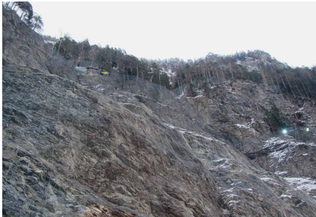
2 Gesicherte Felsflanke oberhalb des Wehrs Stabilised rock face above the weir
