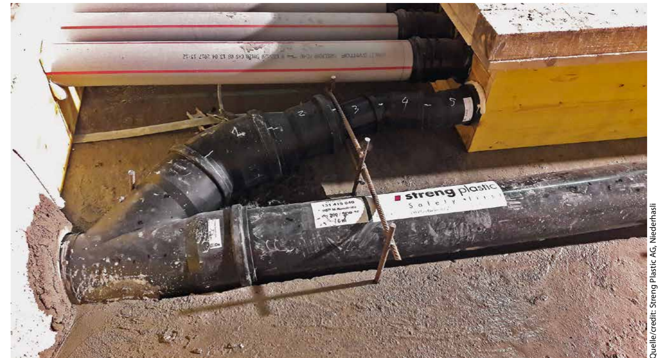
9 Schachtanschluss im Tunnel Shaft connection in tunnel
