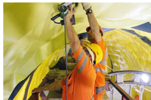
11 Maschinenschweissung (Fügen) im Tunnel Machine welding (joining) in tunnel
