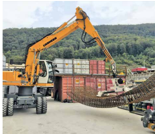
12 Sohlgewölbe, mobiles Versetzgerät für die Bewehrungskörbe Invert duct, mobile movement device for reinforcement cages
