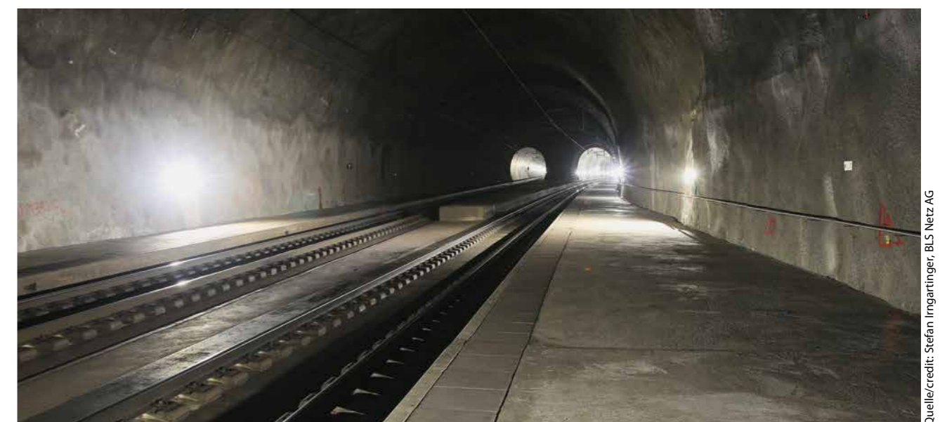
6 Bestehende Spurwechselkaverne Ferden Nordost mit Schnellfahrweiche im Bahntunnel Ost Existing track change cavern at Ferden north-east with high-speed point in the east railway tunnel
