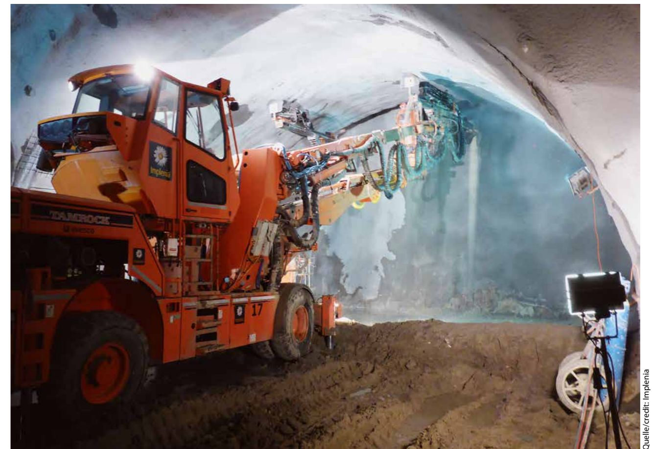
5 Bohren Rohrschirm Pipe roofing
