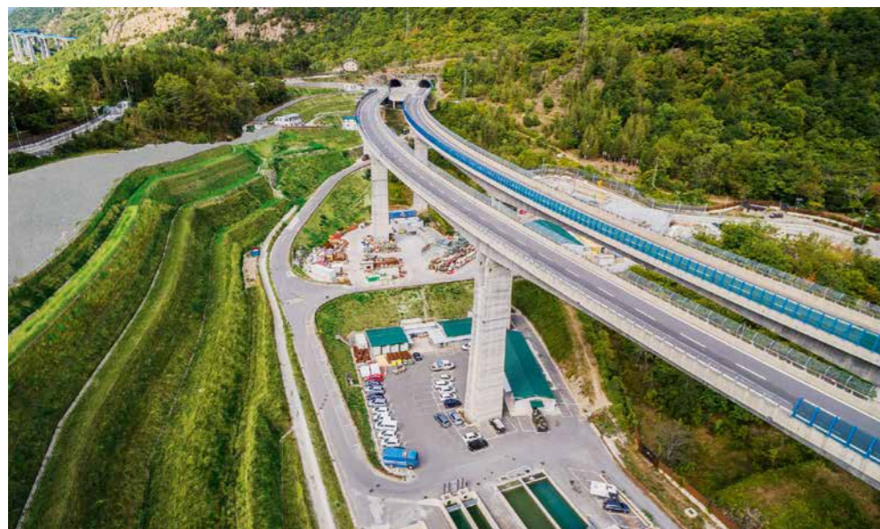
6 Area di cantiere, sulla sinistra il sito di deposito terrazzato Site areas, on the left the terraced deposition site
