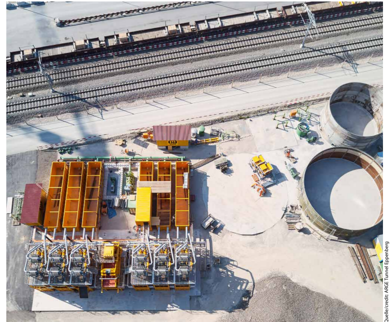
11 Separationsanlage im Aufbau The separation plant being set up
