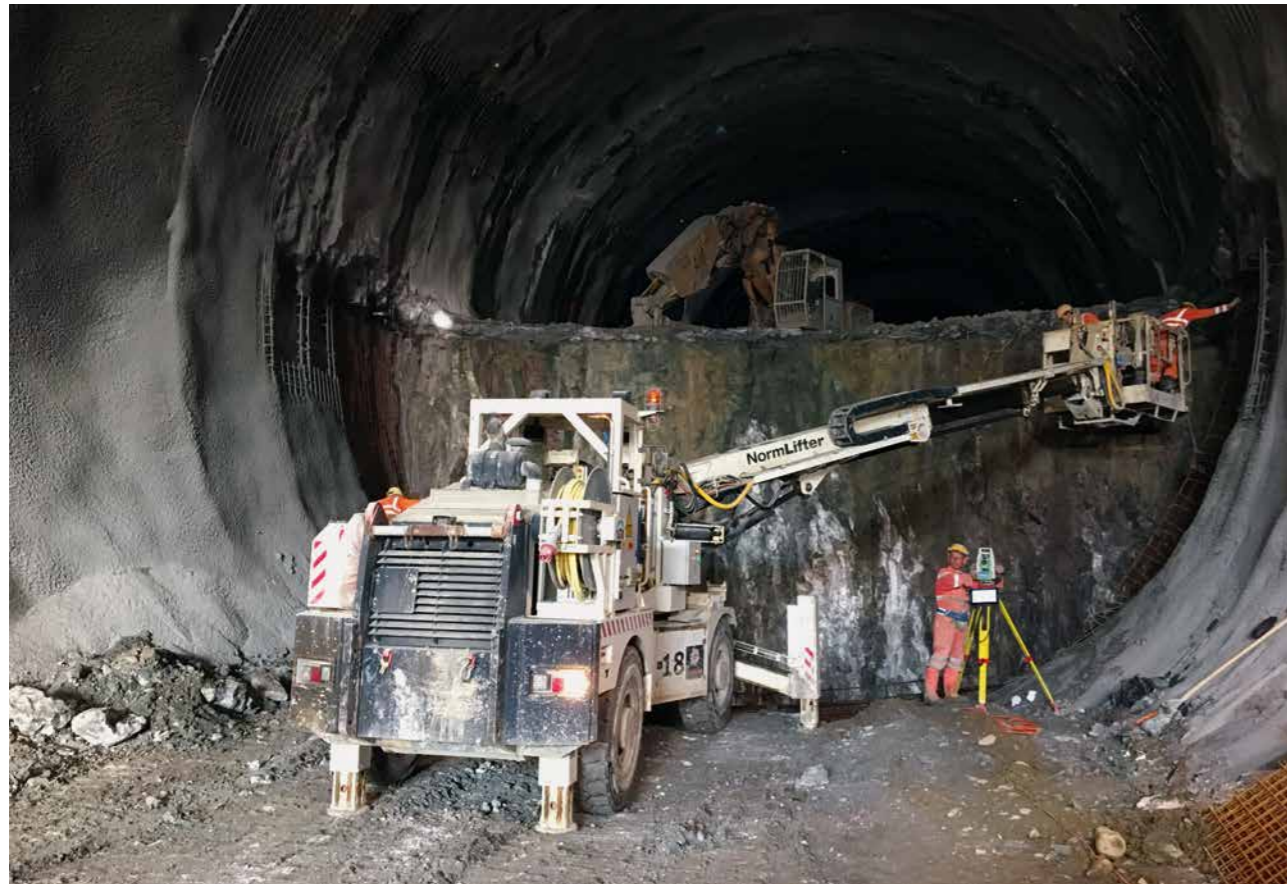
6 Einbau Sicherung Strosse und Sohle Bench and floor stabilisation installation
