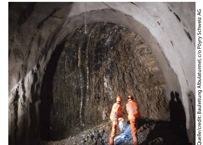
7 Vortrieb Allgäuschiefer Allgäu Schist drive
