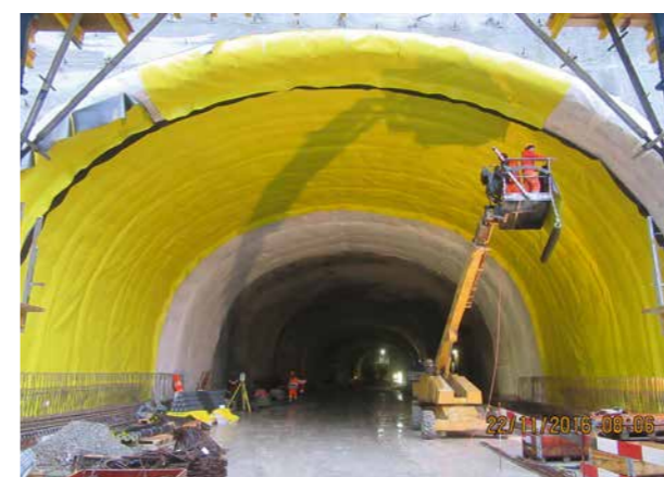
15 Abdichtung im Tunnel Stalvedro [11] Stalvedro Tunnel sealing [11]
