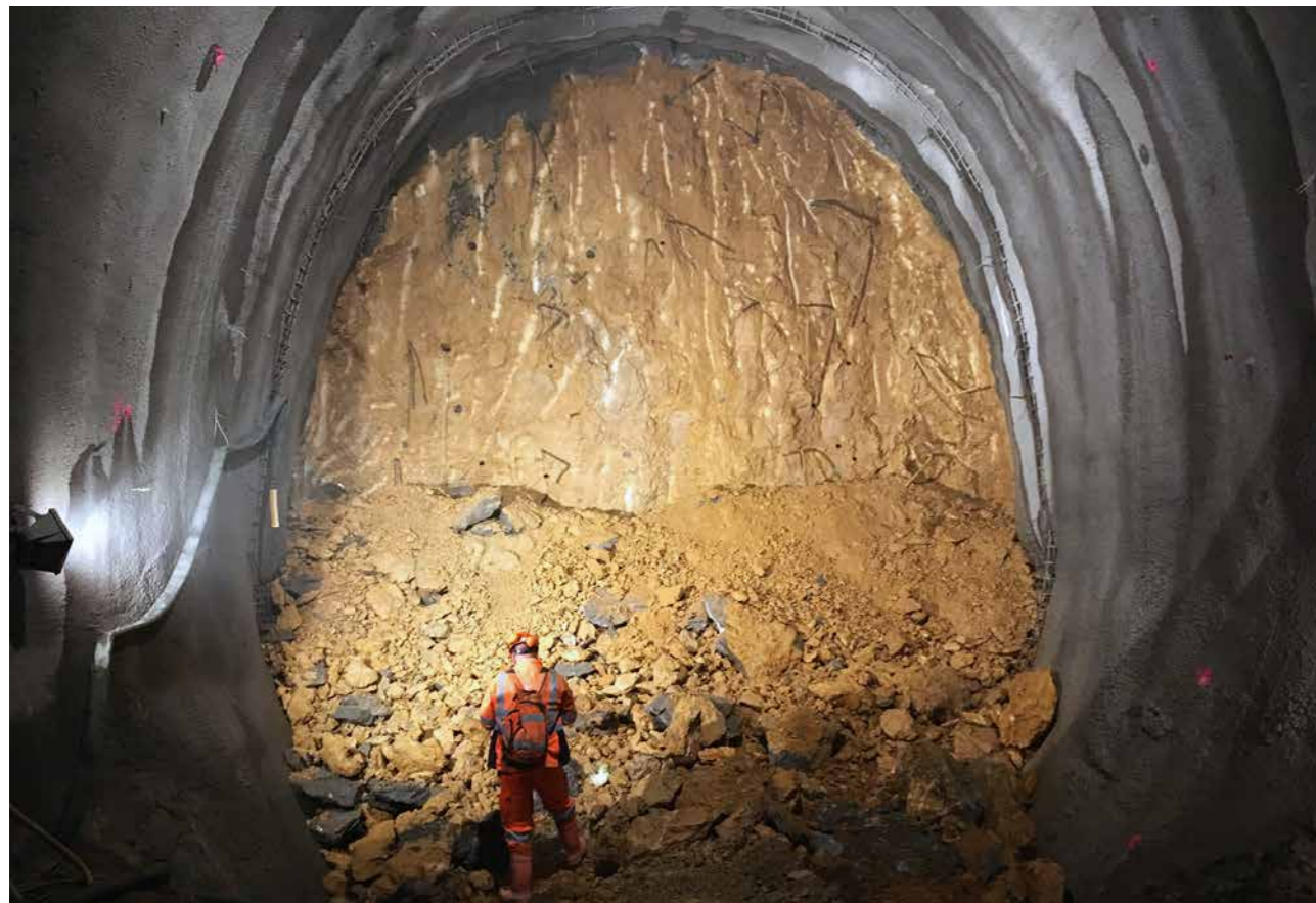
9 Vortrieb Rauwacke Rauwacke drive
