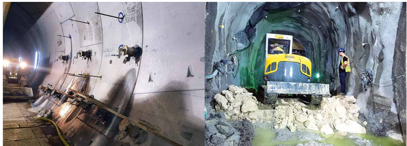
7 Vortriebsarbeiten Querschlag Cross passage excavation
