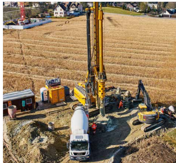
10 Erstellen der Bohrpfahlwand für den Umbau der TBM unter Tage Making the bored pile wall to convert the TBM underground
