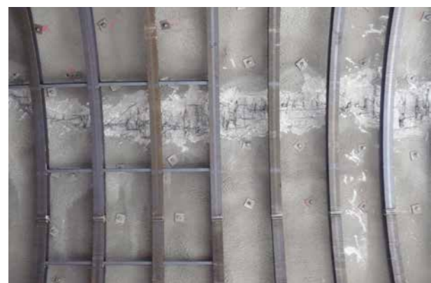
5 Stahleinbau im konventionellen Vortrieb Steel installation in conventional tunnelling
