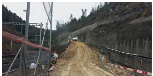
15 Arbeiten Bahnhofstrasse und Abteufen Voreinschnitt Effingen Work on Bahnhofstrasse and sinking of the pre-cut at Effingen
