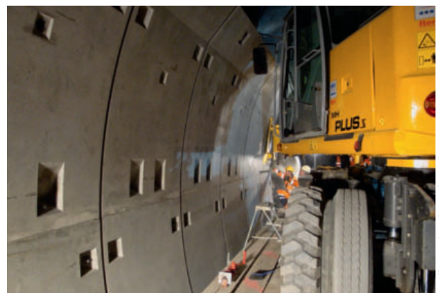
1 Versetzen der Fertigteilelemente im Versuchsstollen Hagerbach (VSH, Flums)
