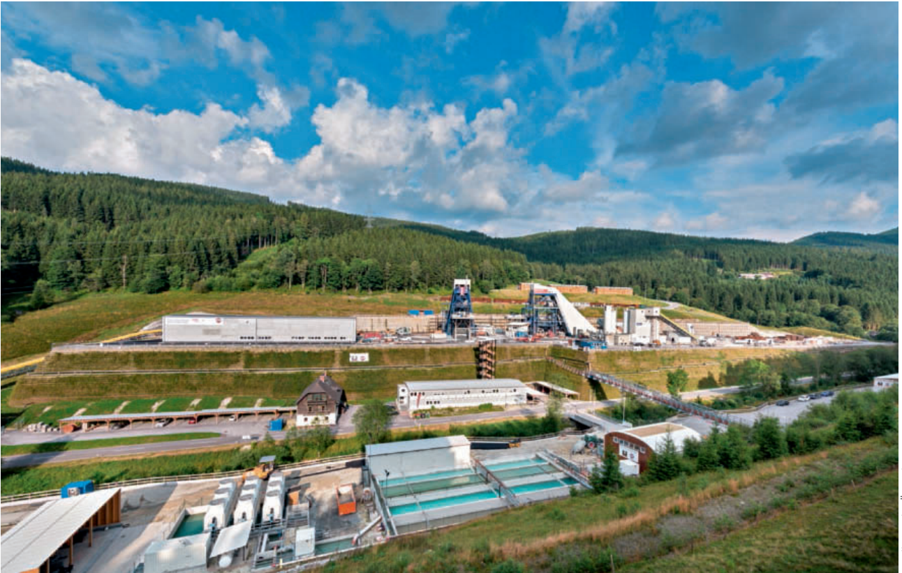
3 Blick auf die BE-Flächen West (Vordergrund) und Ost (Hintergrund) sowie auf das Förderband zur Deponie (gelb) View of the SI area west (foreground) and east (background) as well as the conveyor belt to the landfill (yellow)
