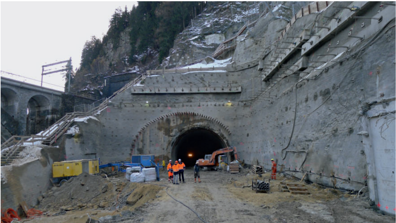
7 Voreinschnitt Nord nach erfolgtem Abbruch des alten Tagbautunnels Pre-cut in the north section following excavation of the old cut-and-cover tunnel
