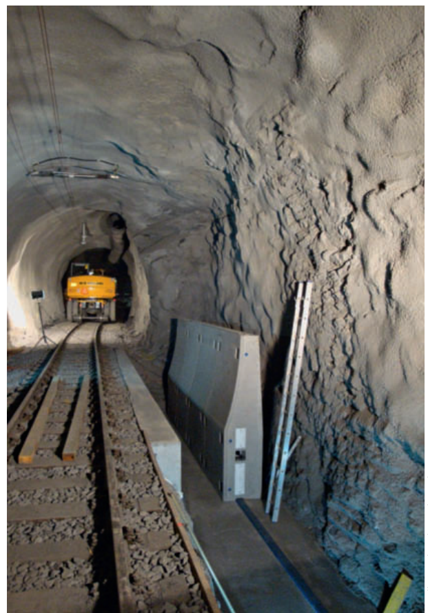
10 Teststollen RhB im Versuchsstollen Hagerbach RhB test tunnel in the Hagerbach test gallery
