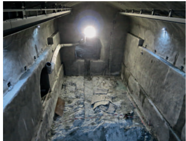
5 Ausgebrochene, gesicherte und verkleidete Nebenkaverne in Innertkirchen
