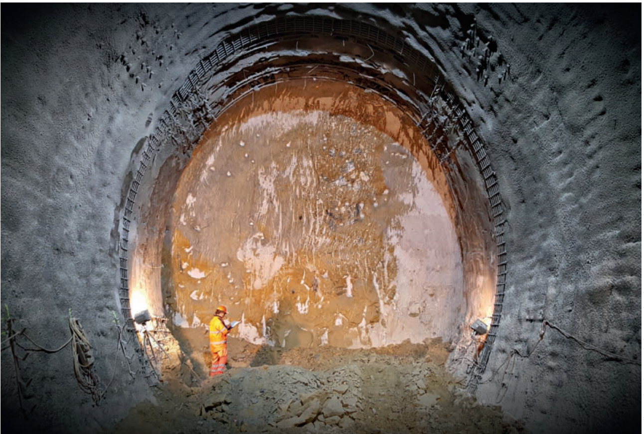
11 Vortrieb im Gefrierkörper (Abschnitt III der Raibler Rauwacke) Excavation through frozen ground (section III of the Raibler-Rauwacke)
