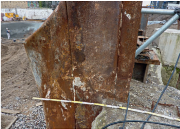
8 Ausgeführte Fuge 1500 mm/1000 mm Completed joint 1,500 mm/1,000 mm
