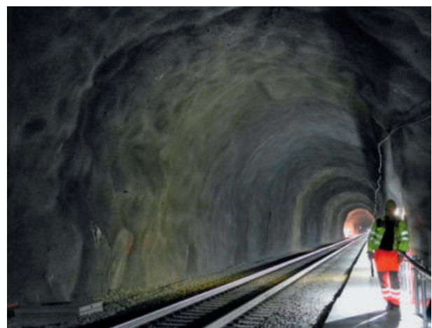
3 Spritzbetonschale mit aufgespritzter Dichtungsmembran. Links: Querschnitt eines wasserdichten Auskleidungssystems in Wänden und Firste. Rechts: Aufnahme des fertiggestellten Gevingås-Schiementunnels, Norwegen (2011)
