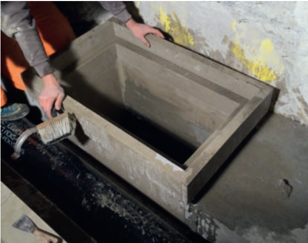
12 Bergwasserschacht mit Polymerbetonabdeckung, Sanierung Rugentunnel Water shaft with polymer concrete cover, Rugen tunnel renovation
