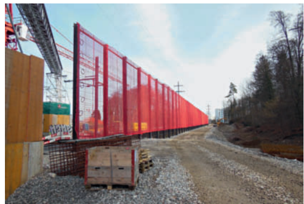
12 Stand der Arbeiten (März 2017), Verladebahnhof, Erstellung Schutzgerüst Current state of work (March 2017), rail loading terminal, erection of safety scaffolding
