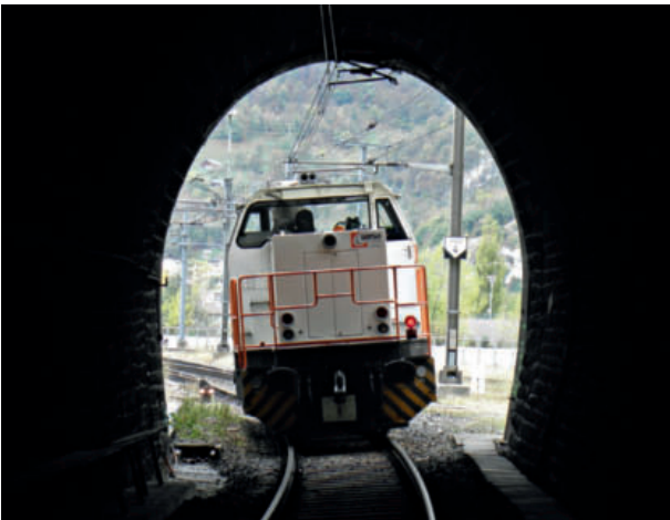
3 Simplontunnel, typisches Tunnelprofil mit gewölbten Paramenten Simplon Tunnel, typical tunnel profile with vaulted side walls
