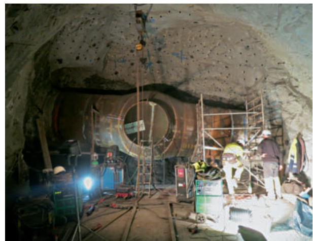
8 In die bestehende Panzerung eingebautes T-Stück der Verbindung Druckschächte Handeck T-piece for the connection of the pressure shafts integrated into the existing steel lining in Handeck
