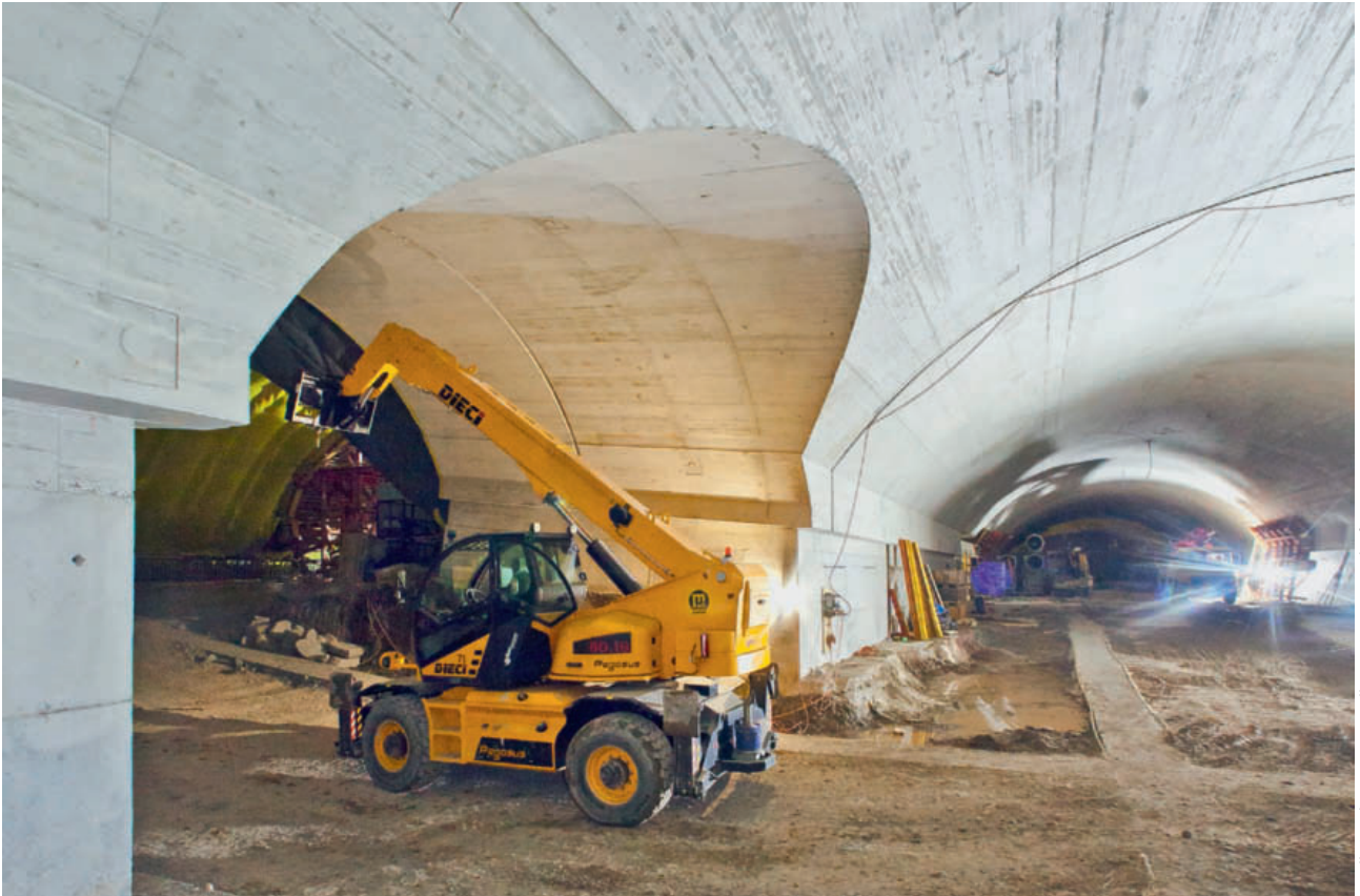
12 SCC-Ortbetongewölbe der Hauptkaverne Obere Hauptgasse im Verschneidungsbereich mit der Querkaverne In-situ SCC vault in the Obere Hauptgasse main cavern at the intersection with the transverse cavern
