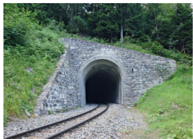
2 Sandgrindtunnel, typisches Tunnelbauwerk mit charakteristischem Hufeisenprofil Sandgrind Tunnel, typical tunnel structure with characteristic horseshoe profile
