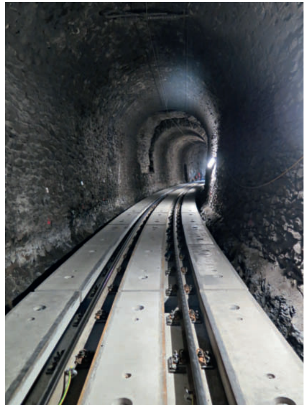
9 Feste Fahrbahn mit Betonplatten zur «Befahrbarkeit»
