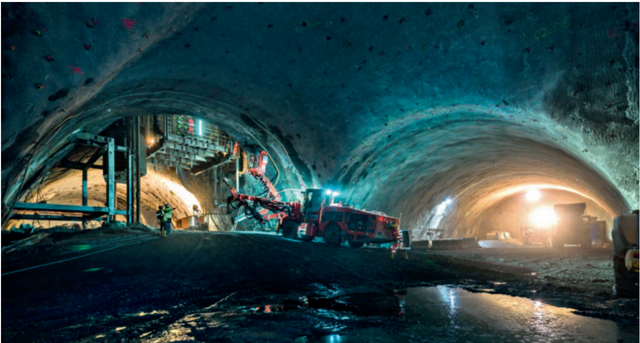
11 Herstellen der Kavernen (Bereich der späteren Baustelleneinrichtung in der späteren Nothaltestelle) Constructing the caverns (subsequent site equipment area in the eventual emergency station)
