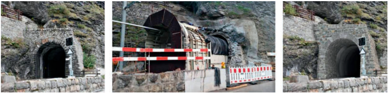
8 Portalbauwerk vor, während und nach der Instandsetzung Portal structure before, during and after reinstatement work
