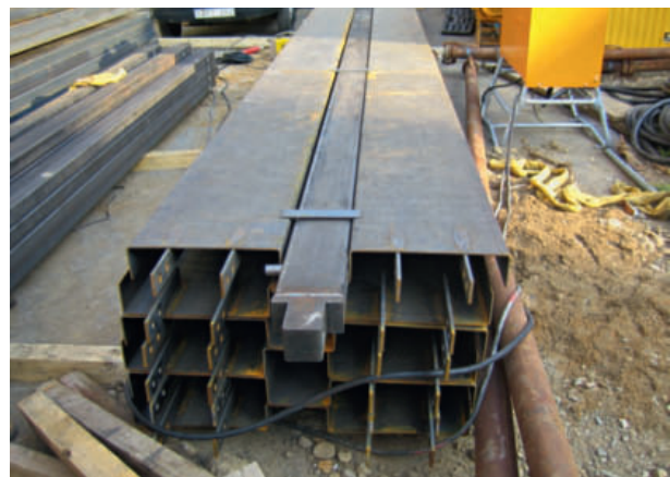
7 Flachfugenelemente 1000 mm vor dem Einbau 1,000 mm flat joint element prior to installation
