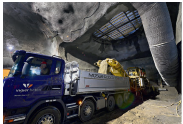
6 Materialabwurf von der Teilschnittmaschine auf Lastwagen (die Teilschnittmaschine befindet sich unterhalb vom Schacht Schlossberg)
