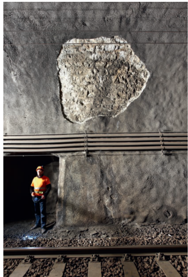
6 Typische Schäden an der Spritzbetonschale Typical damage to a shotcrete shell
