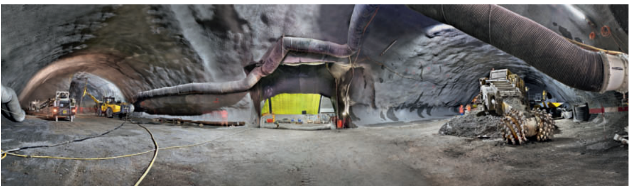
8 Panoramabild (180°) Hauptkaverne Burgstrasse mit Ausbruchsicherung Kalotte (in der Mitte erkennt man den Durchgang zur Hauptkaverne Obere Hauptgasse) Panorama image (180°) of Burgstrasse main cavern with top heading excavation stabilisation (the passage to the Obere Hauptgasse main cavern can be seen in the centre)
