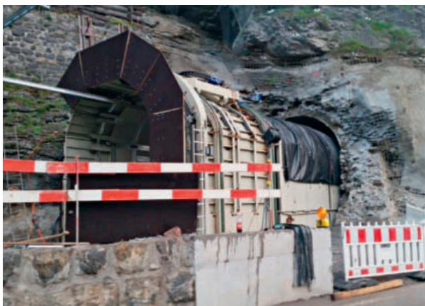
11 Bohrportal an Schutzkonstruktion (mit Luftkissen) gekoppelt Drilling portal coupled to protection structure (false tunnel with air cushions)
