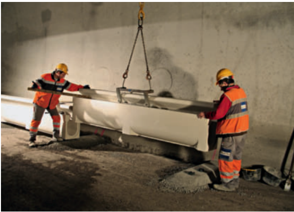
10 Versetzen einer Schlitzrinne Installation of a slotted channel
