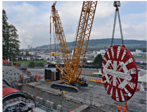
11 Aufbau TBM beim Tunnelportal Ost (Wöschnau) Assembly of TBM at east tunnel portal (Wöschnau)
