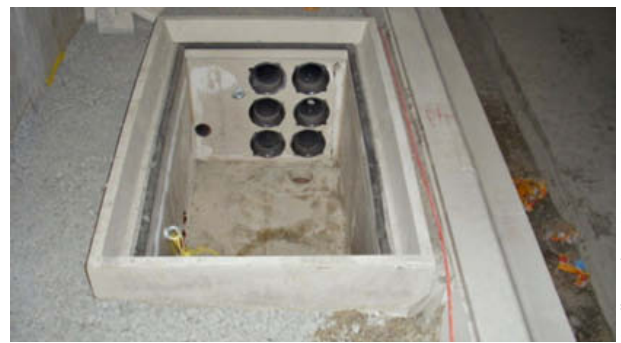
14 Kabelzugschacht im Bankett Cable pulling shaft in walkway
