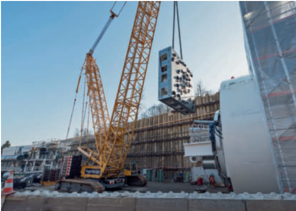
13 Einheben Antriebseinheit TBM Lifting the TBM drive unit
