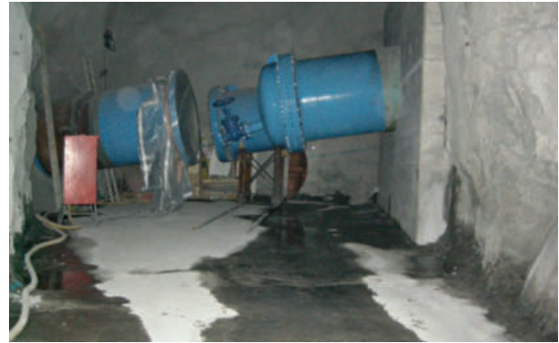
9 Fertiggestellte Verbindung Druckschächte Handeck mit eingebautem Deckel als Abschluss zum bestehenden System Completed connection of the pressure shafts in Handeck with integrated cover as abutment to the existing system
