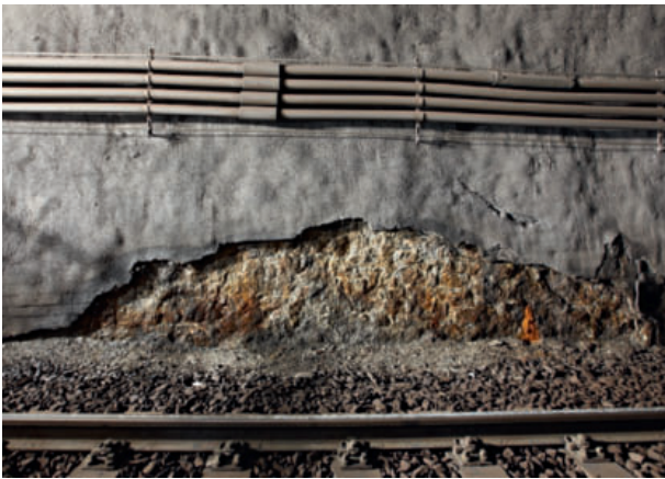
5 Typische Schäden an der Spritzbetonschale Typical damage to a shotcrete shell
