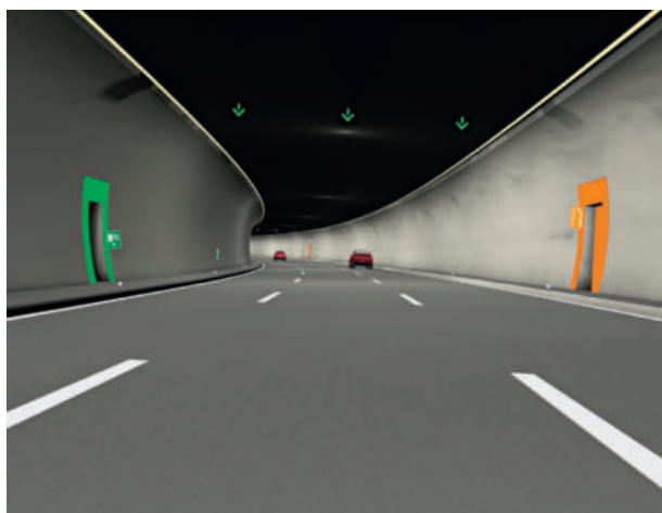
2 Anordnung Querverbindung und SOS-Nische im Fahrraum Arrangement of cross-passage and SOS niche in the driving area
