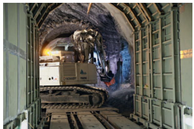
10 Gewölbeausbruch mittels Tunnelbagger mit Anbaufräse Vault excavation using tunnel excavator with transverse cutter attachment
