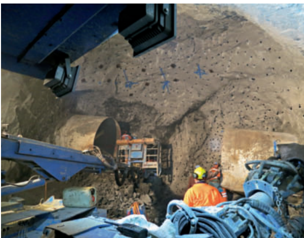
7 Schonender Ausbruch Verbindung Druckschächte Handeck mit dem Spaltgerät Gentle excavation of the connection of the pressure shafts in Handeck using the rock splitter
