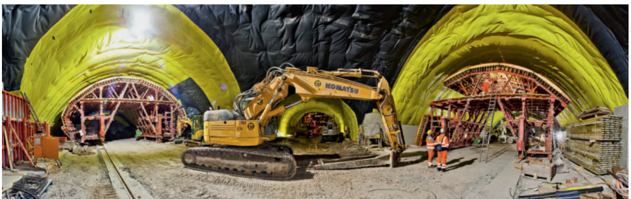
9 Panoramabild (180°) Hauptkaverne Burgstrasse mit Abdichtungsarbeiten und Schalwagen (in der Mitte erkennt man den Ein- und Ausfahrtunnel)
