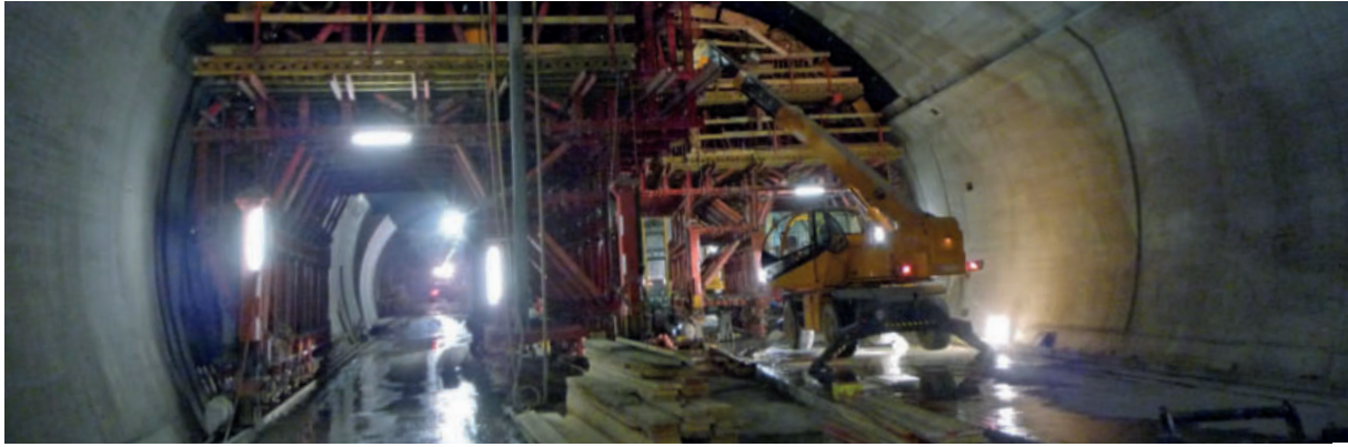
Tunnel Visp – Verzweigung III
