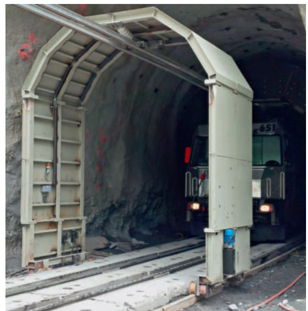
4 Teil der Schutzkonstruktion mit Fahrsschiene am Sohlfertigteile Part of protective tunnel structure with running rail on prefabricated base element
