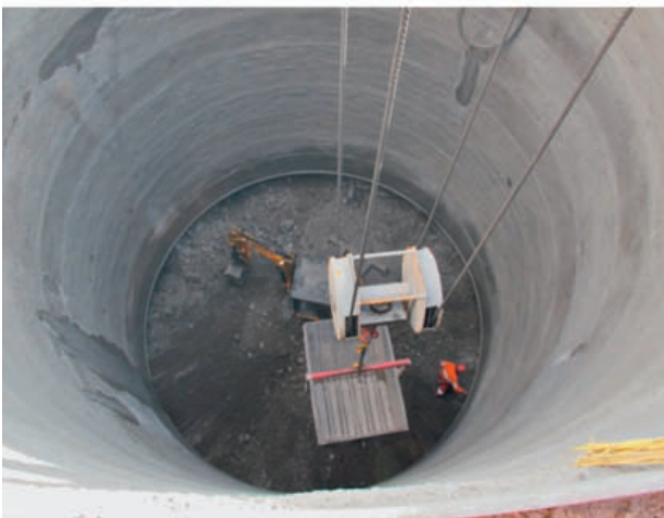
9 Réalisation du puits vertical de la cheminée d'équilibre Making the standpipe for the surge drum
