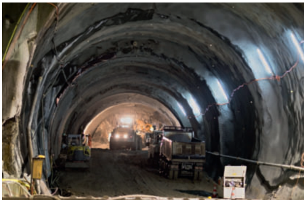
11 Kalottenvortrieb mit Rampe im Tunnel Top heading drive with ramp in tunnel
