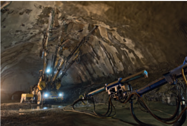
9 Aufweitung Verzweigungskaverne I Branch cavern I enlargement
