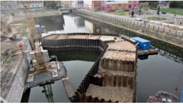
6 Fangedamm im Spreekanal während der Herstellung Coffer dam in the Spree Canal under construction
