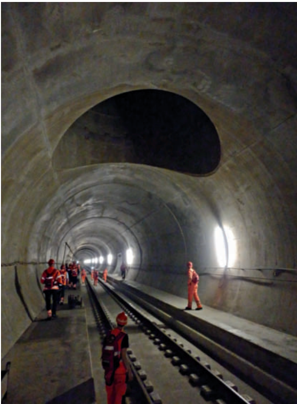
4 Absaugöffnung Lüftungsanlage Extraction port in ventilation system
