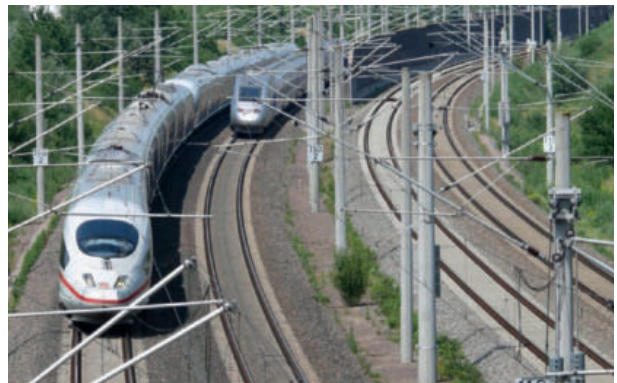
4 Vierspurig ausgebaute Rheintalbahn bei Baden-Baden (Strecke Rastatt–Offenburg) Four-track widened Rheintalbahn at Baden-Baden (line Rastatt–Offenburg)
