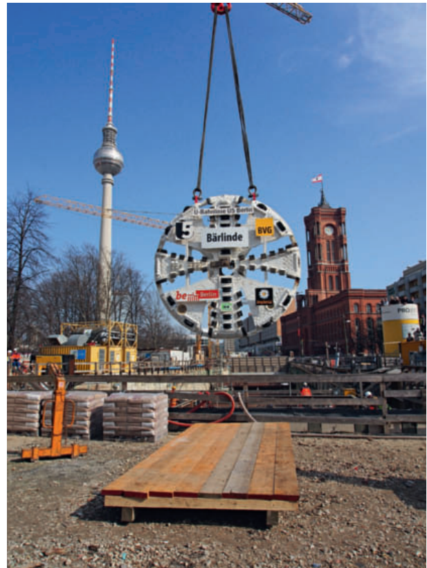
4 Schneidrad der Schildmaschine «Bärinde» beim Einhub The cutting wheel of the machine "Bärinde" being lifted in
