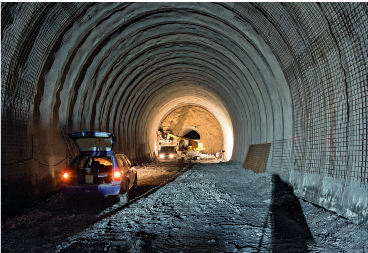
7 Vortrieb Nord, Bogeneinbau North drive, installing arches
