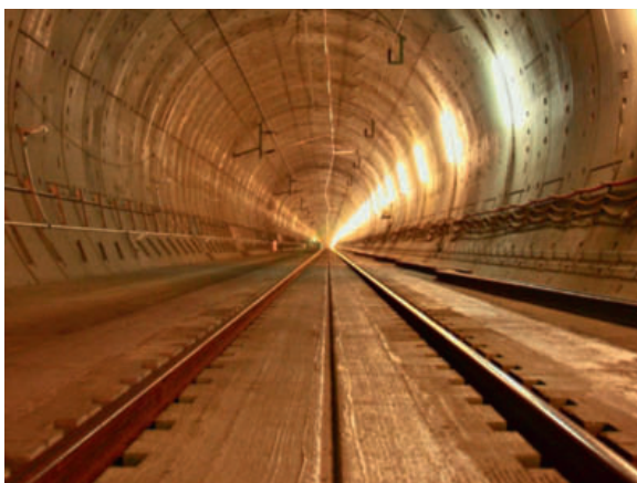
5 Der Katzenbergtunnel, seit 2012 in Betrieb (links), mit einer für Strassenfahrzeuge befahrbaren Sohle, «System Bögl» (rechts) The Katzenberg Tunnel, in operation since 2012 (left), with an invert suitable for wheeled vehicles "System Bögl" (right)
