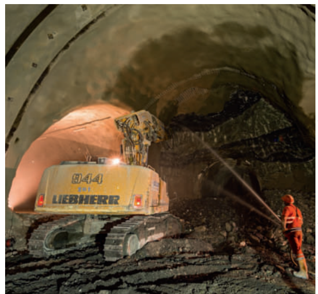
10 Vortrieb Süd, Ortsbrust mit geologischem Aufbau (links Querverbindung 61, rechts Querverbindung 62)
