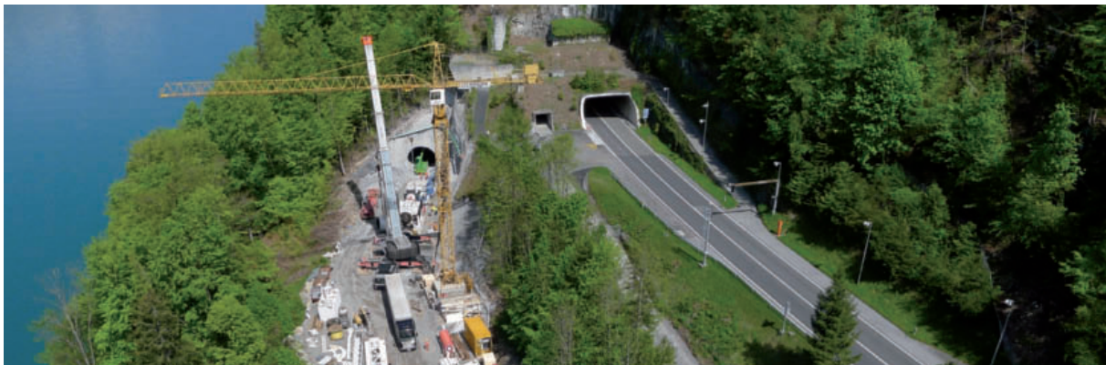
N8 Sicherheitsstollen Giessbach
