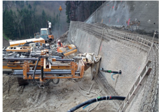
8 Hangsicherung als Vorbereitung für den Voreinschnitt Süd Preparatory slope stabilisation for the south pilot cut
