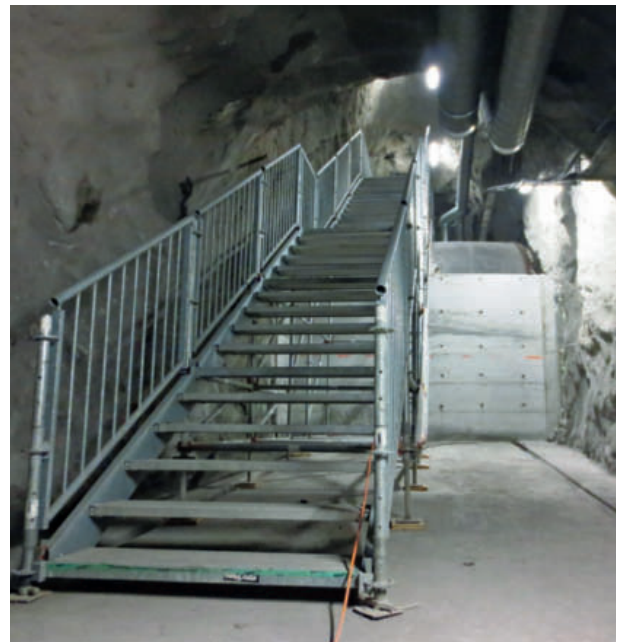
8 Treppe im aufgeweiteten Fluchtstollen QV6. Im Hintergrund die Stützmauer und die Abdeckung für die Durchfahrt der TBM Stairway in the enlarged evacuation tunnel – cross-passage 6. The supporting wall and the covering for the TBM passing through are in the background
