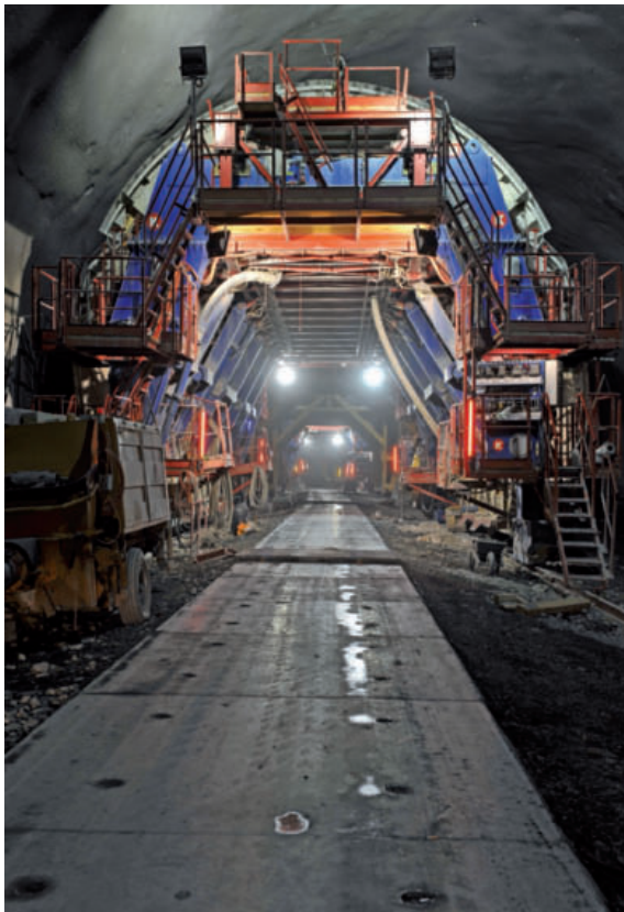
A9 Umfahrung Visp, Tunnel Eyholz
