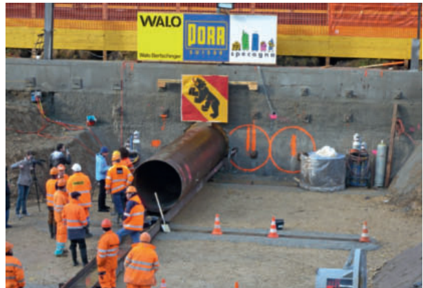
11 Tischbrücke Bözingenfeld "Table bridge" Bözingenfeld
