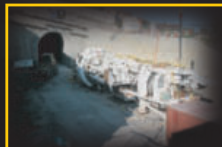
N05, Tunnel de Ligerz (BE)
