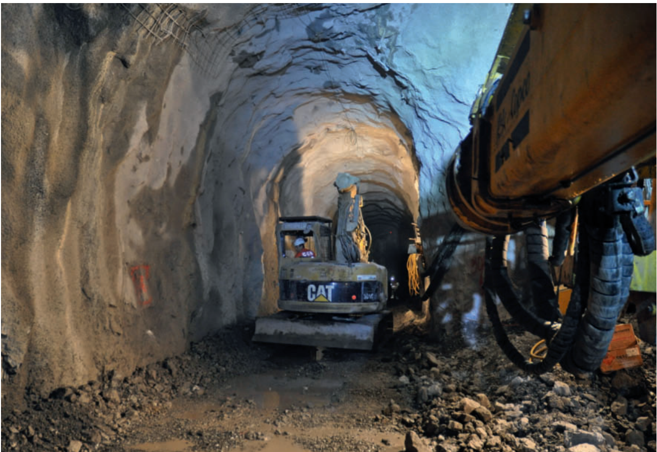
5 Sprengvortrieb Sicherheitsstollen Chüebalm im Bereich einer Nische Drill+blast operation for the Chüebalm safety tunnel around a bay
