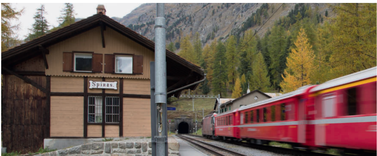
1 Ansicht Tunnelportal Seite Spinas (Engadin)
