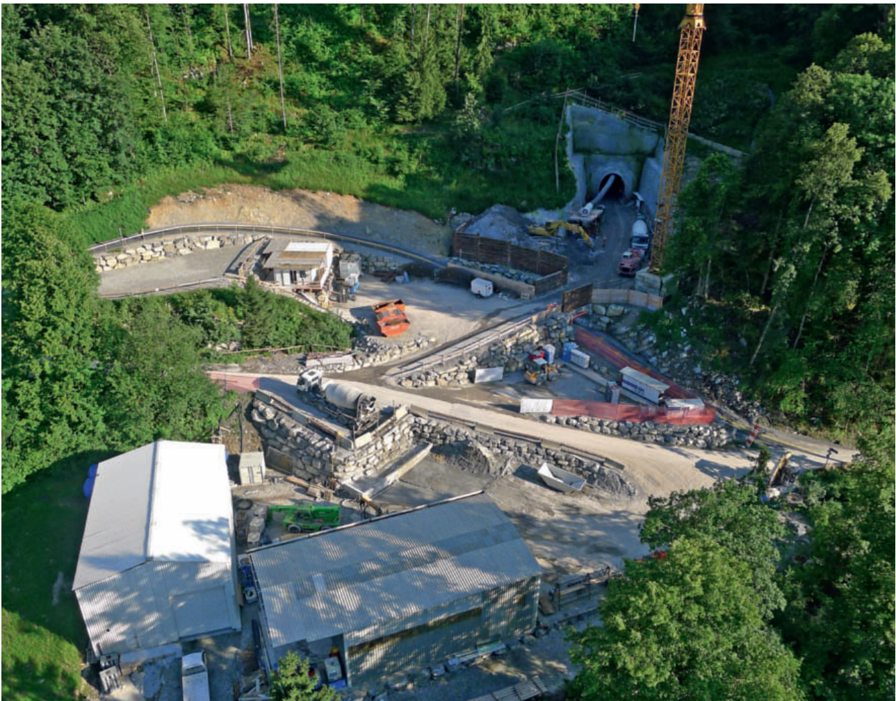
2 Installationsplatz Chüebalm Ost mit Voreinschnitt und Portal Sicherheitsstollen Chüebalm East installation yard with pre-cut and safety tunnel portal
