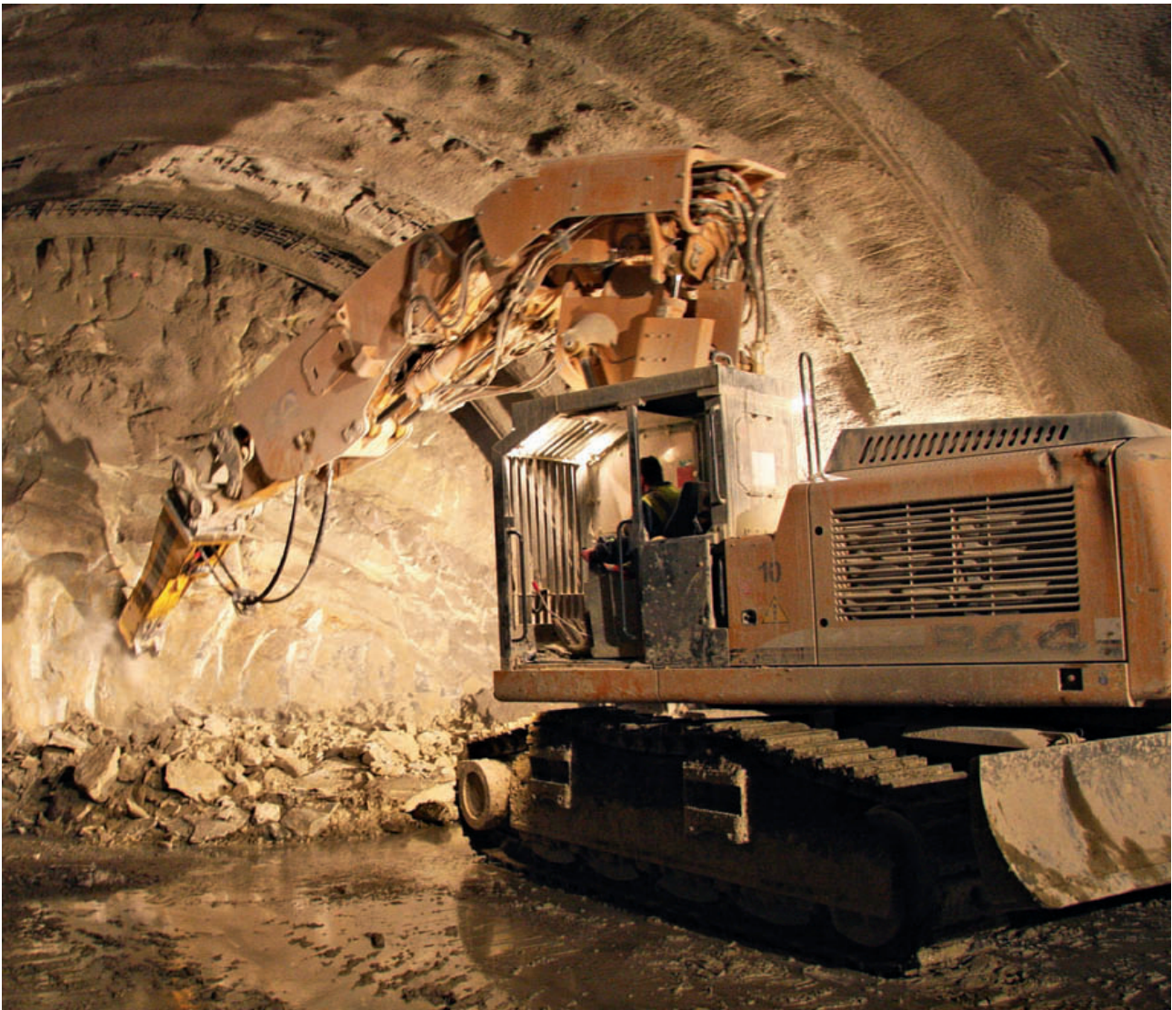
14 Tunnelausbruch im Molassefels, Tunnel Sous le Mont, A16 Tunnel excavation in molasse rock, Tunnel Sous le Mont, A16
