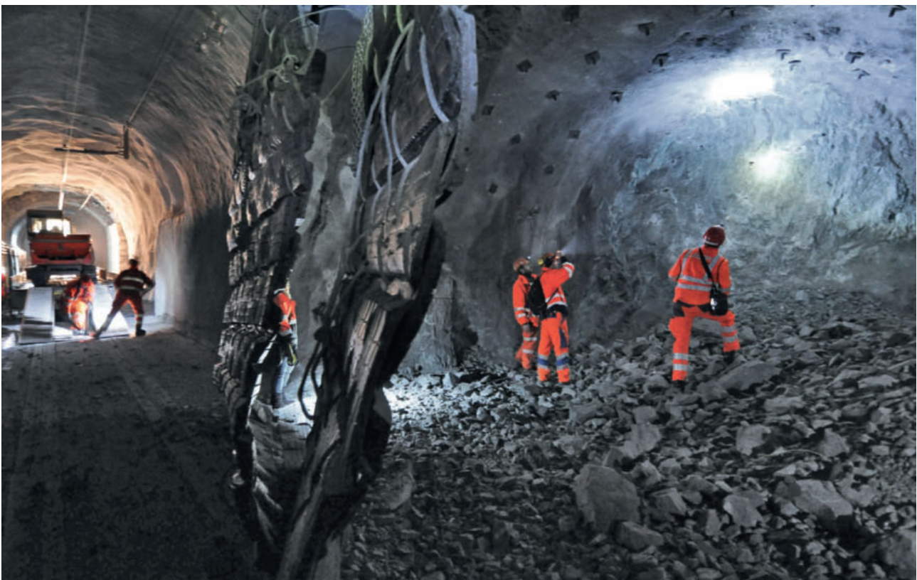
17 Vorbereitung der Querverbindung im alten Albulatunnel I Preparing the cross-passage in the old Albula I Tunnel
