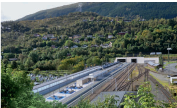
4a Ostportal in Årna East portal in Årna
