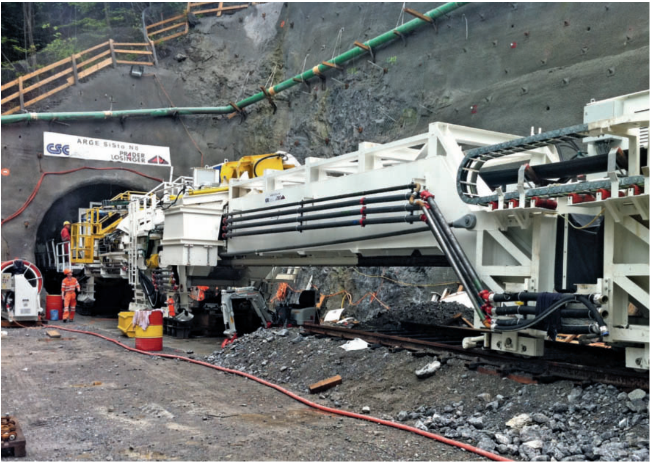
7 Sicherheitsstollen Giessbach – Vortriebsanlage in der Montagephase Giessbach safety tunnel – TBM at the assembly stage
