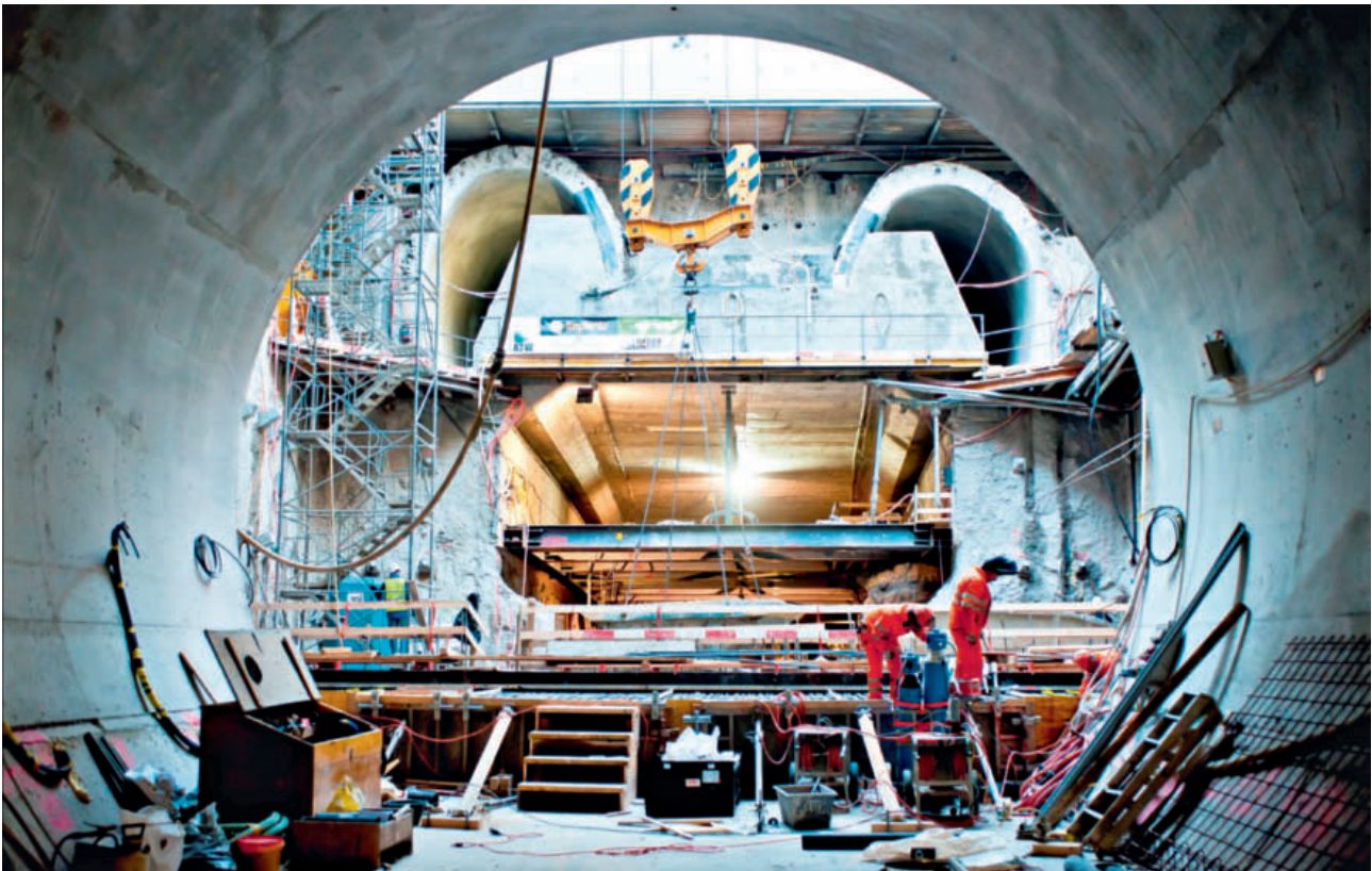
7 Bergmännische Deckelbauweise Mined top-down construction
