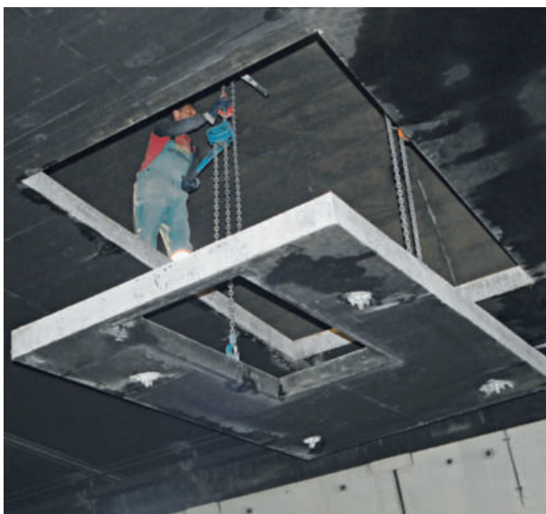
10 Ausschneiden der Zwischendecke im Seelisbergtunnel für Einbau der Lüftungsklappen Removing the intermediate ceiling in the Seelisberg Tunnel to install the ventilation flaps
