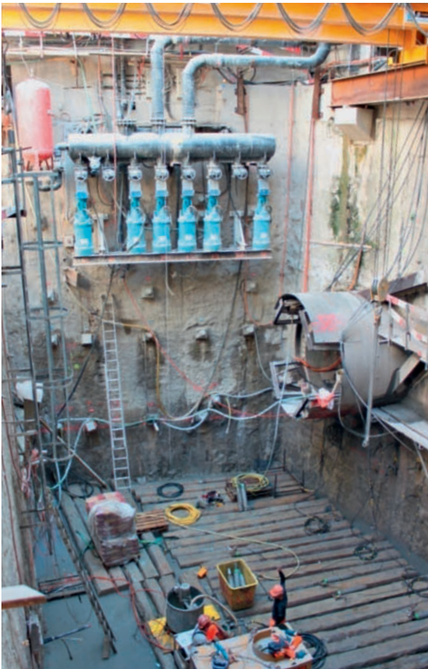
9 Notwasserhaltung Schacht Südtrakt Emergency dewatering South Wing shaft
