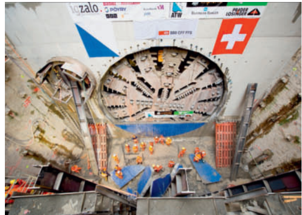
13 Durchstich am 22.11.2010 Breakthrough on 22/11/2010
