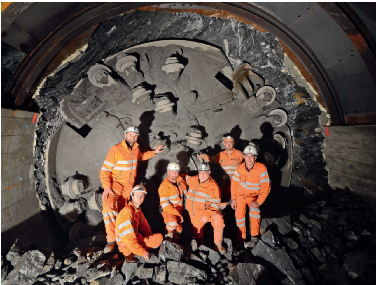
11 Einfahrt der TBM in die Querverbindung QV6 The TBM entering cross-passage 6
