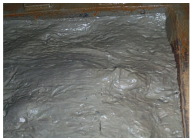
2 Vortrieb der ersten Röhre: Verklebung der Schneidradöffnungen mit „Boomse Klei“
