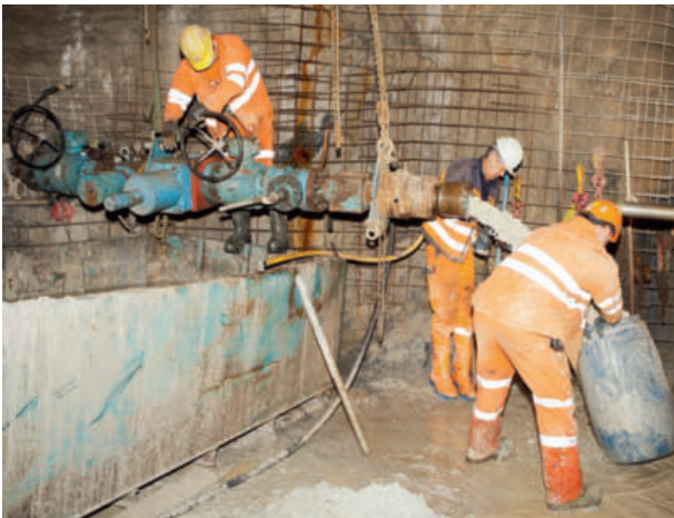
15 Vorversuch: Bohrungen in die Störzone (Rauwacke) Prior test: drilling in the fault zone (cell lime)
