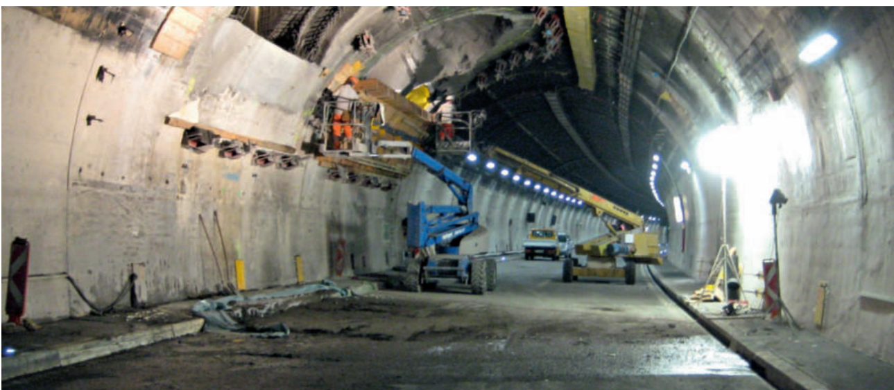
5 Bauarbeiten im A2-Tunnel Belchen
