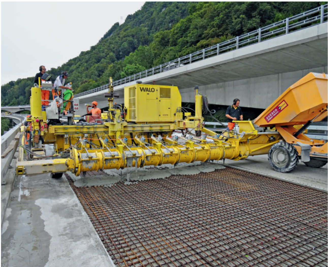
5 Maschineller Einbau einer 50 mm dünnen UHFB-Schicht, die mit Betonstahlbewehrung versehen ist, zur Verstärkung und Abdichtung der Fahrbahnplatte des 2.1 km langen Chillon Autobahnviadukts zwischen Montreux und Villeneuve VD
