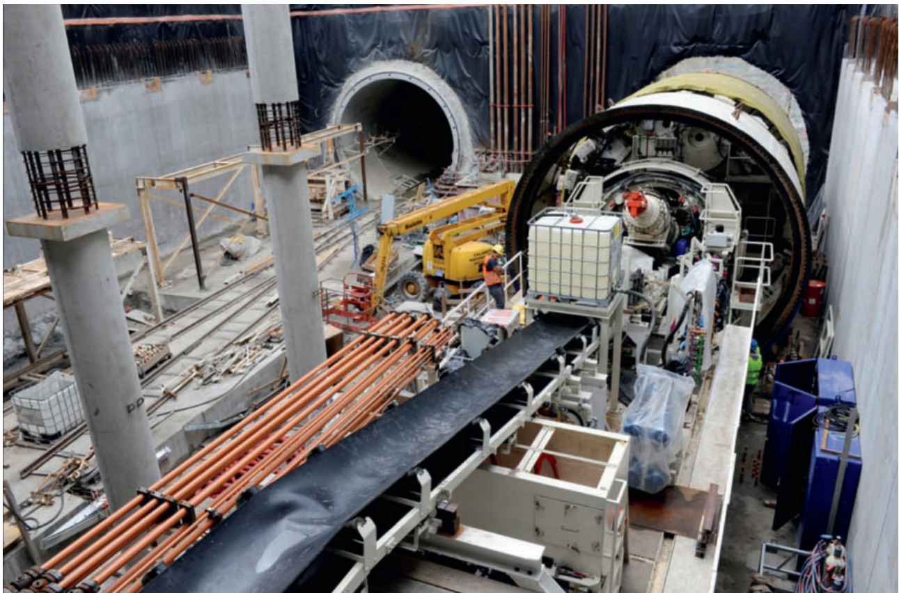
2 Stazione Monumentale. Gallerie scudate Monumentale station, bored tunnels
