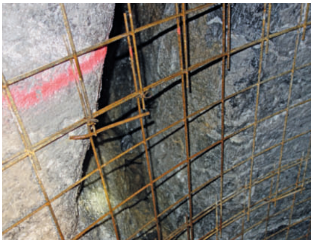
9 Offene Klüfte im TBM-Vortrieb Giessbach Open cracks in the Giessbach TBM drive
