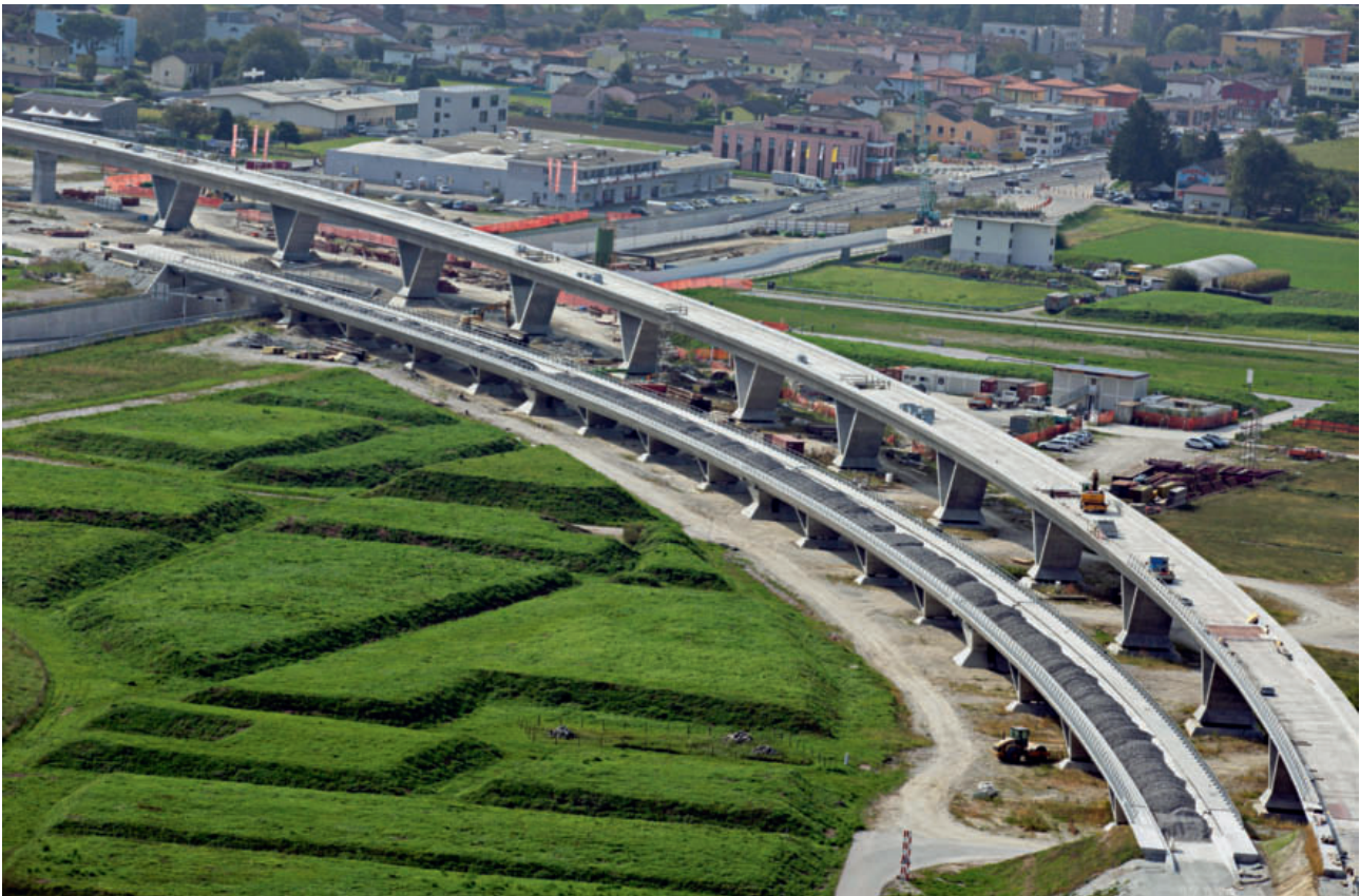
4 Viadukte Knoten Camorino, Stand der Arbeiten Oktober 2014 Viaducts at Camorino Node, work status in October 2014
