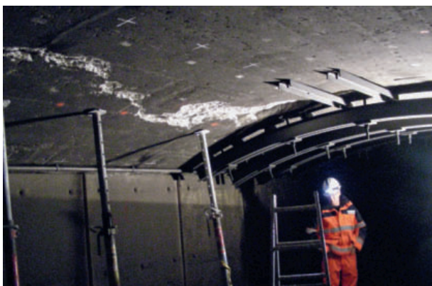
8 Schäden am Tunnelgewölbe des Belchentunnels Damage to the tunnel vault of the Belchen Tunnel
