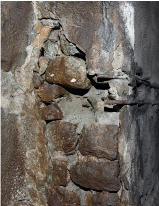
3 Typischer Schaden am Mauerwerk Typical damage to the masonry
