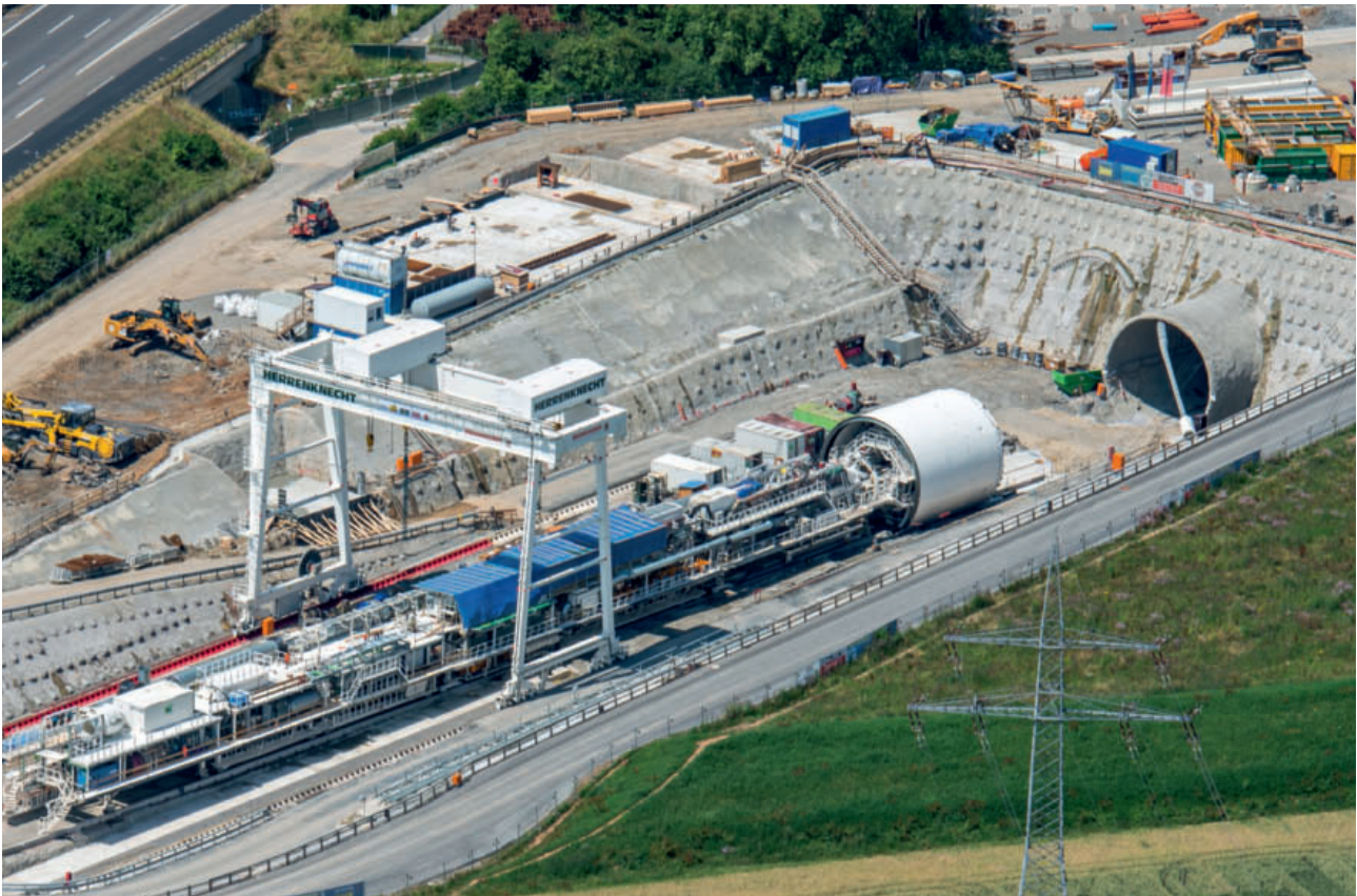
7 Tunnelbohrmaschine SUSE vor dem Beginn der Vortriebsarbeiten am Filderportal Tunnel boring machine SUSE at the Filder portal before starting work
