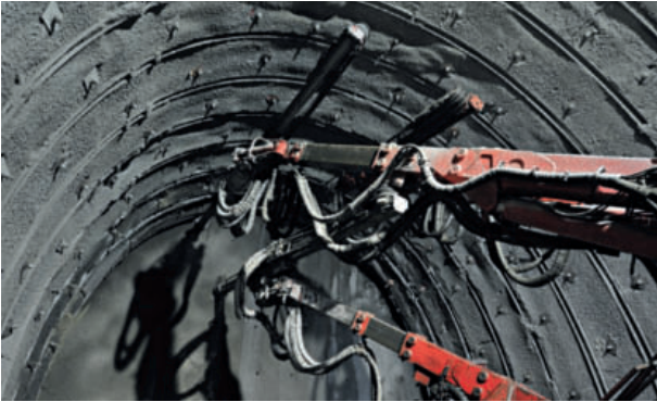
10 Vortriebsarbeiten in bautechnisch anspruchsvoller Geologie Tunnel-heading in technically demanding geology
