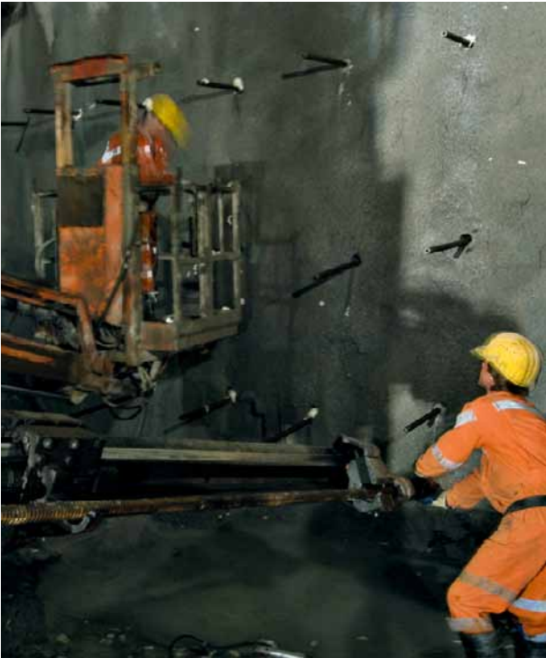
6 Vortrieb Richtung Norden Northbound drive
