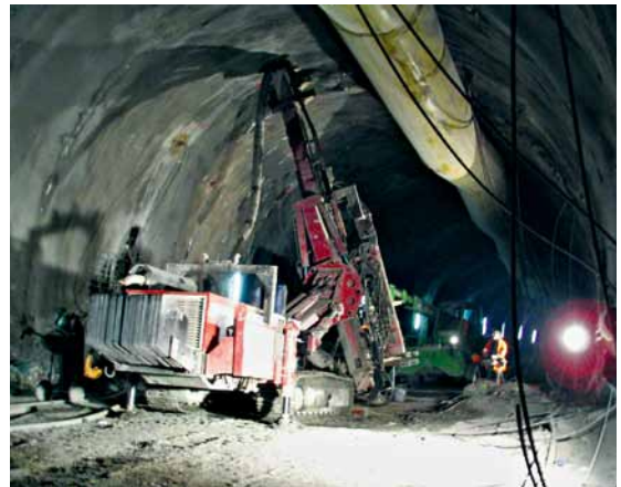
8 Drainagebohrungen über Kopf Drainage drill holes overhead
