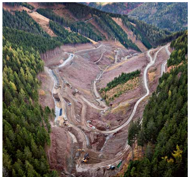
5 Vorbereitung Deponiebereich Longsgraben Preparation of the Longsgraben dump site (Foto: ÖBB-Infrastruktur AG/Zapp-Cam)
