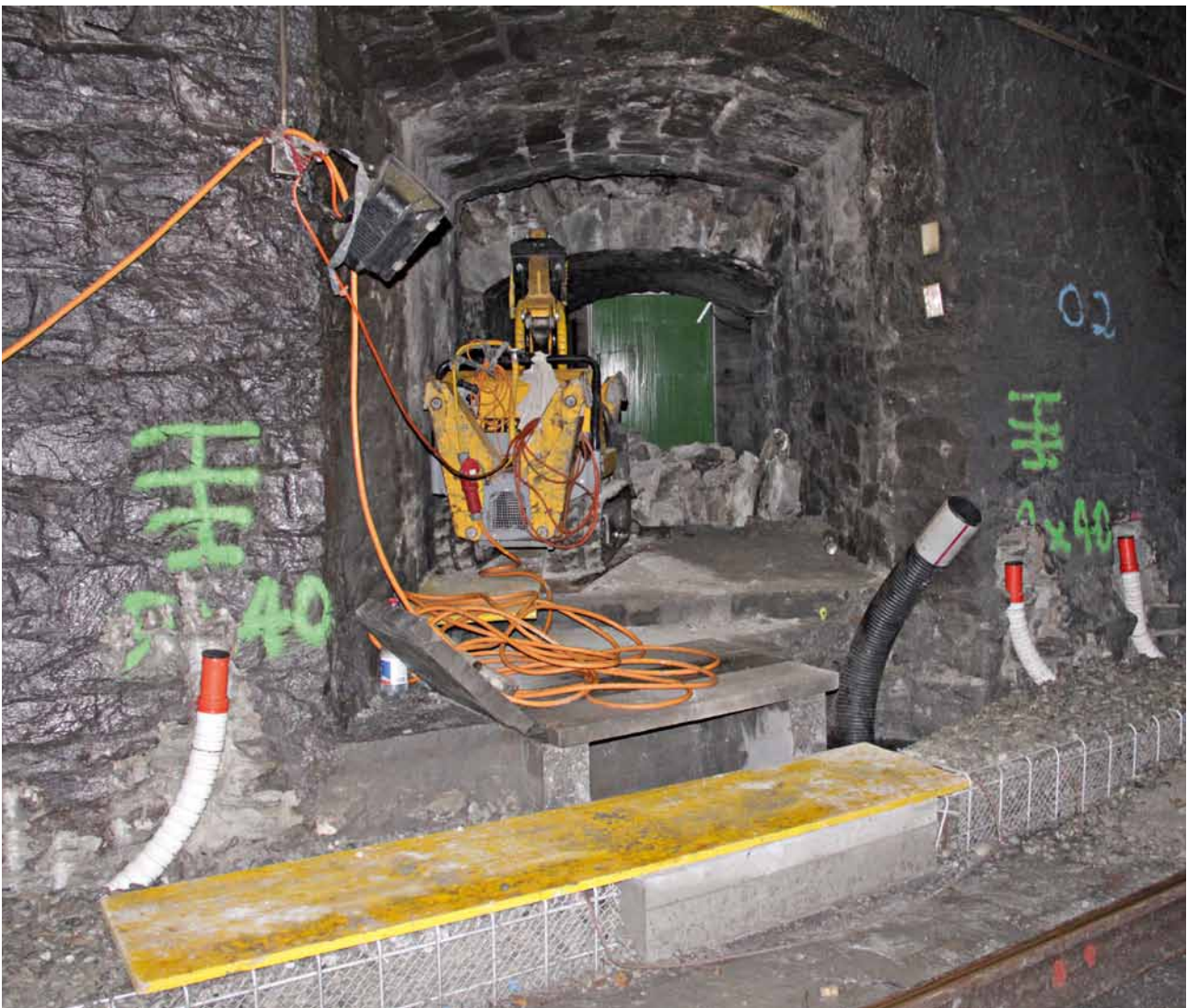
4 Ausbrucharbeiten für eine Türnische in den engen Verhältnissen des Querschlags Excavation work for a door recess in the constricted conditions posed by the cross-passage
