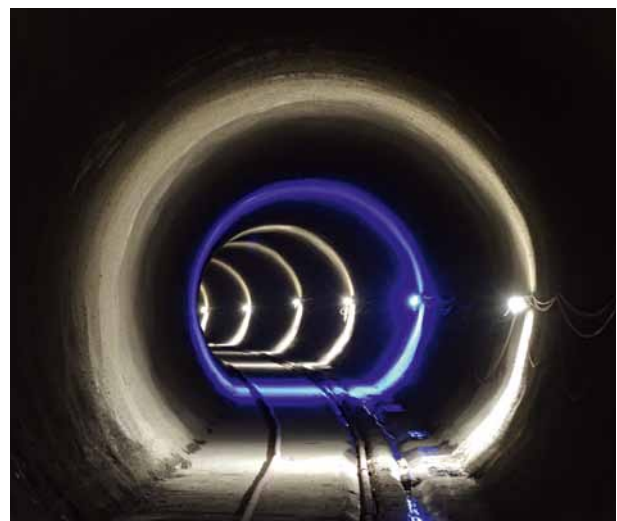
4 Sicherheitsstollen mit fertiger Verkleidung Safety tunnel with completed lining
