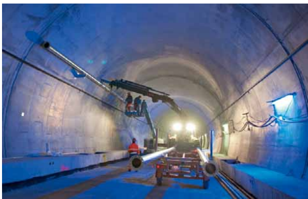
1a Einbau der Abwasserdruckleitung im Weinbergtunnel der DML Installing the drainage duct in the Weinberg Tunnel, Zurich Cross Rail
