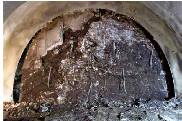
9 Gemischte Ortsbrust Lockergesteinsvortrieb Staldbach Mixed face soft ground drive Staldbach
