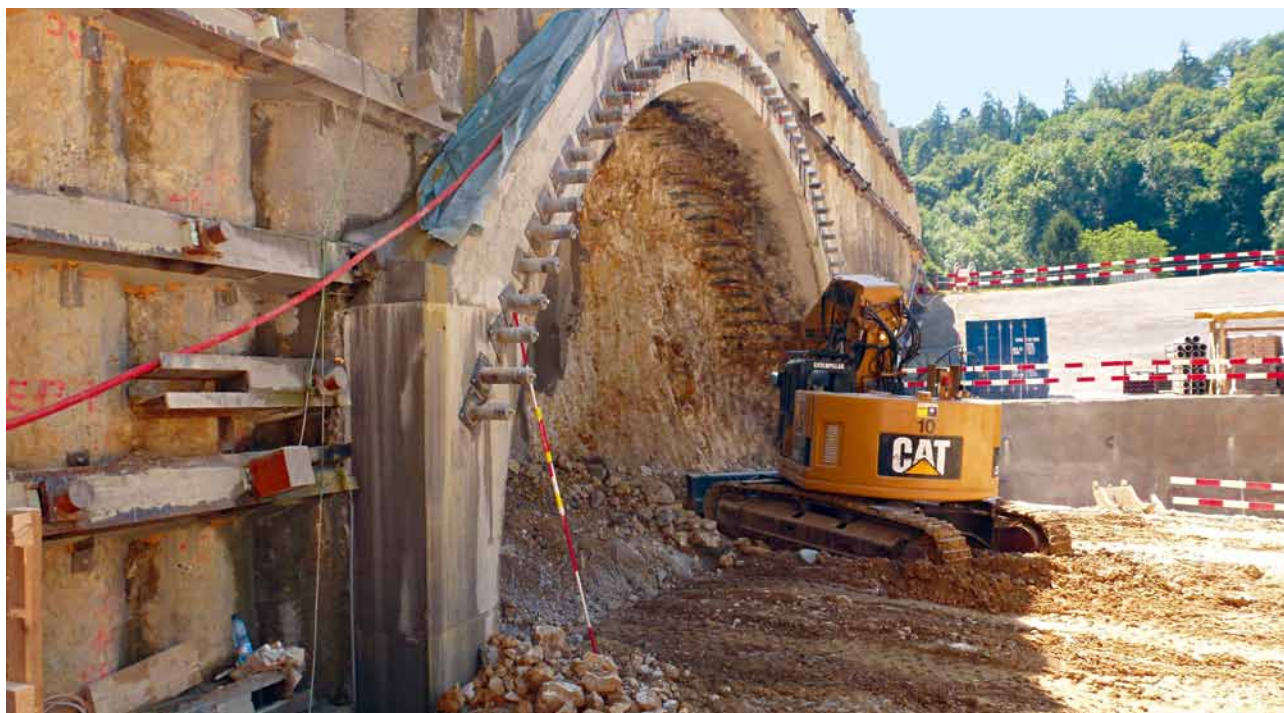
9 Mechanischer Ausbruch Kalotte Portalzone Engi im Schutze des Rohrschirmes Mechanized excavation of crown in the Engi portal zone protected by the pipe umbrella
