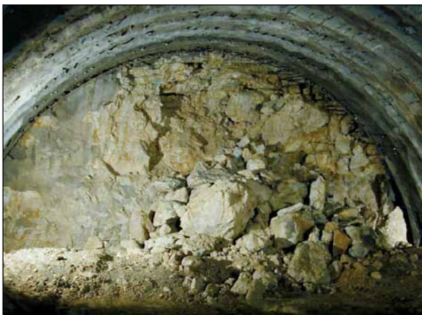
1a Ablösung von Felsblöcken aus der Ortsbrust Loosening of rock blocks from the face
