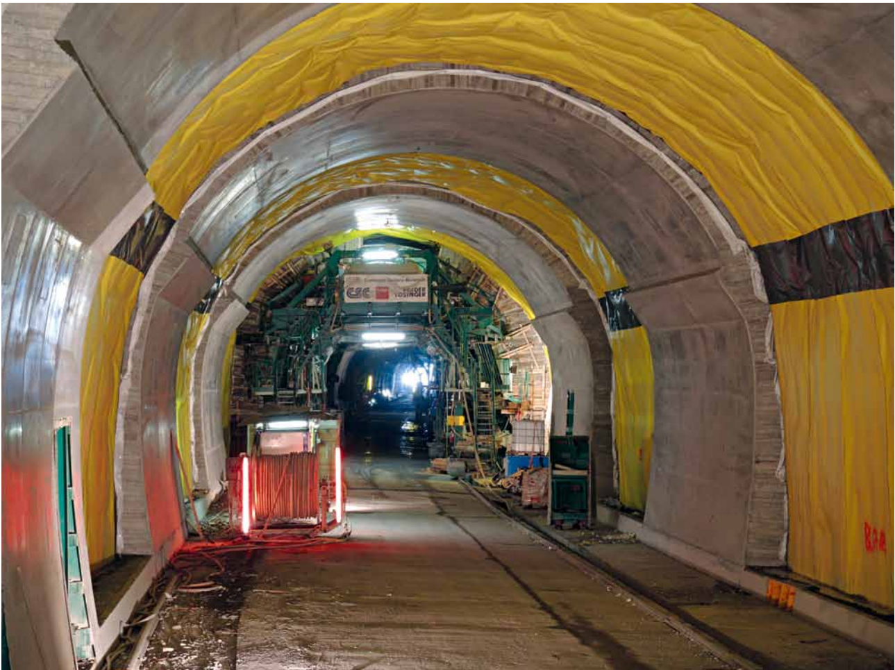
12 Verkleidungsarbeiten Lining operations
