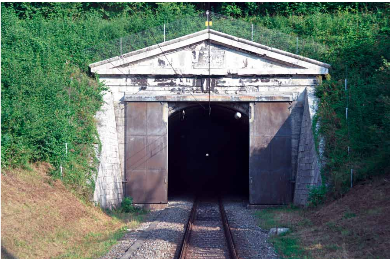
5 Als Baudenkmal erinnert der Hauensteintunnel an die Anfänge der Tunnelbautechnik The Hauenstein Tunnel testifies to the early days of tunnelling technology
