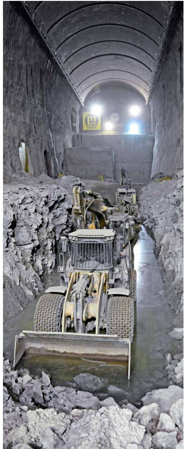
16 Kaverne am Ende des Ausbruchs Cavern after excavation
