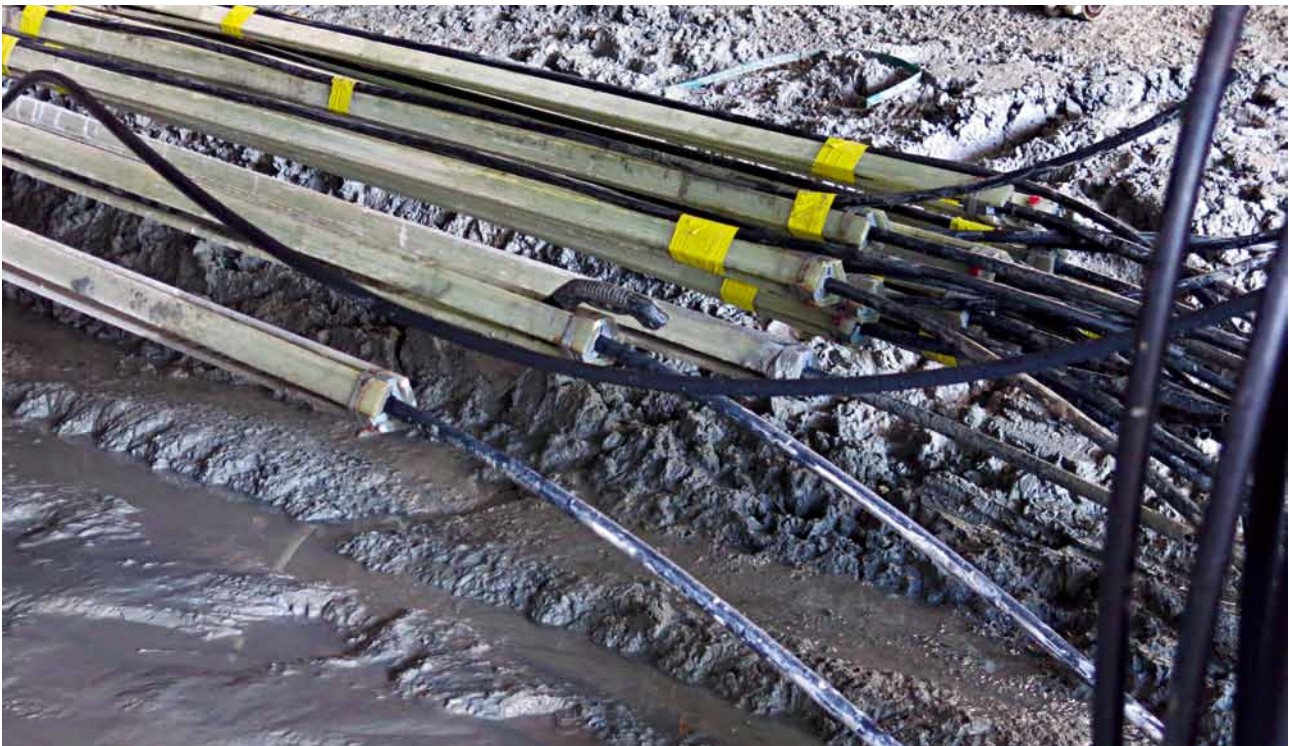
8 Vorbereitete Ortsbrustanker Prepared face anchors
