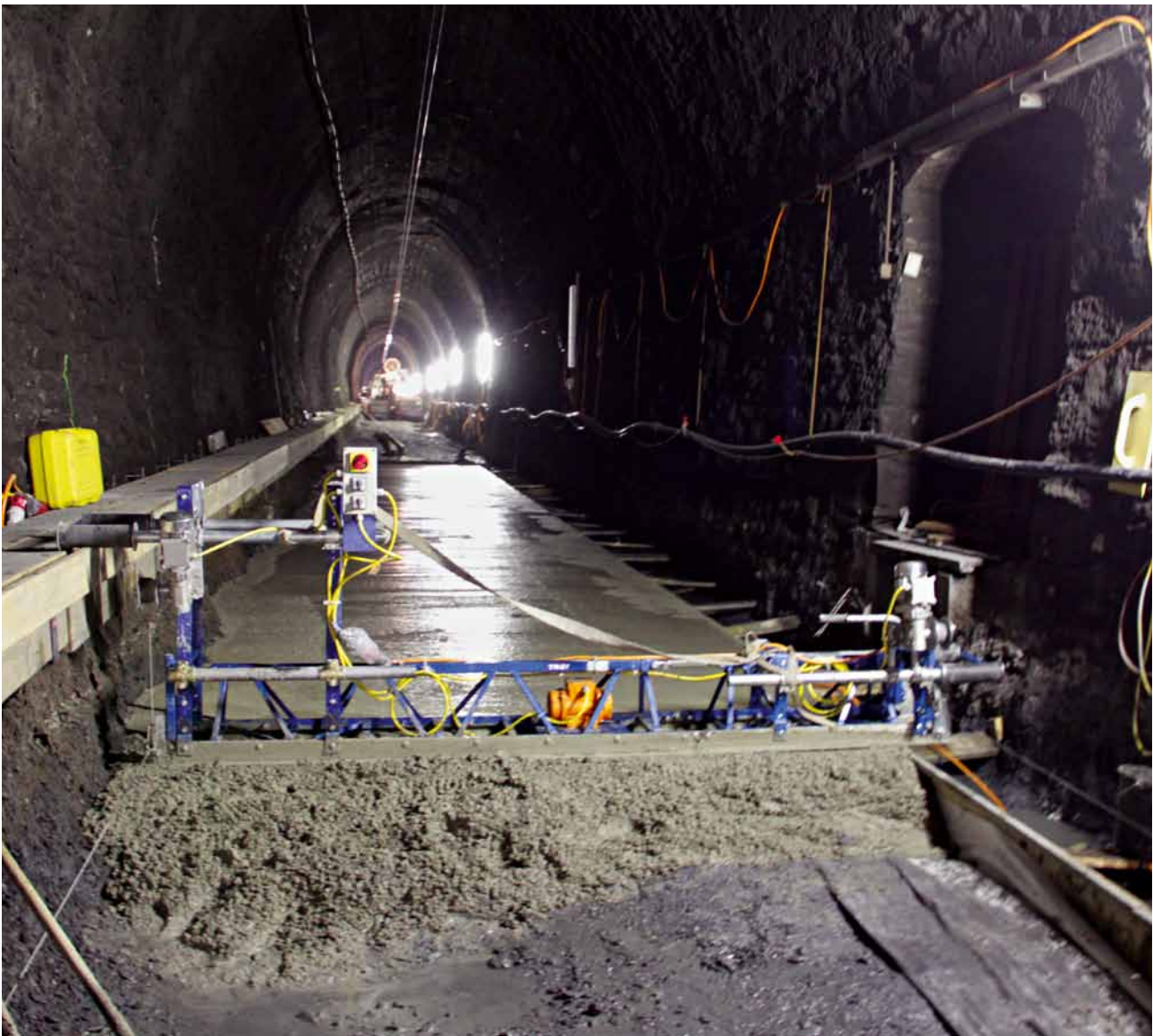
9 Einbau der Betonabdeckung der Tunnelsohle als Bestandteil der Sohlenregulierung Installation of the concrete cover for the tunnel invert as component of adjusting the floor
