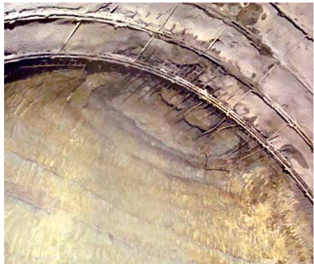
11 Sicherungsklasse 4b Safety class 4b
