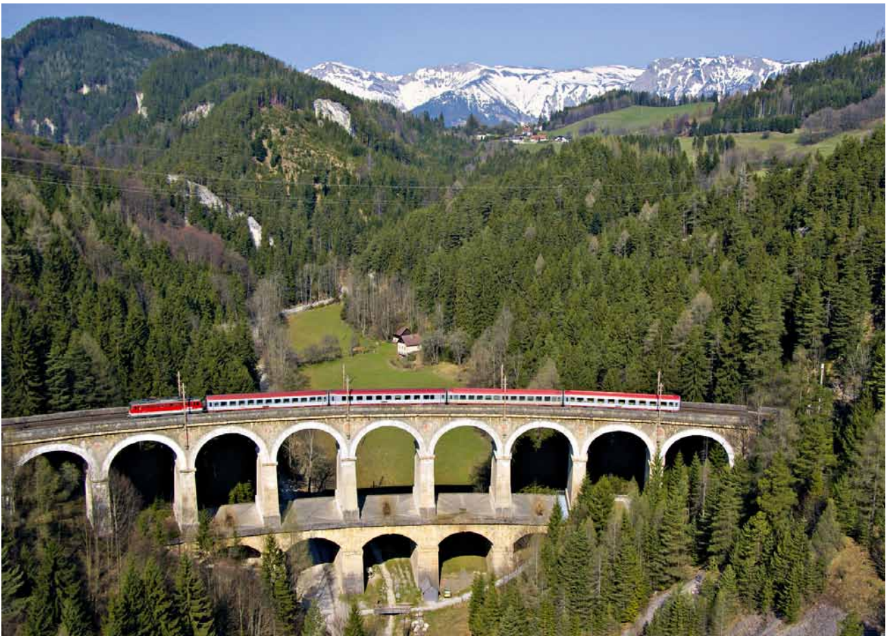
1 Viadukt Kalte Rinne der Ghega-Bahn (Foto: ÖBB-Infrastruktur AG/Christian Dittler) Kalte Rinne viaduct on the Ghega-Bahn
