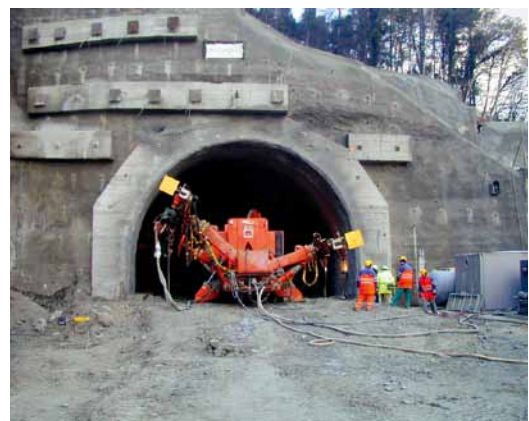
2 Start Vortrieb Südröhre Start of drive in south bore
