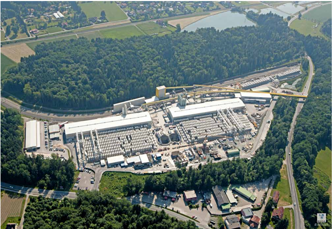
7 Luftbild der Installationsfläche Leibensfeld Aerial shot of the Leibensfeld installation yard
