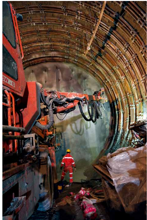
5 Ankerarbeiten an der Ortsbrust Anchor work at the face
