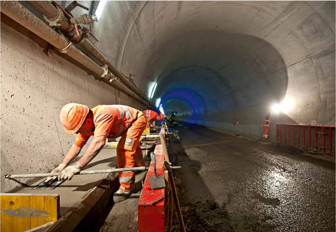
7 Bei Tunnelneubauten wird der spätere Unterhalt bereits in der Planungsphase berücksichtigt The subsequent maintenance is taken into account at the planning stage for new tunnels
