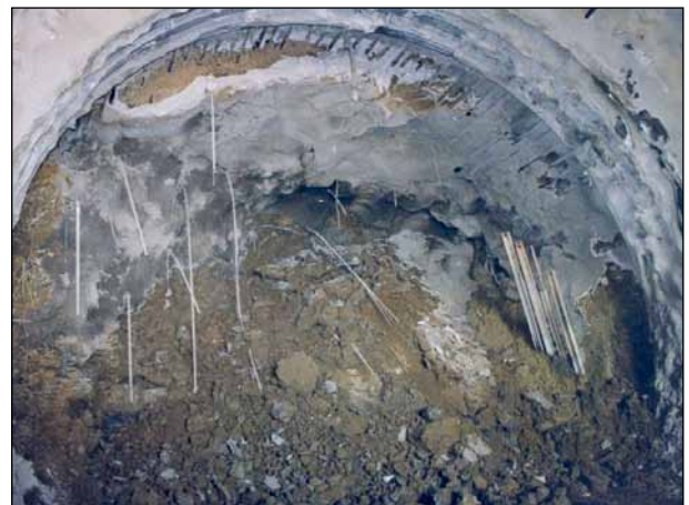
1b Instabilität der Ortsbrust im Lockergestein (Foto: G. Anagnostou) Face instability in soft ground
