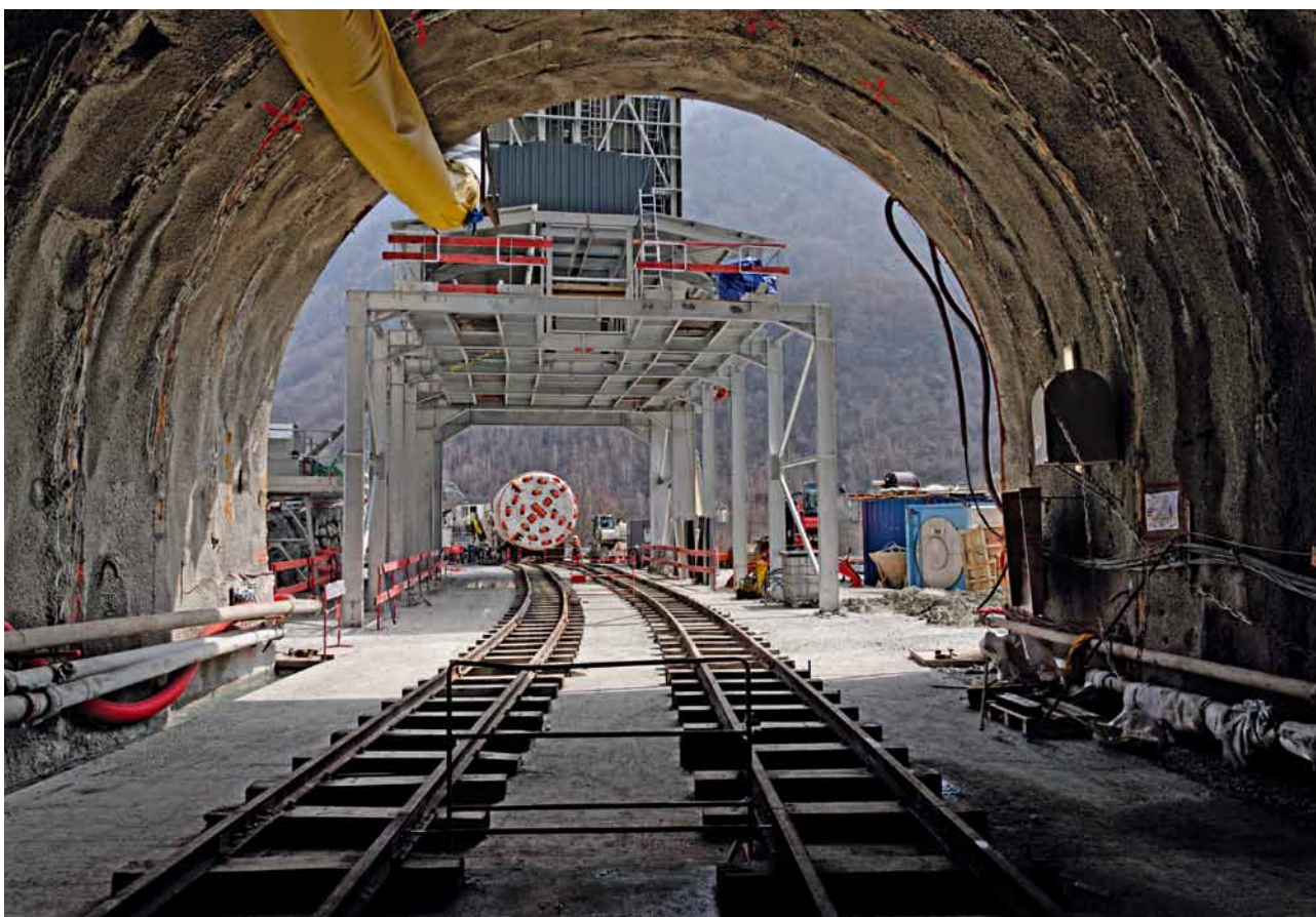
7 Ripage de Rosali depuis la plateforme vers la fenêtre des Ponants Ripage de Rosali from the platform towards the Ponants window
