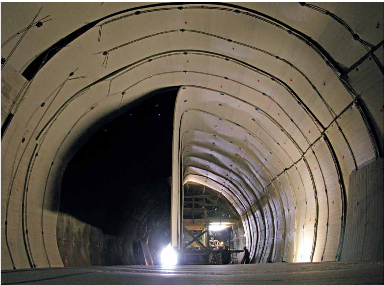
4 Einbau Schaumstoffmatten Installation of foam mats
