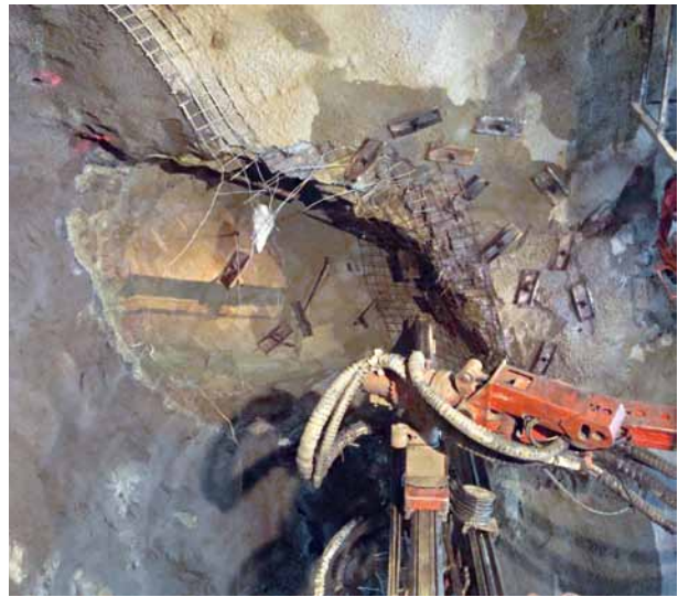
10 Sicherungsklasse 3 Safety class 3
