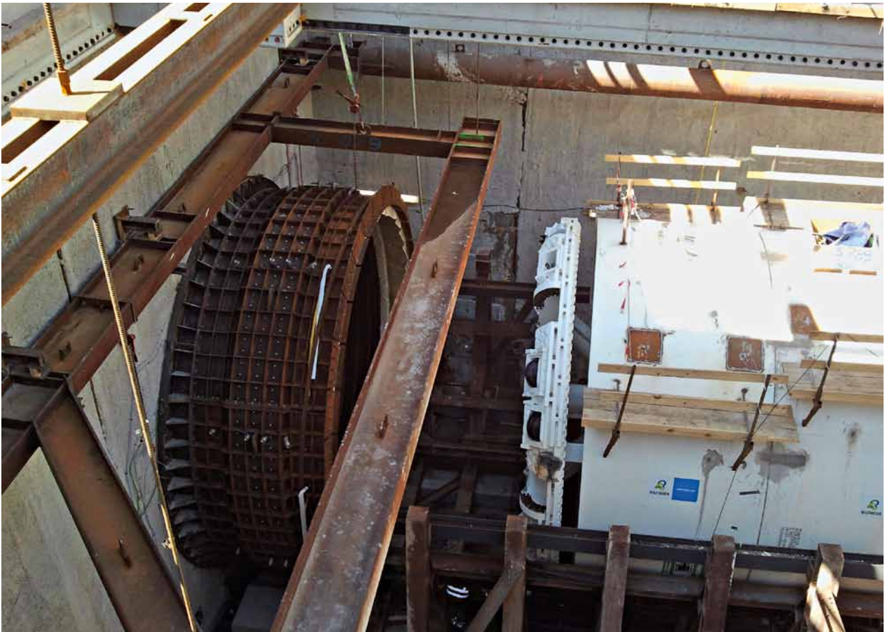
3 TBM während des Einrichtens im Startschacht TBM being aligned in the starting shaft
