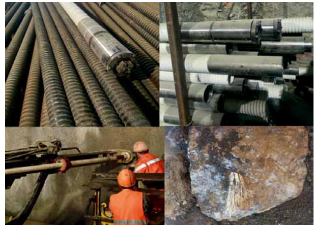
10 Solution autoforeuse GFRP testée sur le tunnel ferroviaire de Sierre GFRP self-drilling solution tested on the Sierre railroad tunnel
