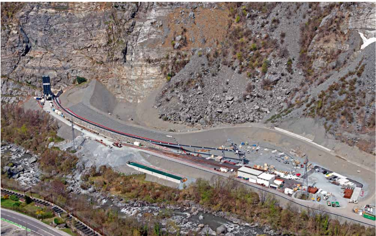
3 Installations de la fenêtre de Ponants – merlon de protection Facilities of the Ponants window – dyke protection
