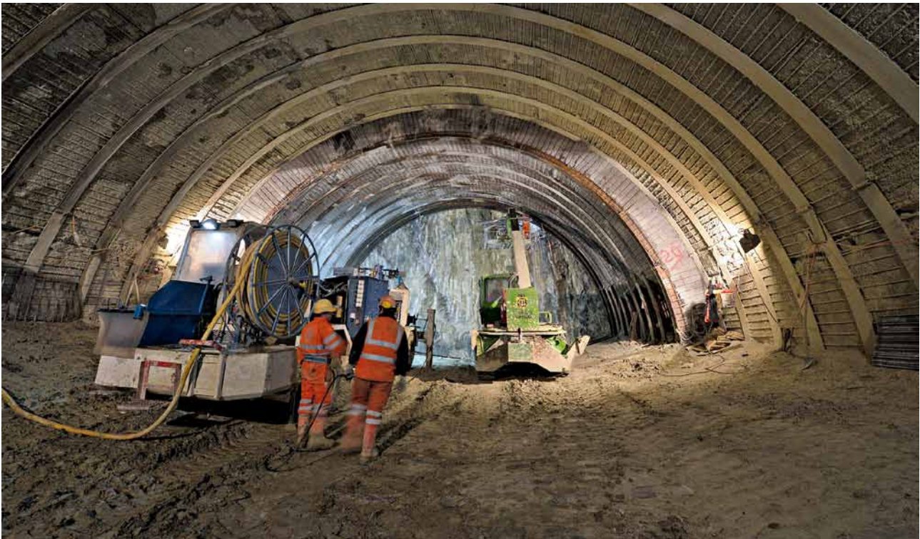
4 Kalottenvortrieb Crown drive
