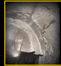
Goldenpass, Tunnel de Valmont (VD)
