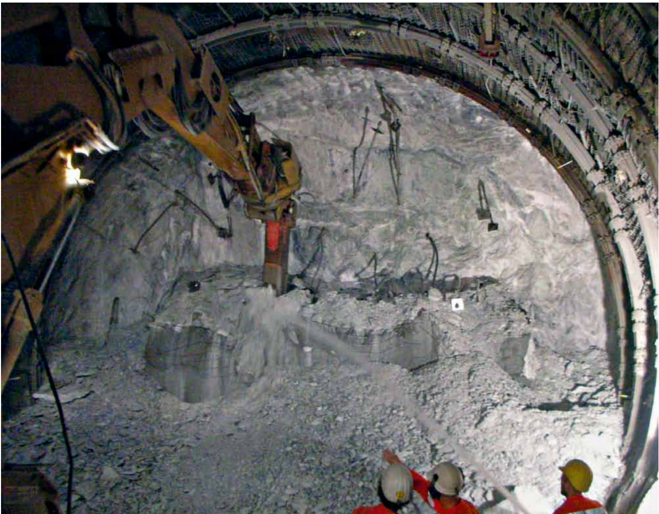
12 Ortsbrustverankerung beim Durchfahren des Tavetscher Zwischenmassivs, Gotthard-Basistunnel, Abschnitt Sedrun Nord Rock face support with self-drilling rockbolts during the advancement in the Tavetscher Zwischenmassiv, Gotthard Base Tunnel, Section Sedrun North
