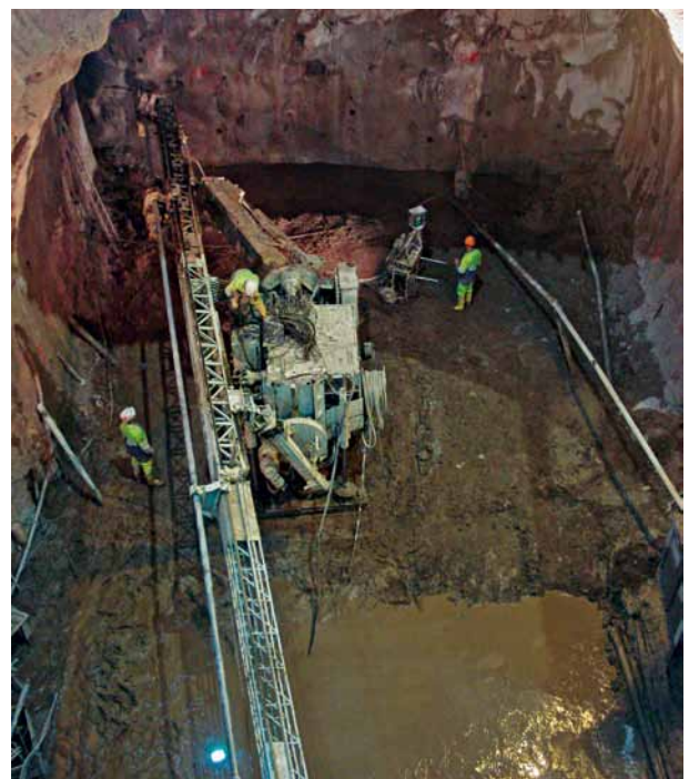
2 Foreuse mat horizontal au puit Marchand à Toulon/F Horizontal mast drill at the Marchand well in Toulon/F
