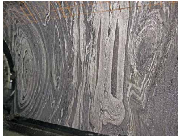
9 Quarzbänder im TBM-Vortrieb Quartz belts in the TBM drive
