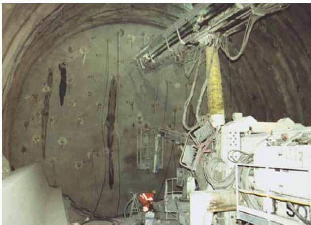
8 Stützung der Ortsbrust mit Brustankern: Ohne Ankerplatten (li.) und mit Ankerplatten (re.) Supporting the face with face anchors: Without anchor plates (left) and with anchor plates (right) (Photos: M. Ramoni (left) and G. Anagnostou (right))
