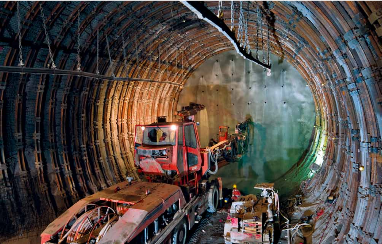
4 Bohrwagen Tamrock Axera T12 „Sedrun“ Tamrock Axera T12 „Sedrun“ jumbo
