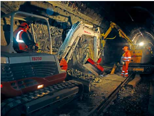
6a Sanierung Simplontunnel: Teilabbruch Parament zur Erstellung eines neuen Querschlags SBB bringing the Simplon Tunnel into line with the latest standards: cutting the edging
