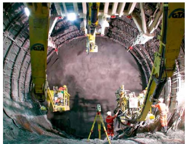
1 Spezialvortrieb in druckhaften Zonen Special drive in squeezing zones
