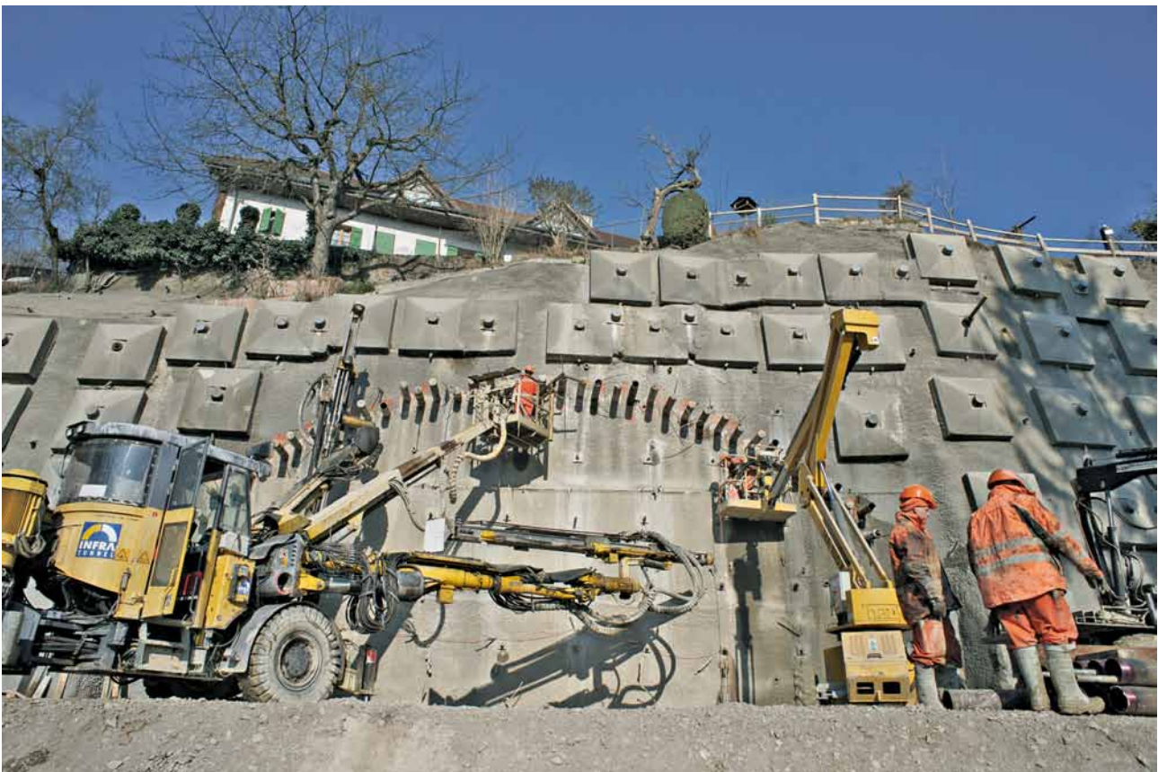
8 Portail Palatinat avec ancrages GFK actifs Palatinat portal with active GRP anchors
