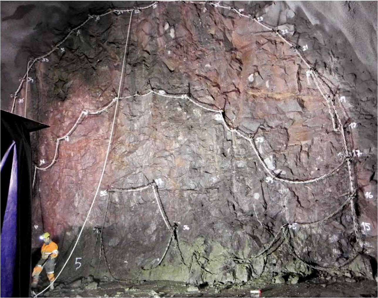
7 Injektion als Vorabdichtung Sealing injections
