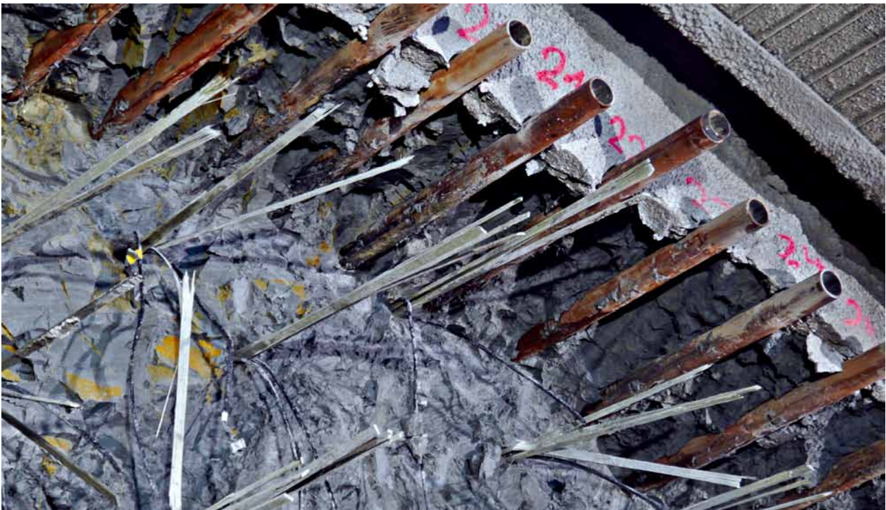
9 Rohrschirm und Ortsbrustanker bei Beginn der Ausbruchtetappe Pipe umbrella and face anchors at the start of excavation stage
