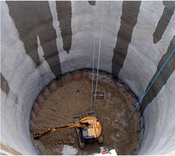
7 Schacht Notausstieg Emergency exit shaft
