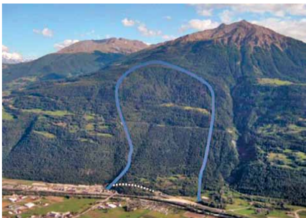
3 Abgrenzung von Sackung und Rutschung am Riedberg mit Linienführung Limit of settlement and sliding at the Riedberg with route alignment
