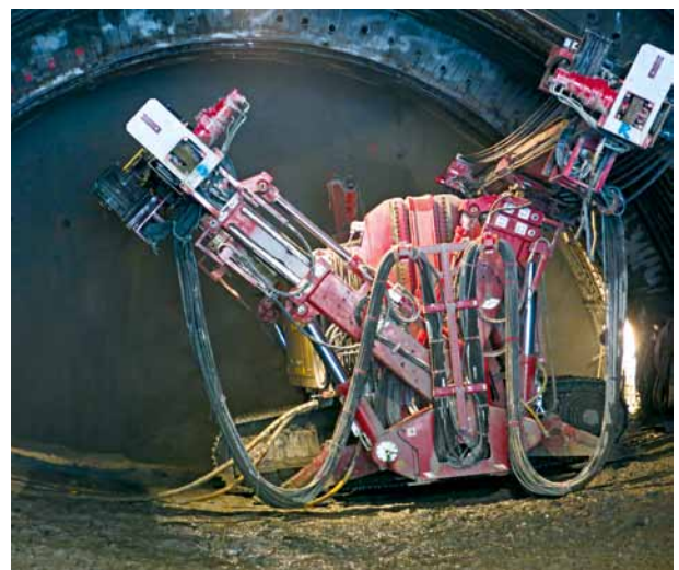
6 Bohren der Ankerlöcher Drilling the anchor holes
