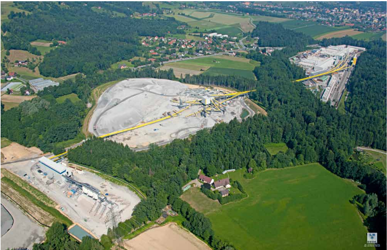
8 Luftbild sämtlicher Installationen: Kiesaufbereitung (links), Vorabsiebung und Deponiefläche Holleneegg 4 (mitte), Installationsfläche Leibenfeld (rechts) Aerial shot of all installations: gravel preparation (left), pre-sifting and dumping area Holleneegg 4 (centre), Leibenfeld installation yard (right)
