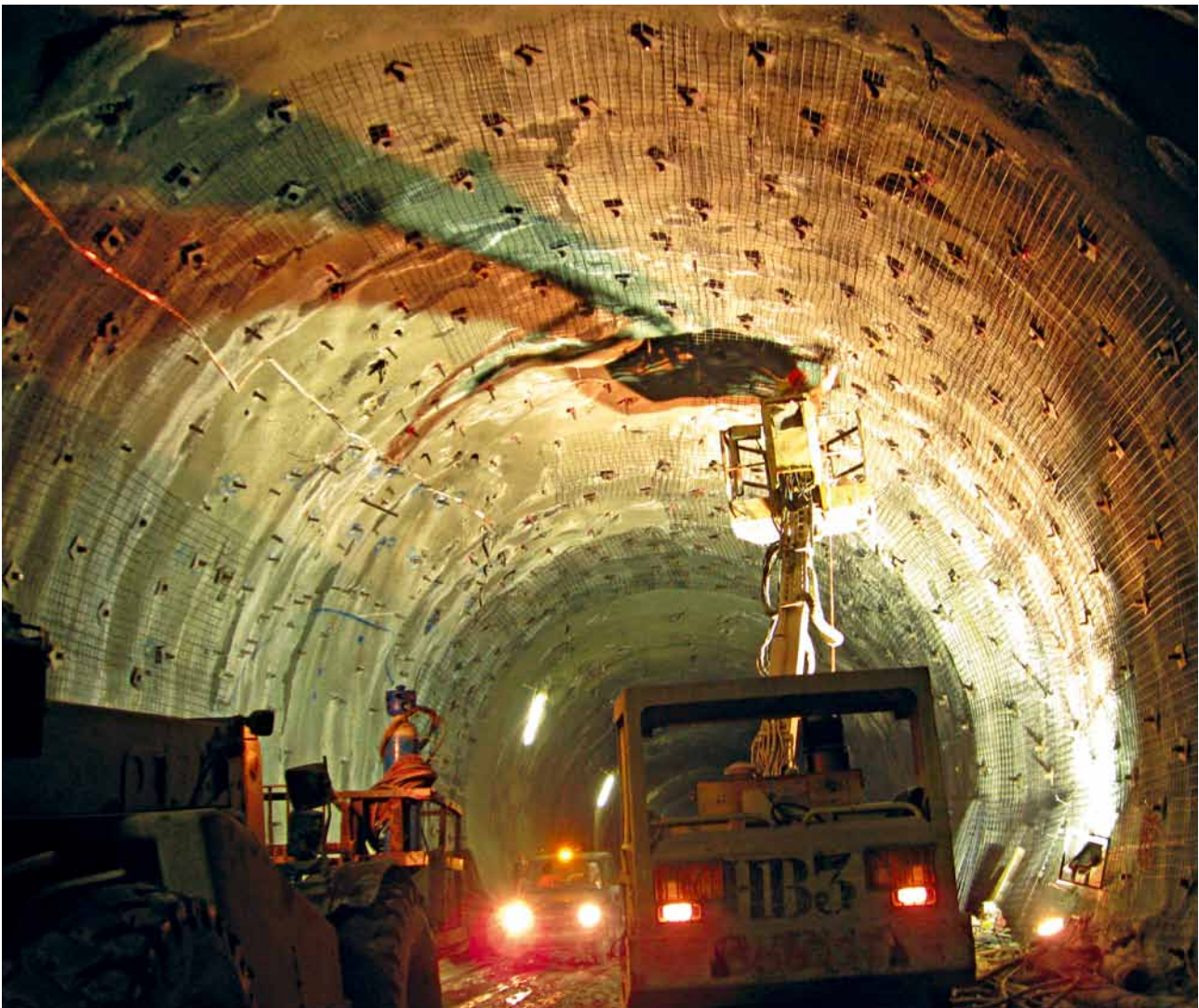
6 Anker als Zusatzmassnahme für Ausbruch Querschlag Anchors as additional measure for cross-passage excavation
