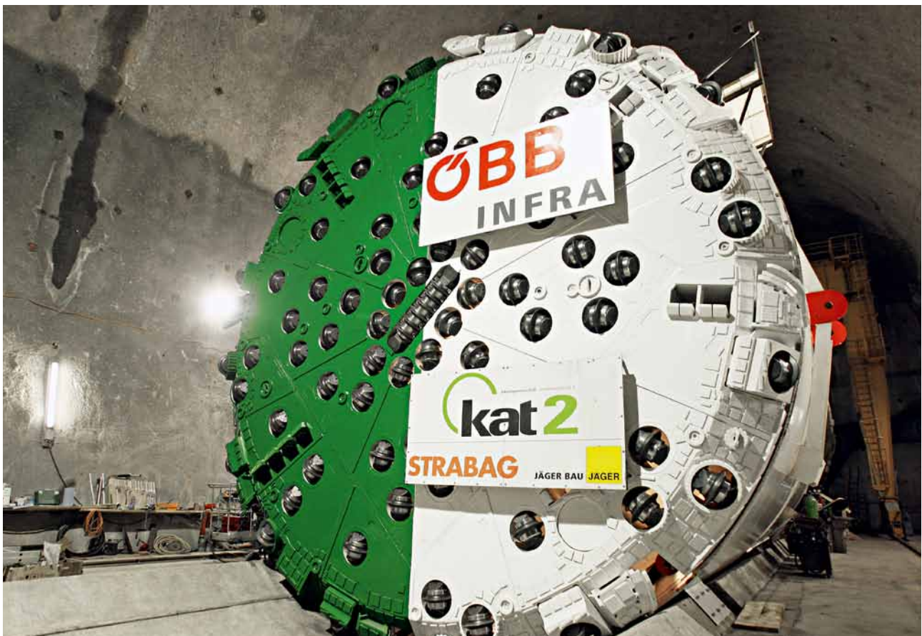
10a Bohrkopf Doppelschild Tunnelbohrmaschine Nord mit 9,93 m Durchmesser Cutterhead of the double shield tunnel boring machine north with 9.93 m diameter
