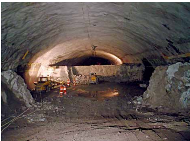
14 Ausbruch der zweiten Stufe der Maschinenkaverne KMA Excavating the second stage of the machine cavern KMA
