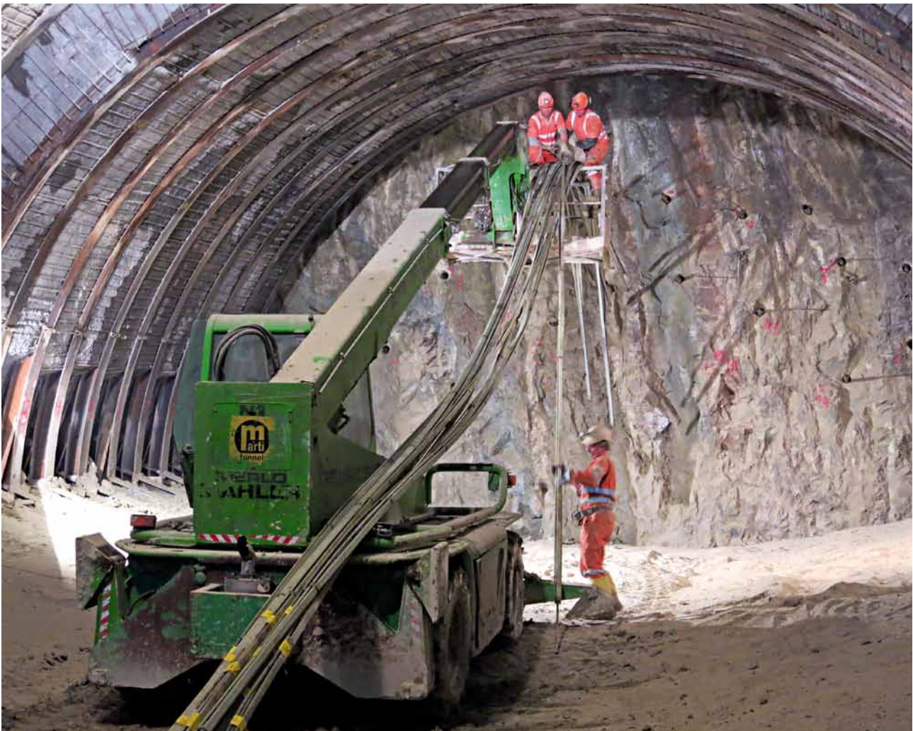
10 Versetzen der Ortsbrustanker Placing the face anchors
