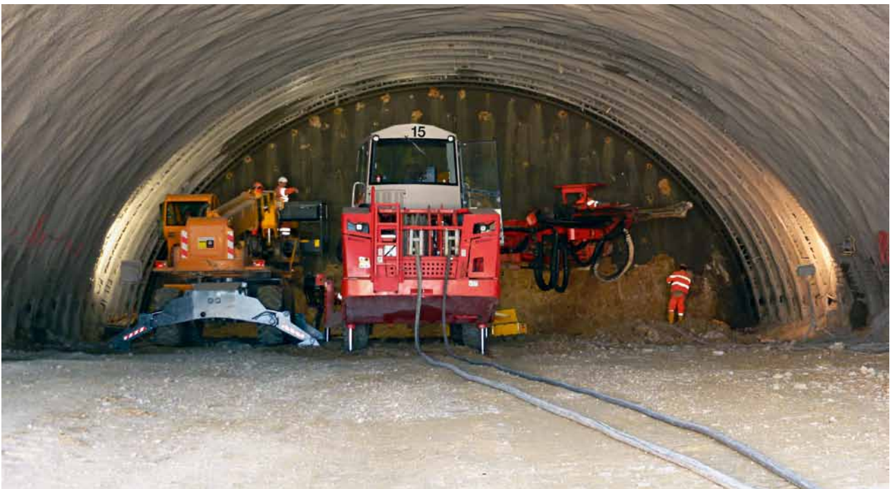
3 Sprengvortrieb Kalotte 3-Spurprofil Engi Engi 3-lane crown drill&blast drive
