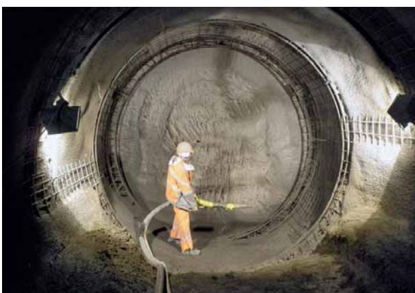
19 Sicherungsarbeiten im gefrorenen Querschlag Supporting work in the frozen cross-passage
