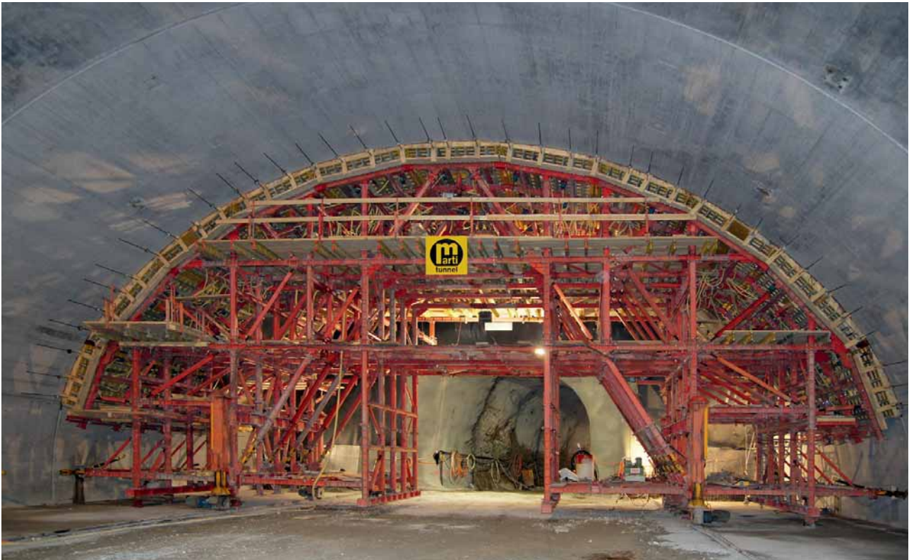
9 Gewölbeschalung der Lüftungskaverne Süd Vault formwork for the south ventilation cavern
