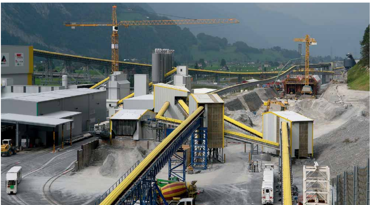
3 Materialbewirtschaftungsanlage auf der Baustelle Erstfeld Material management facility on the Erstfeld construction site
