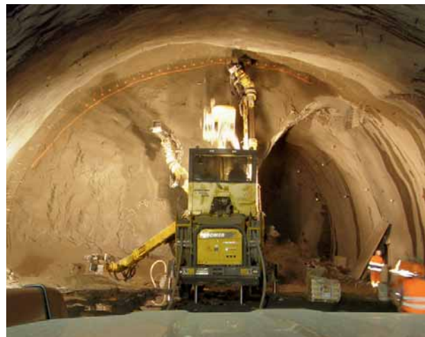
10 Kavernenausbruch Cavern excavation
