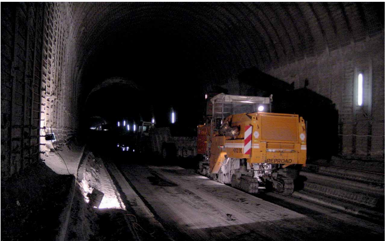
6 Grossfräse Wirtgen im Einsatz Large cutting machine from Wirtgen in operation
