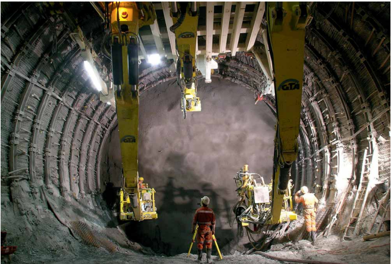
1 Sedrun – Streckenausbaumaschine Tavetscher Zwischenmassiv Nord Sedrun – Tavetsch Intermediate Massif (TzM) North roadway support machine
