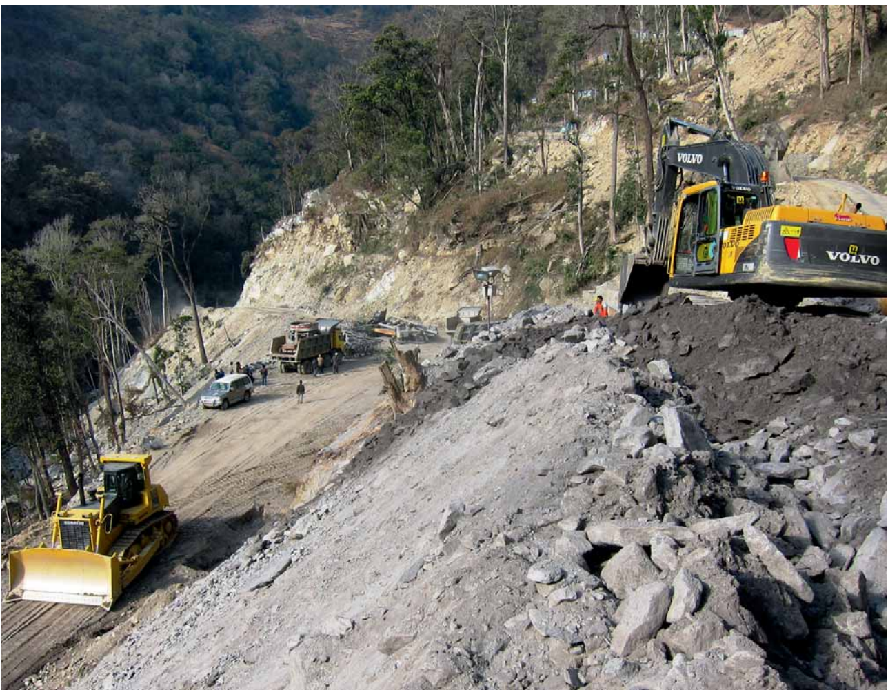
11 Terrassierungsarbeiten in steilem Gelände: Gewinnung ebener Flächen für Camp und Werkstätten Terracing works in sloping terrain: reclamation of flat areas for camp and workshop
