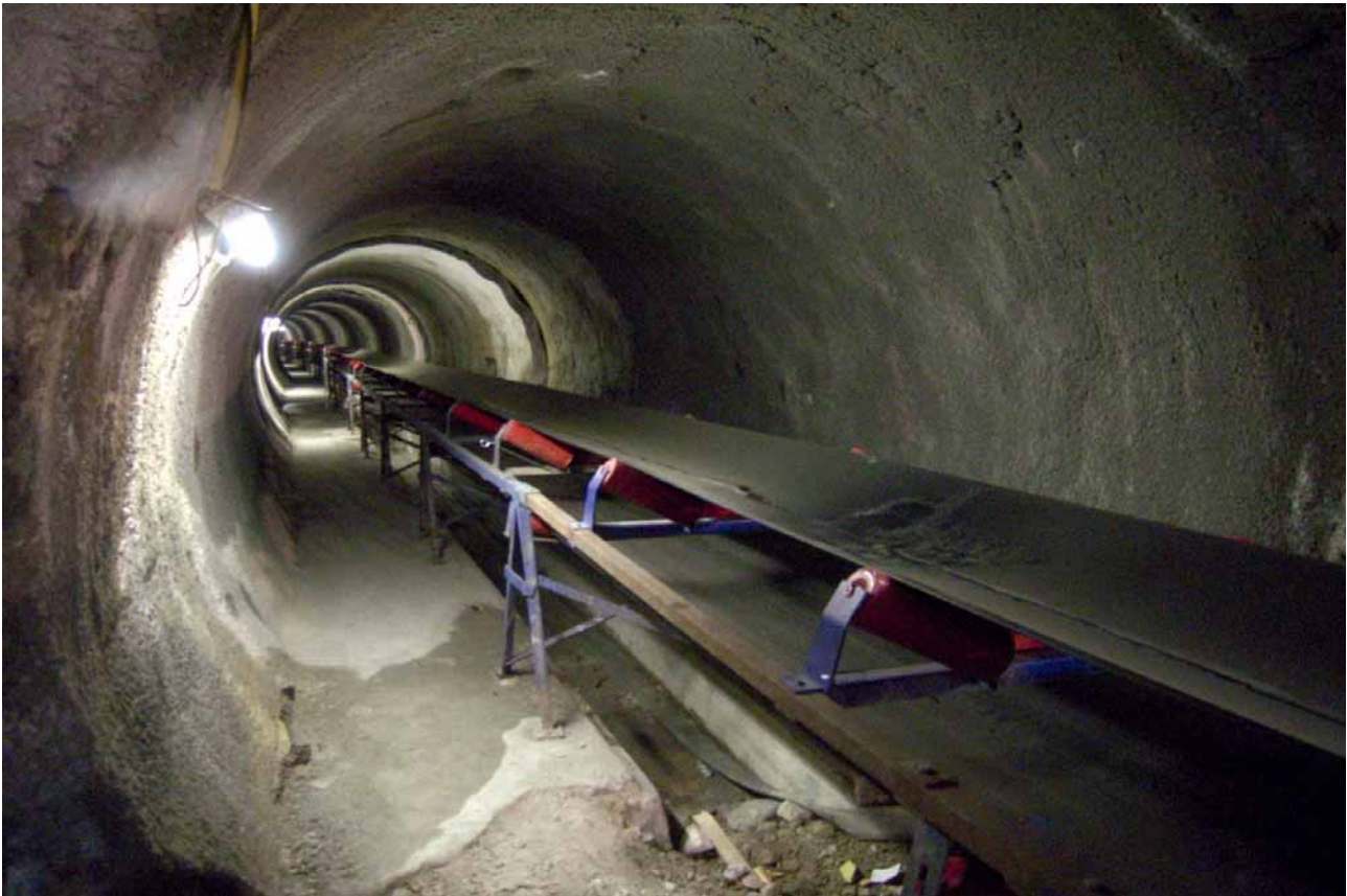
12 Förderband im Pilotstollen Belt conveyor in the pilot tunnel
