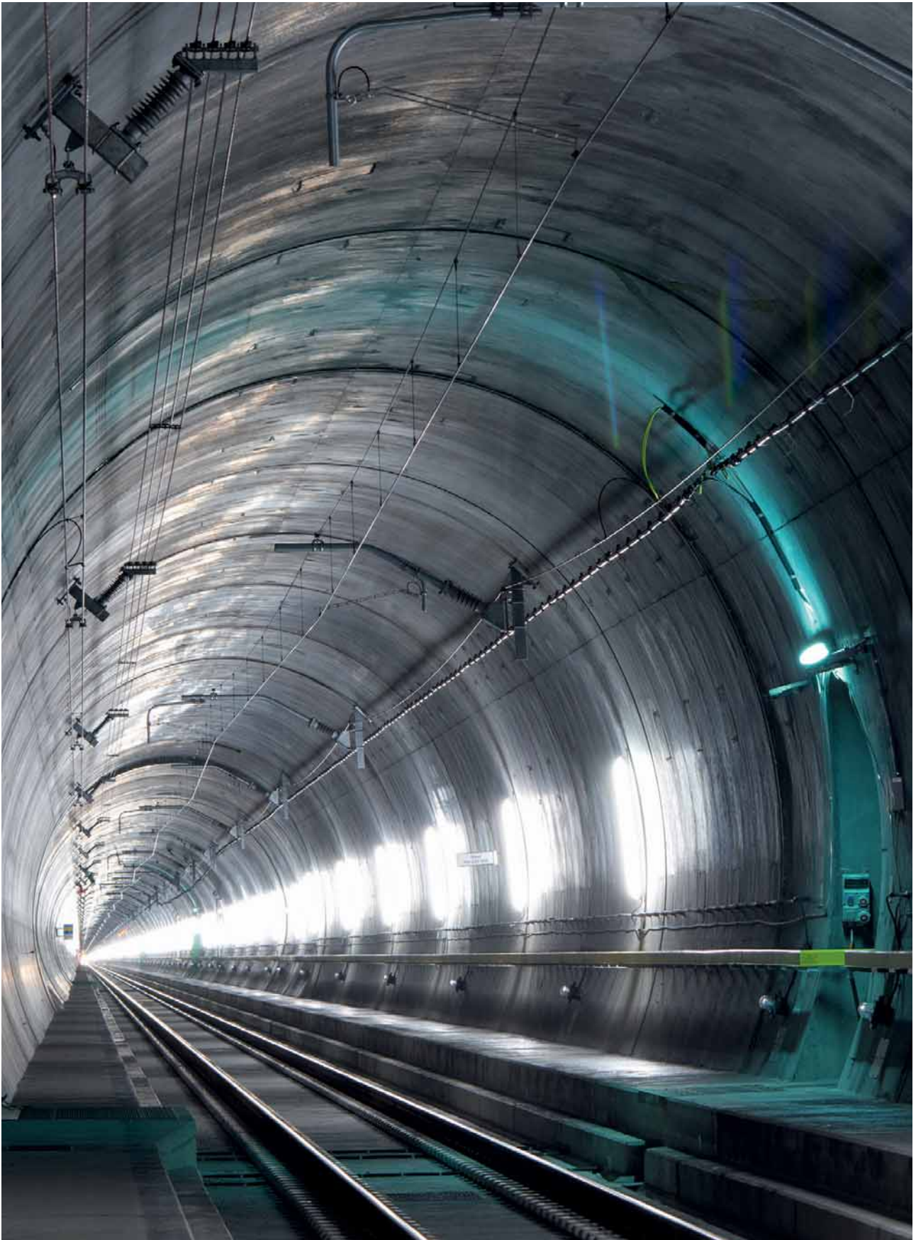
11 Fertig ausgerüsteter Tunnelabschnitt Faido-Bodio West Completely equipped tunnel section Faido-Bodio West
