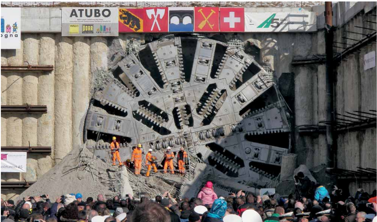
22 Durchschlag des zweiten Längholtunnels Breakthrough of the second Längholz Tunnel
