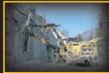
H 182, Tunnel de la Poya (FR)
