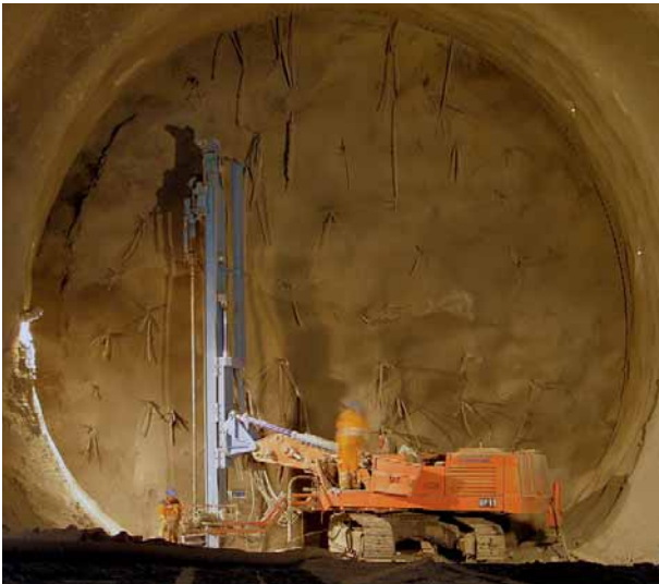
6b Bauausführung Bauhilfsmassnahmen an der Ortsbrust Execution of ancillary measures of construction at the face
