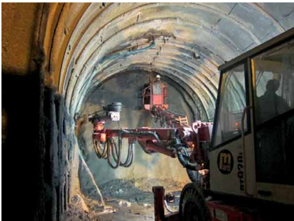
4 Vortriebsarbeiten im Adit 3: Fellsicherung durch Stahlbögen Driving operations in Adit 3: securing the rock with steel arches
