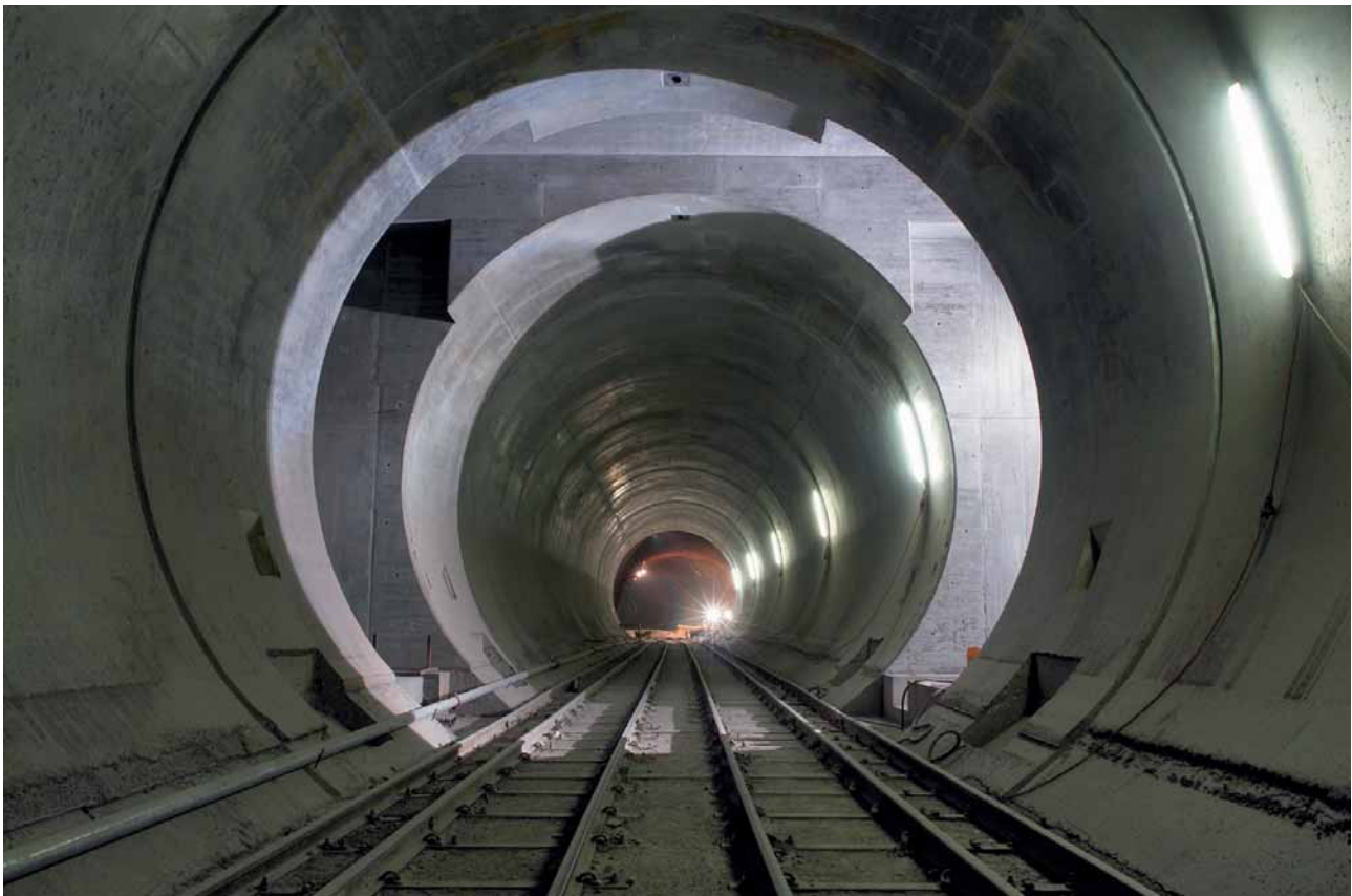
7 Betonierte Nische für das Spurwechsellor Nord in der Multifunktionsstelle Faido Concreted niche for the North track crossover point in the Faido multi-function station
