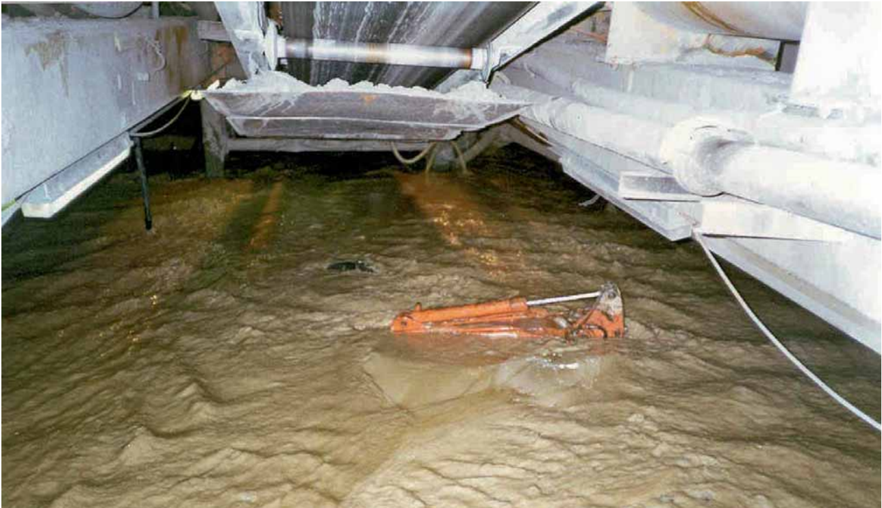
6 Überflutete TBM im Sondierstollen Piora Flooded TBM in the Piora exploratory tunnel
