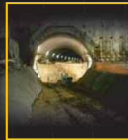
A16, Tunnel de Sous le Mont (BE)
