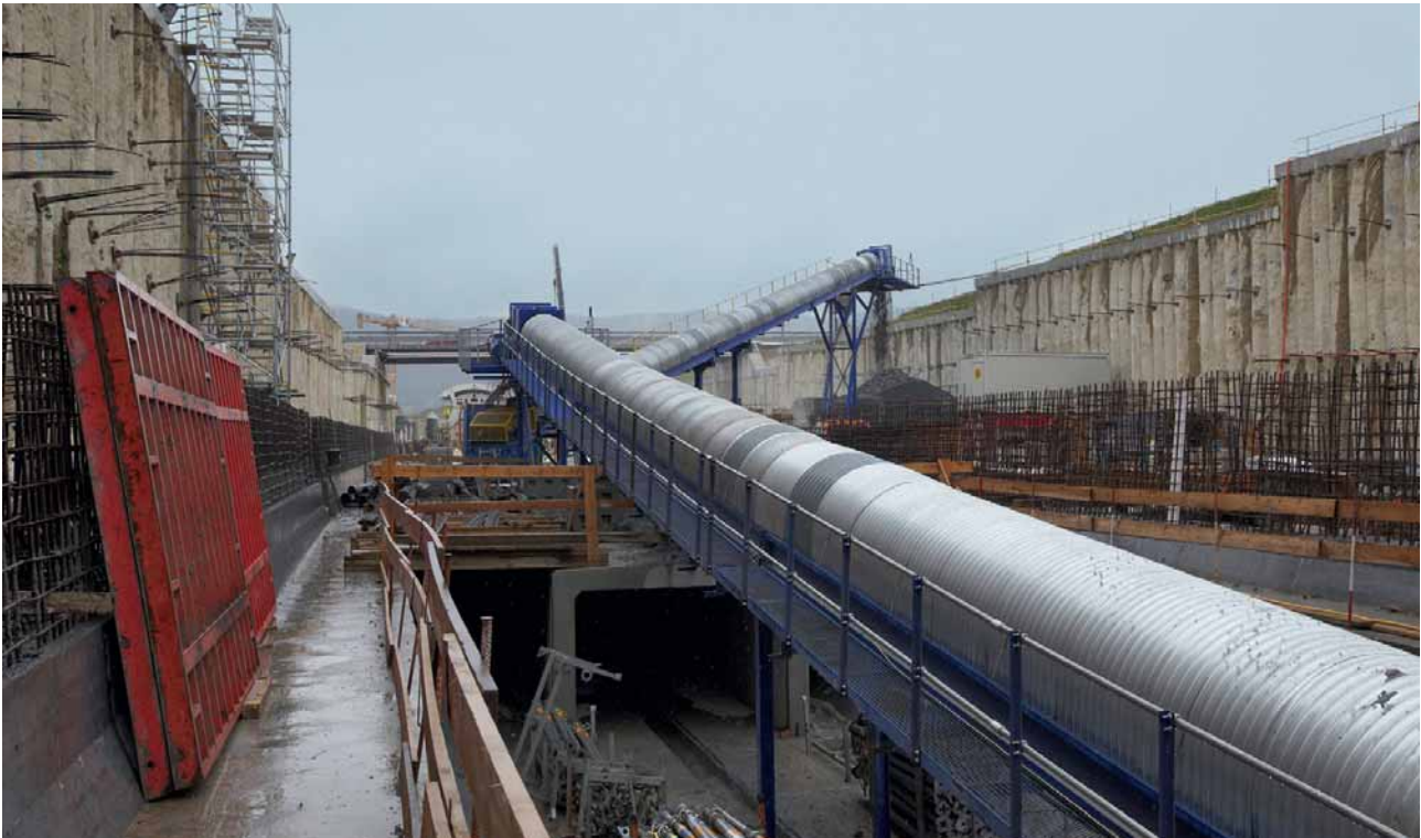
13 Provisorischer Bandabwurf vor der Fertigstellung des Werkleitungskanals im Tagbau Nord Temporary belt discharge prior to completion of the utility duct
