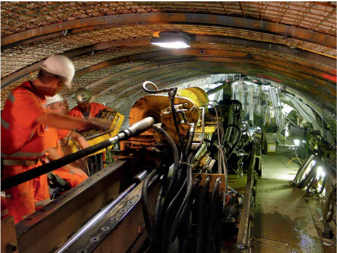
9 Sondierbohranlage auf der Tunnelbohrmaschine vor der Piora-Mulde Exploratory drilling unit on the tunnel boring machine in front of the Piora Basin
