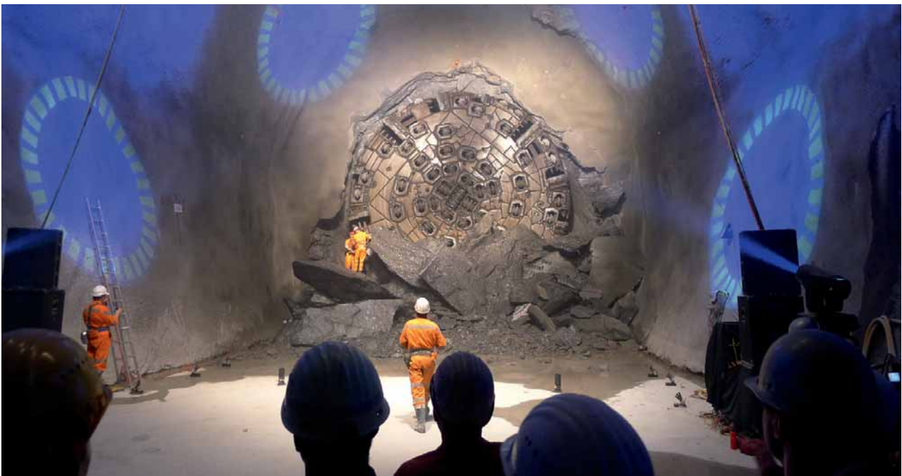
8 Durchschlag Weströhre am 23. März 2011 Breakthrough of western bore on March 23, 2011
