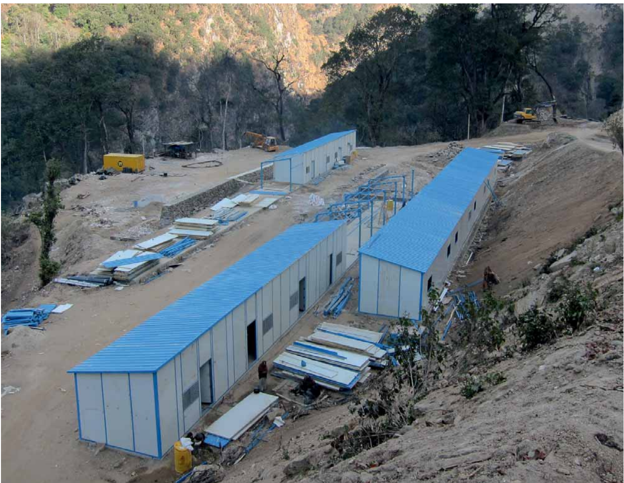
12 Baustellencamp: Die Arbeiterunterkünfte sind im Entstehen Site camp: accommodation for the workforce being set up
