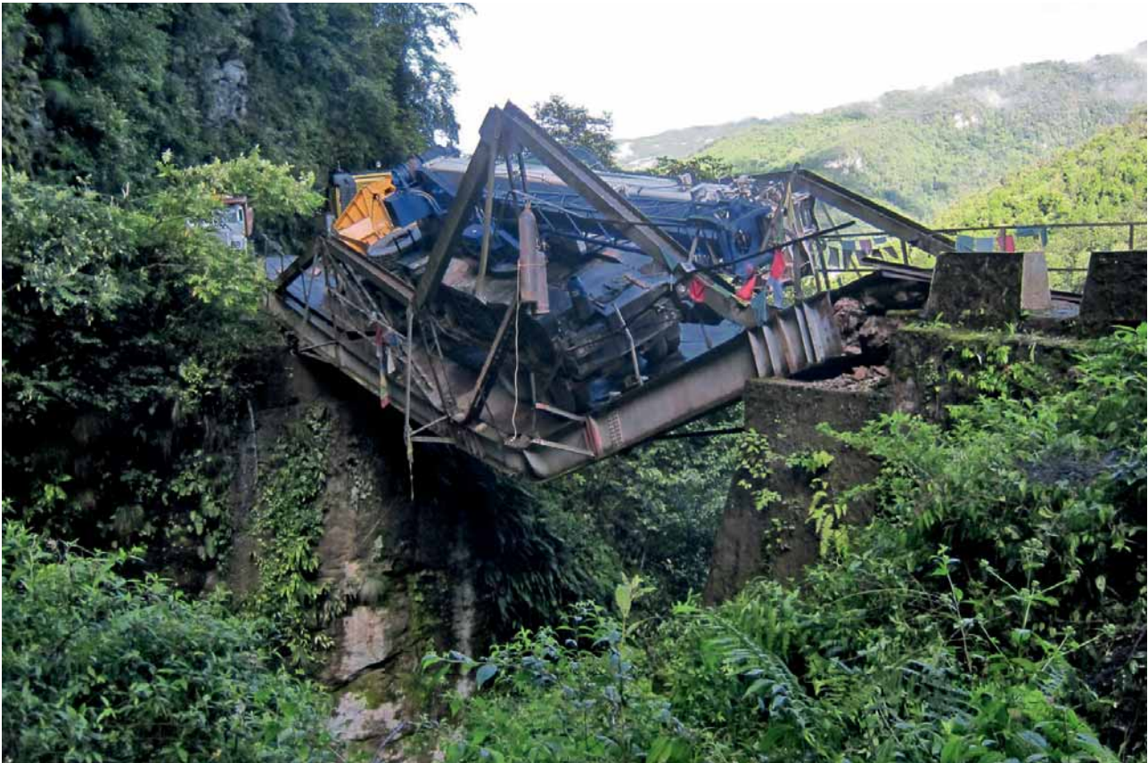
5 Ein Sattelzug brachte die National Highway-Brücke zum Einsturz und störte die Versorgung der Baustelle über mehrere Wochen empfindlich An articulated truck caused the national highway bridge to collapse and seriously impeded supply of the site for a number of weeks
