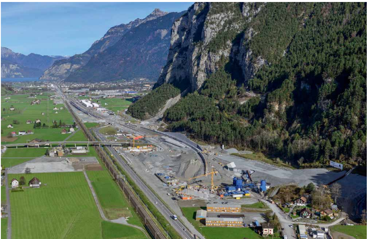
7 Blick auf die Linienführung im Kanton Uri und den Installationsplatz Erstfeld View of the route alignment in the Canton of Uri and the Erstfeld installation yard
