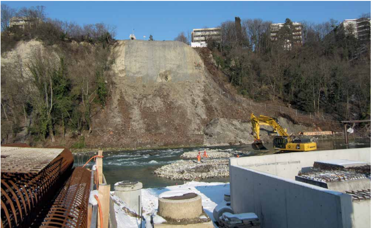
10 Ansicht des Voreinschnitts an der Falaise für das Tunnel-Südportal im Februar 2013 View of the precut at Falaise for the tunnel south portal in February 2013
