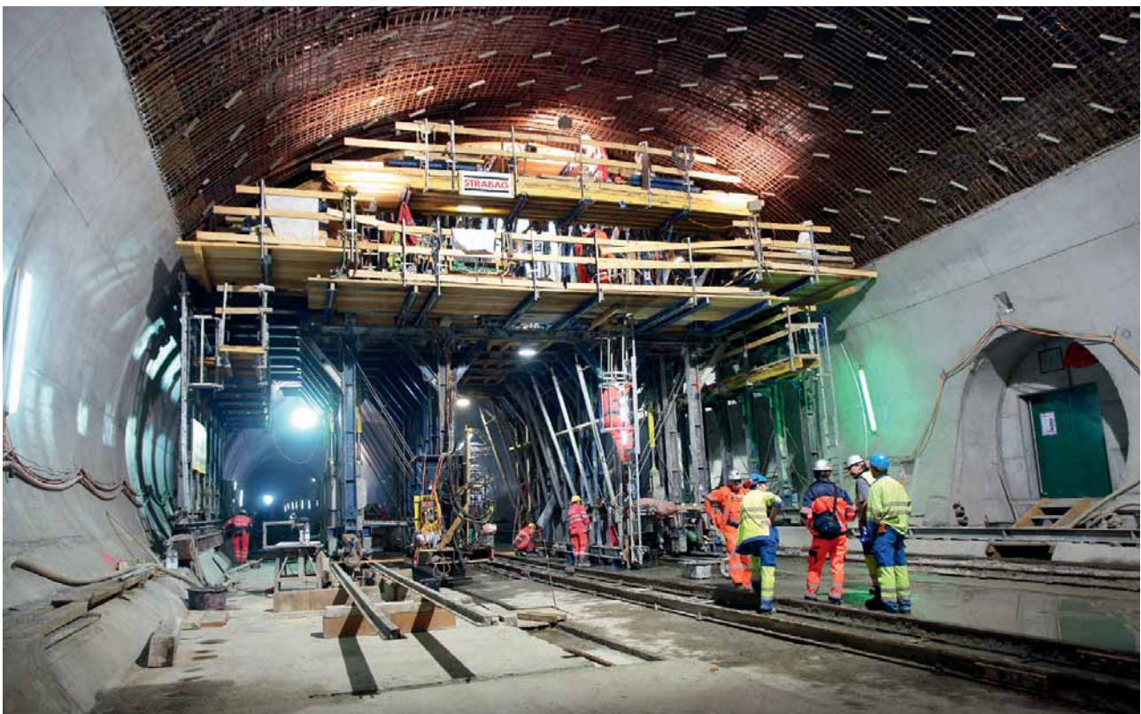
2 Verzweigungsbauwerk Erstfeld Erstfeld branch-off construction
