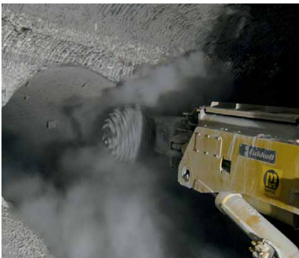
2 Absaugung über Pilotstollen bei TSM Suction via pilot tunnel for roadheader
