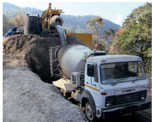
8 Behelfsmässige Spritzbetonproduktion bis zur Inbetriebnahme der grossen Betonmischanlage Provisional production of shotcrete until the large batching plant will be in operation
