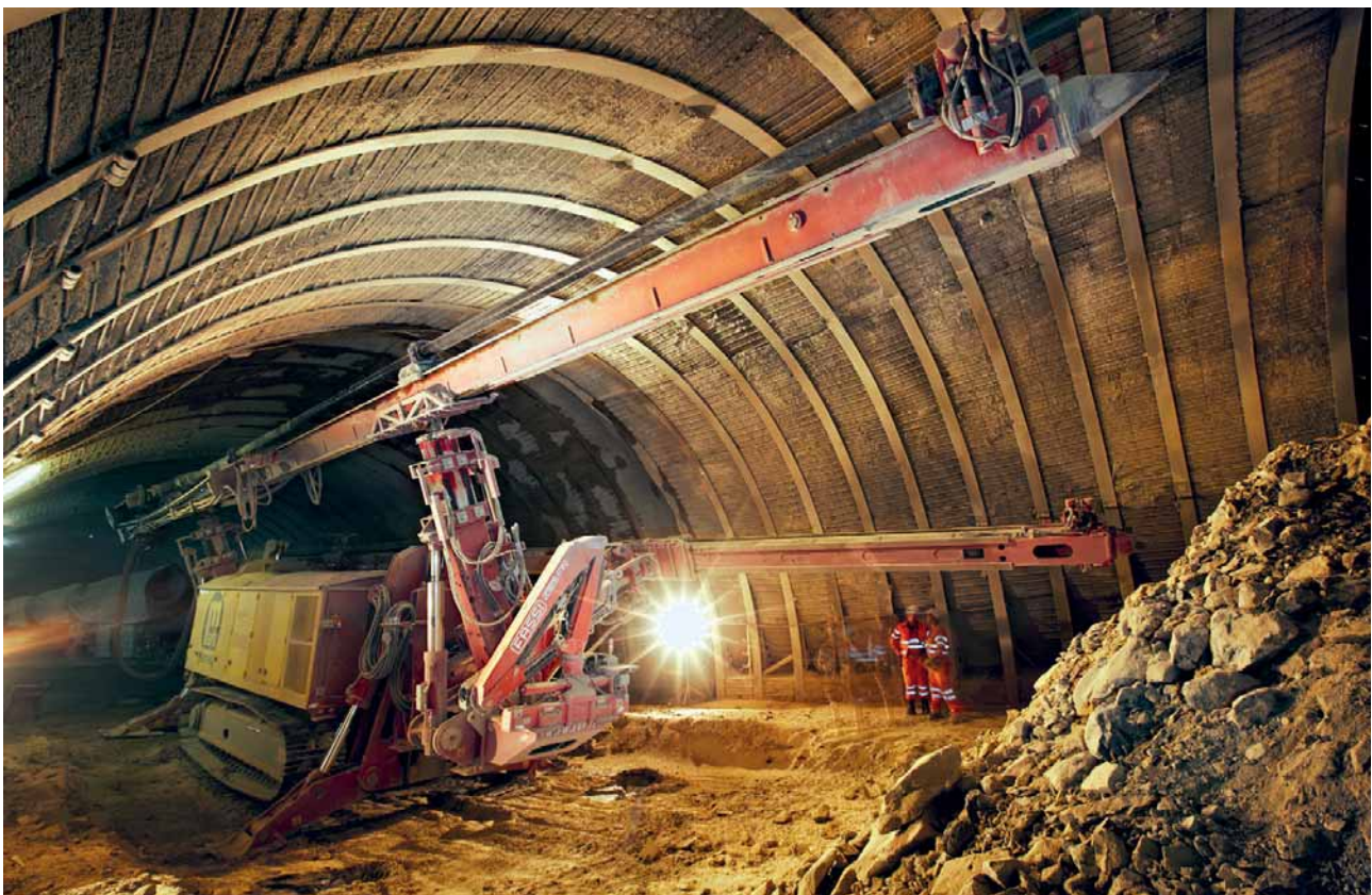
10 Zweiarmiges Rohrschirm-Bohrgerät EGT TD4025 im Einsatz 2-arm pipe umbrella drilling rig EGT TD4025 in operation
