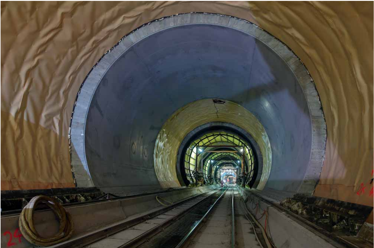
3 Betonetappe im Teilabschnitt Amsteg Concreting stage in the Amsteg section
