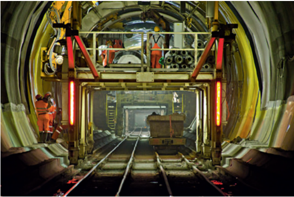
4 Innenausbau Sedrun Sedrun inner lining
