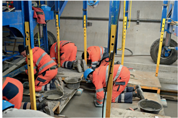
12 Der Betoneinbau – Handarbeit zur Herstellung der geforderten Fahrbahnoberfläche Placing the concrete – manual work to create the necessary track surface (Foto/Photo: TTG)
