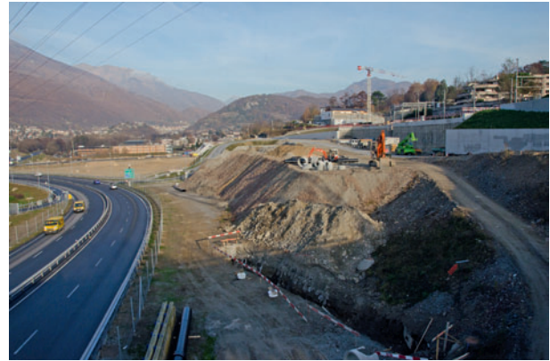
13 Vezia: Portalbereich Vezia: portal area
