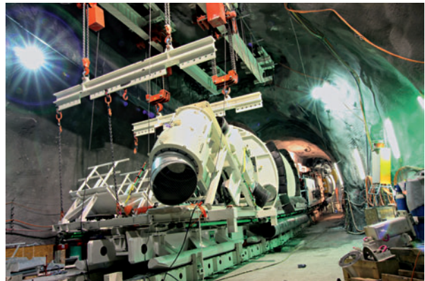
7 Montage der TBM unter Tag TBM assembly underground
