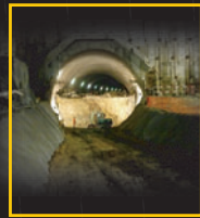
A16, Tunnel de Sous le Mont (BE)
