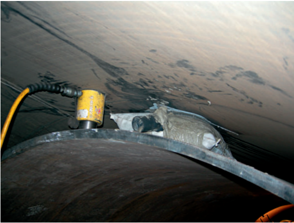
11 Bullflex im Ringspalt zwischen alter und neuer Panzerung in Cleuson-Dixence Bullflex in the annular gap between old and new steel lining at Cleuson-Dixence
