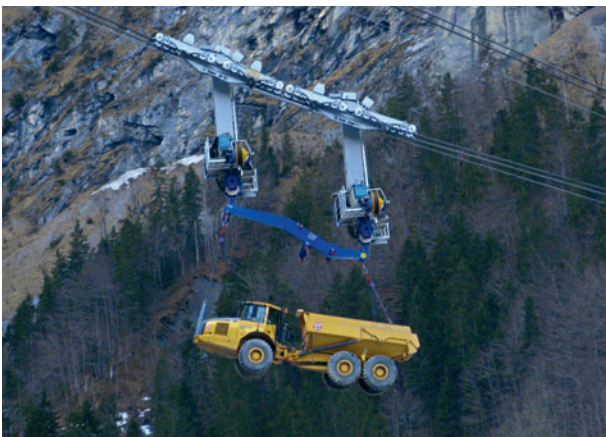
2a+b Seilbahntransport von Baugerät Cable railway transport of construction equipment
