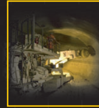
A5, Tunnel de Serrières (NE)
