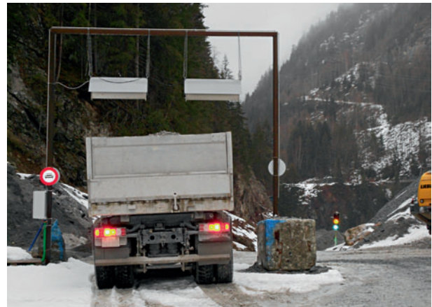
8 Messportal für radioaktives Ausbruchmaterial Measurement portal for radioactive excavated material
