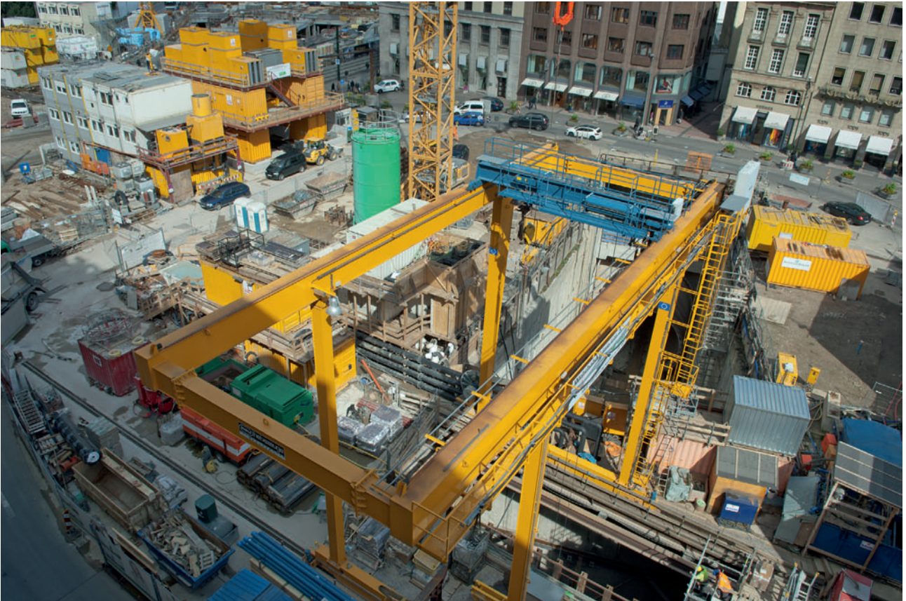
12 Startbaugrube in Deckelbauweise an der Königsallee/Düsseldorf Stadtmitte Starting shaft in top down construction method at the Königsallee in Düsseldorf city
