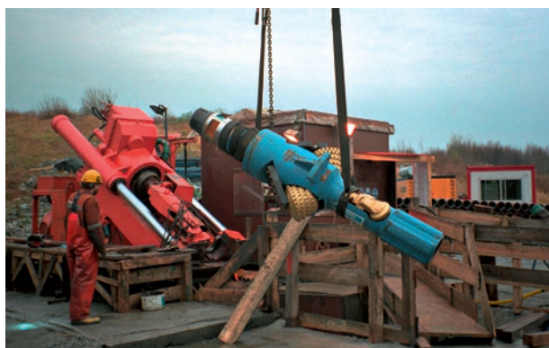
2 Raise-Boring-Anlage auf einer Staumauer Raise-boring unit on a dam
