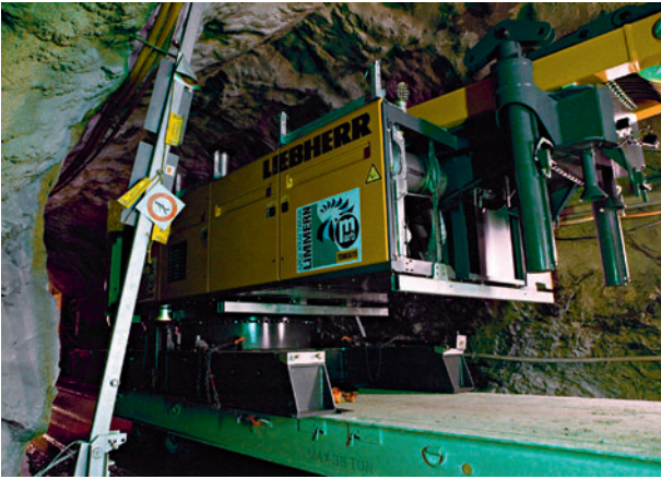
3 Transport eines zerlegten Baugeräts durch einen Stollen Transporting dismantled construction equipment through a tunnel
