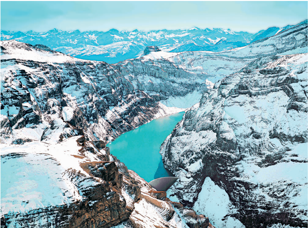
1 Stausee Limmern Limmern dam
