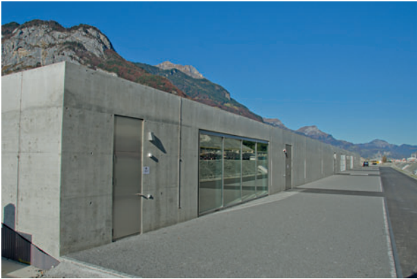
2 Bahntechnikgebäude Erstfeld Erstfeld rail technology building
