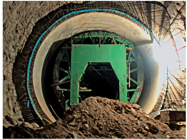
3 Betonauskleidung des Druckstollens (Durchmesser 8.5 m) der Wasserkraftanlage Seymareh im Iran. Sichtbar ist der Teleskopschalwagen sowie die Anschlussbewehrung und das Fugenband für die nächste Betonieretappe Concrete lining for the pressure tunnel (8.5 m diameter) of the Seymareh hydropower plant in Iran. The telescopic formwork carriage as well as the connecting reinforcement and the water-stop for the next concreting stage are visible (Quelle/Source: Schleiss, Januar 2009)
