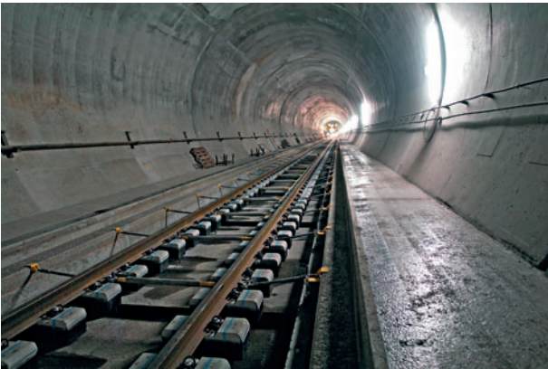
5 Vorbereitetes Gleisrost vor Betoneinbau Prepared track grid prior to concrete being placed (Foto/Photo: TTG)
