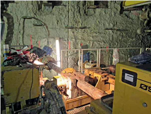
5a+b Horizontalbohrarbeiten Horizontal drilling work
