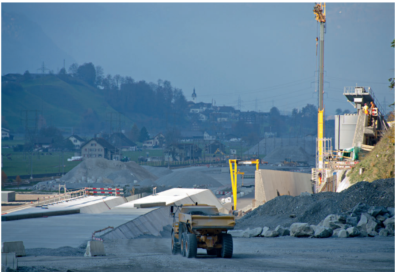
1 Überschüttung Tagbautunnel Erstfeld Erstfeld cut-and-cover tunnel covered
