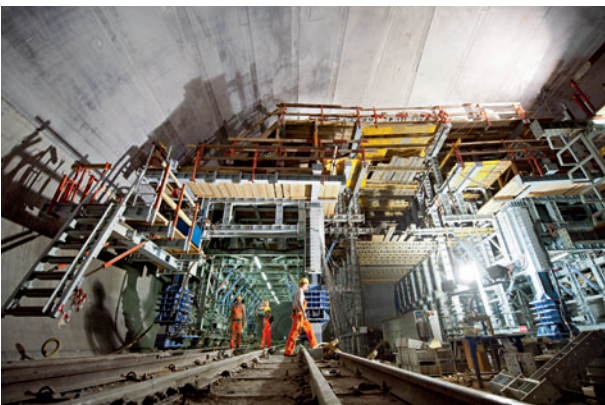
6 Faido: Betonarbeiten Oströhre, Spurwechsel Süd Faido: Concreting work, eastern bore, South crossover
