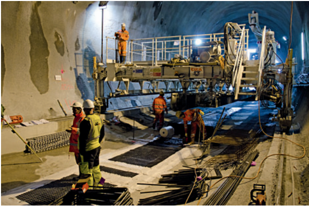
12 Vezia: Erstellung der definitiven Sohle Vezia: Creating the definitive floor
