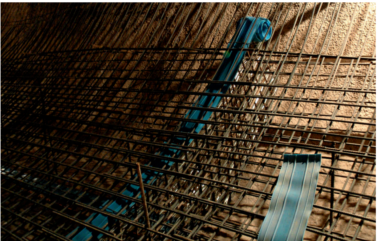
10 Zweilagige Bewehrung zur Risseverteilung in der 80 cm dicken Betonauskleidung des Druckstollens der Wasserkraftanlage Upper Gotvand im Iran. Sichtbar ist das für die Betonieretappe eingelegte Fugenband Twin-layer reinforcement to distribute the cracks in the 80 cm thick concrete lining for the pressure tunnel of the Upper Gotvand hydro-power plant in Iran. The waterstop installed for the concreting stage is visible (Quelle/Source: Schleiss, Januar 2009)
