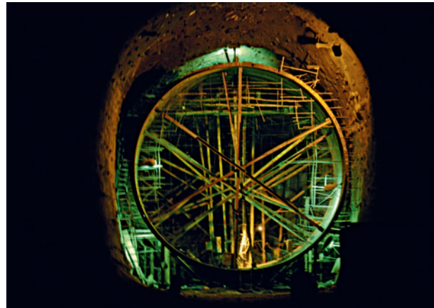
4 Stahlpanzerung der Druckschächte (Durchmesser 7.0 m) der Wasserkraftanlage Upper Gotvand im Iran. Die montierte Panzerung ist ausgesteift und vorbereitet zum Hinterfüllen mit Beton
