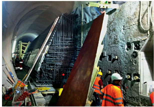
9 Bewehrung Längsträger/Abfangdecke Reinforcement longitudinal girders/bracing cover
