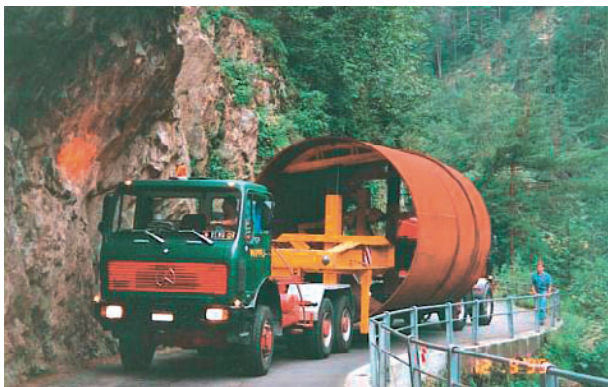
1a+b Transport eines Panzerungsrohres auf Passstrasse Transporting a lining pipe over a pass road
