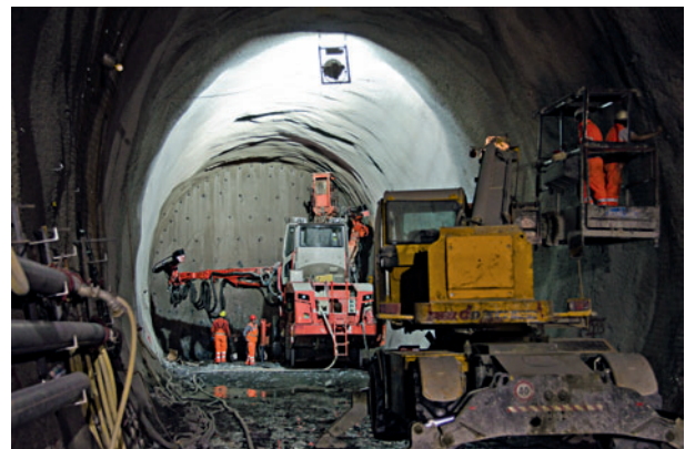
11 Sigirino: Vortrieb mit Bohrjumbo, Bohren der Löcher Sigirino: Driving with drilling jumbo, drilling the holes
