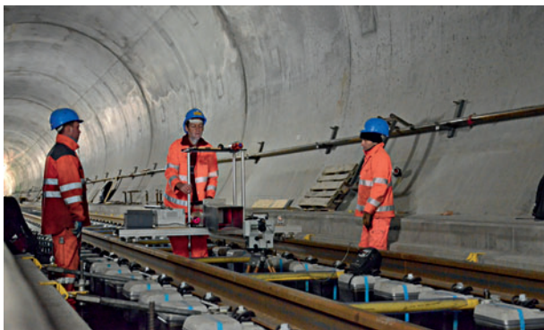
8 Feinvermessung und Schlussausrichten des Gleisrostes – letzter Arbeitsschritt vor dem Betoneinbau Fine surveying and final aligning of the track grid – last working step prior to placing the concrete (Foto/Photo: TTG)
