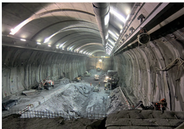
10 Ausbruch Maschinenkaverne Machine chamber excavation
