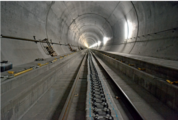
7 Logistische Vorbereitungen zum Gleisbau Logistical preparations for track laying (Foto/Photo: TTG)
