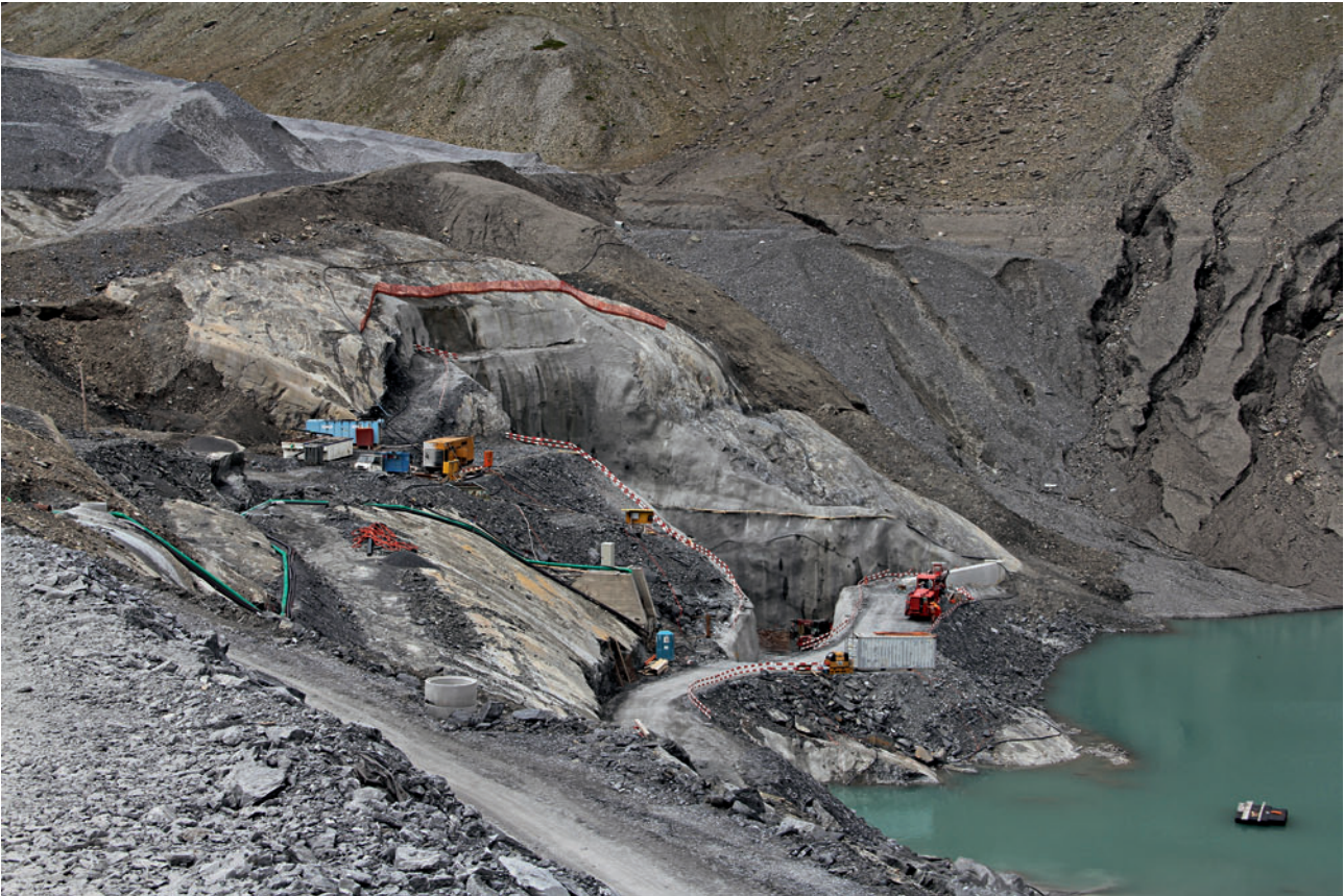
7 Ein-/Auslaufbauwerk Muttsee Intake/outlet structure Muttsee
