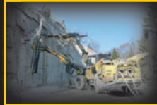
H 182, Tunnel de la Poya (FR)
