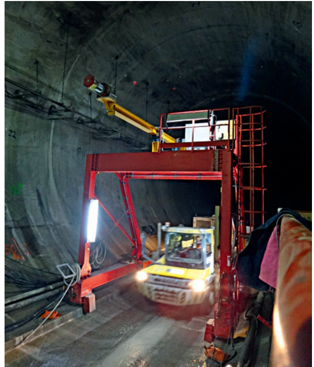
15 Vermessungseinheit mit Rotationslaser Monitoring system with laser scanner
