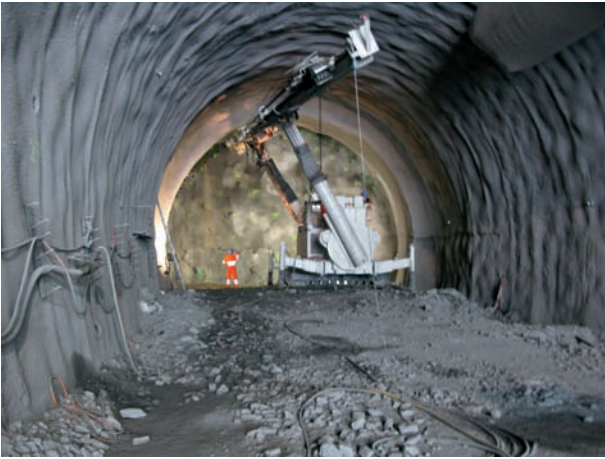
10 Jettinggerät im Ausfahrtunnel Jetting unit in the exit tunnel
