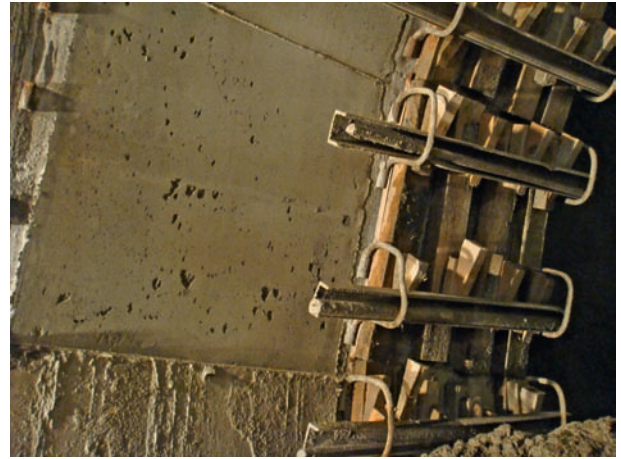
5 Ausbruchsicherung nach Russischer Methode und Detail mit Ortbeton und ausgesteifter Schalung (rechts) The Russian method of rock-fall protection, showing a detail of in-situ concreting and braced formwork (right)
