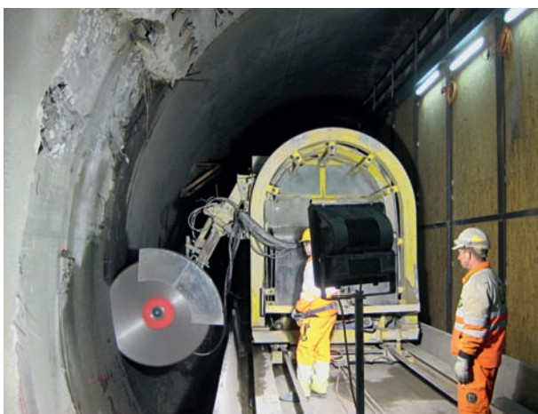
13 Gewölbesanierungskomposition Tunnelfräse Lining-repair train formation, tunnel cutter
