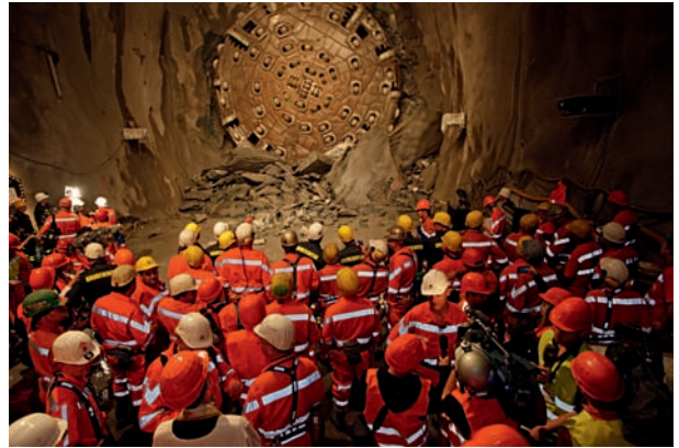
4 Der Bohrkopf ist durch! Grosser Moment im Durchschlag des Gotthard-Basistunnels am 15. Oktober 2010 The cutter head is through! The great moment at the Gotthard Base Tunnel breakthrough on October 15, 2010 Quelle/Source: ATG
