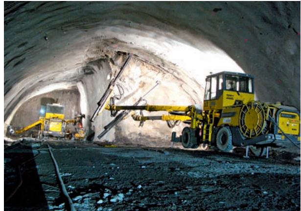
9 Ausbruch- und Sicherungsarbeiten in der Verzweigungskaverne Süd
