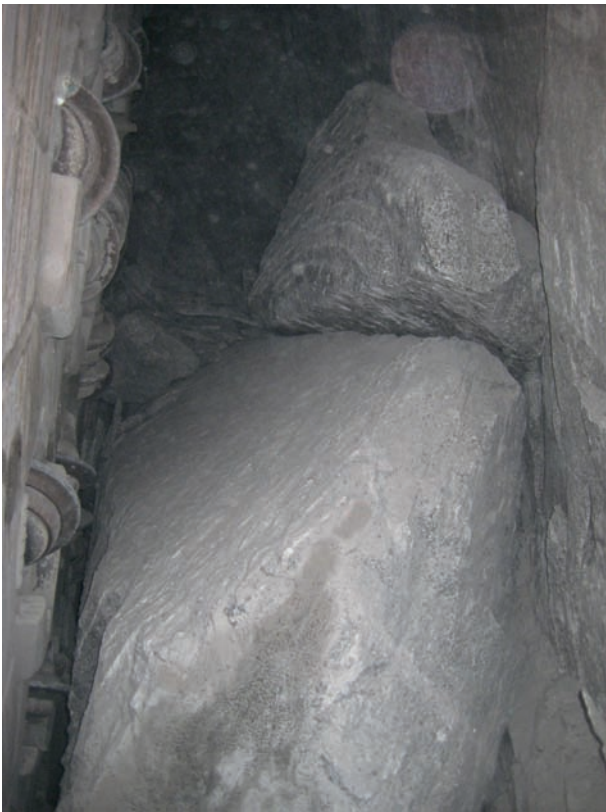
4 Aufnahme der Ortsbrust von km 228.718, deutlich erkennbar sind die Spurrillen beim oberen Block View of the face at km 228.718; the grooves in the upper block are clearly apparent (Foto/photo: F. Habit)
