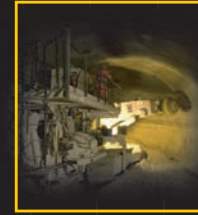
A5, Tunnel de Serrières (NE)
