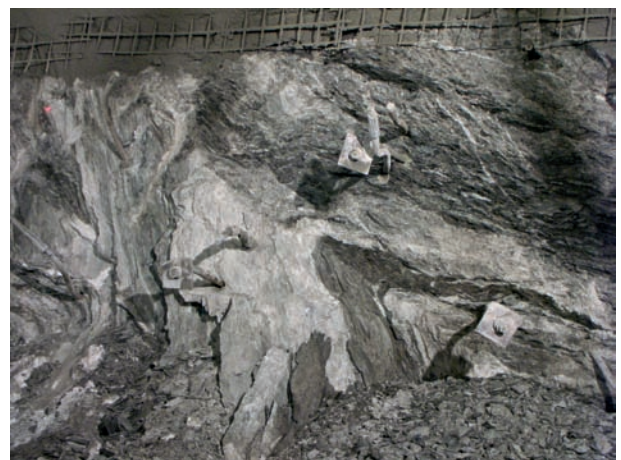
3 Tavetscher Zwischenmassiv Nord: kataklastisch bis kakiritischer Gneis mit Verfaltung (km 120.537) The northern Tujetsch median massif: cataclastic to kakiritic gneiss with folding (km 120.537) (Foto/photo: P. Guntli)
