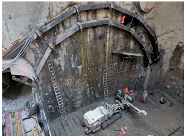
10 Ansicht der Injektionsbohrungen des Dichtblocks Holes for grouting of the sealing block
