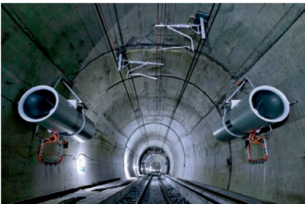
1 Der Lötschberg-Basistunnel, eine technische Meisterleistung in kürzester Bauzeit The Lötschberg Base Tunnel, a technical masterpiece achieved in an ultra-short space of time Quelle/Source: BLS
