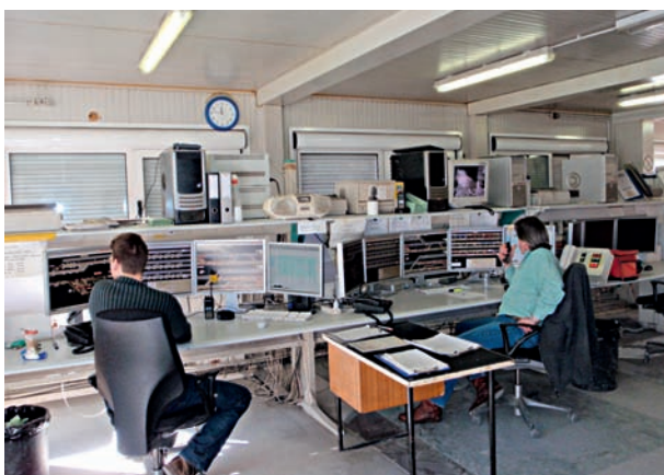
3a Zentrale Zugleitstelle auf dem Installationsplatz Bodio The central train control facility at the Bodio work yard
