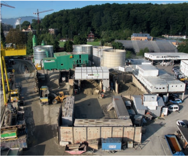
11 Installationsplatz Brunnenhof – Separieranlage Brunnenhof work yard – separation plant
