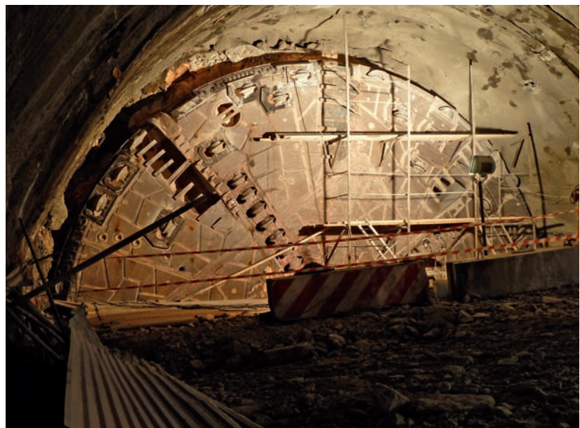
8 Verbruchmaterial in den Diskenkästen (links) und der freigelegte Bohrkopf (rechts) Collapsed rock in the cutter boxes (left) and the freed cutter head (right)
