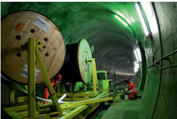
6 Als erste bahntechnische Installationen werden Kabel in die seitlichen Bankette eingebracht The cables – the first rail-equipment – are installed in the side bench
