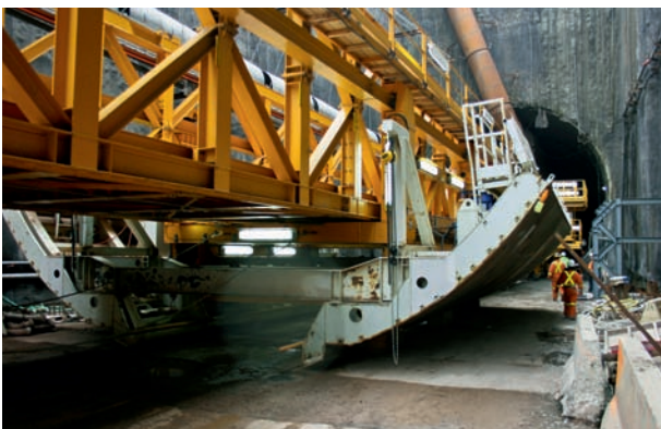
10 Schalwagen als Brücke Invert formwork bridge structure
