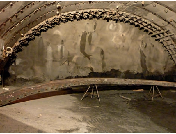
5 Ausbruchsicherung nach Russischer Methode und Detail mit Ortbeton und ausgesteifter Schalung (rechts) The Russian method of rock-fall protection, showing a detail of in-situ concreting and braced formwork (right)
