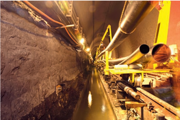
8 Arbeitsabschnitt 3, Rohrverlegearbeiten Phase 3: pipe installation work
