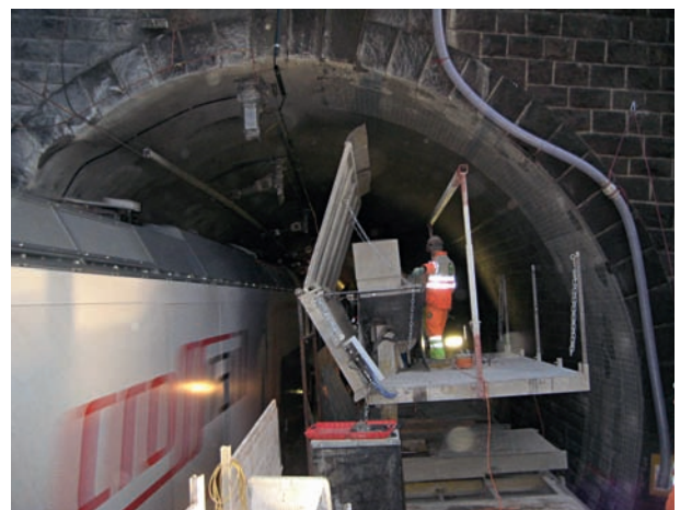
10 Arbeitsbühne mit Schutzwand Work platform, showing safety wall
