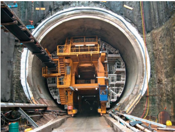
11 Schalungswagen für Innengewölbe – Juni 2010 Formwork for final lining – June, 2010
