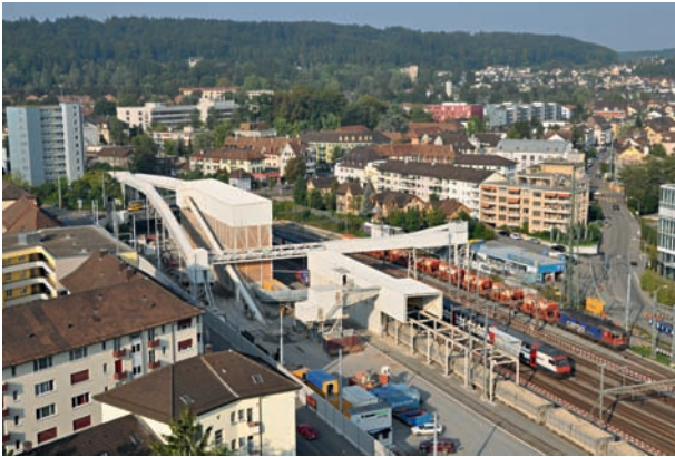
8 Übersicht Ver- und Entladeanlage in Oerlikon Overview of the loading/unloading facility in Oerlikon
