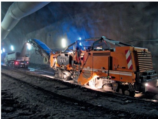
7 Fräse für Ausbruch Werkleitungskanal Cutter for excavation of service duct
