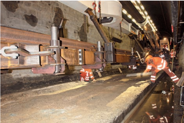
5 Arbeitsabschnitt 1, Hilfsbrückeneinbau Phase 1: installation of temporary bridges
