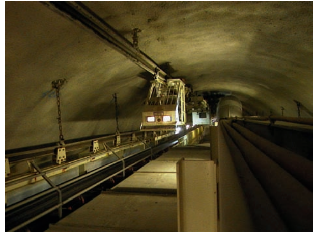
5 Einschienehängebahn zur direkten Versorgung der Arbeitsstellen (Gotthard-Basistunnel – Los Amsteg) Monorail for direct supply of work areas (Gotthard Base Tunnel – Amsteg section)
