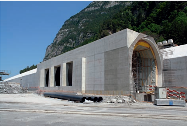
2 Tagbautunnel West mit Rezirkulationsschacht im Sommer 2010 The west cut-and-cover tunnel, showing the recirculation shaft, in the summer of 2010
