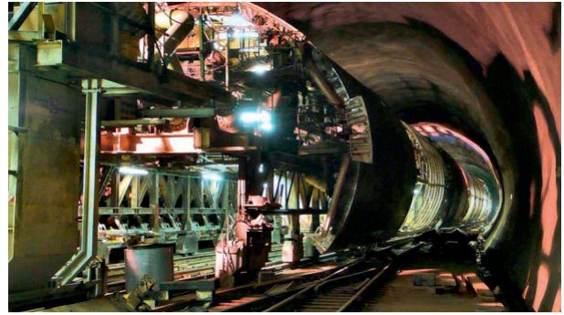
8 „Wurm“ Ost im Bereich der MFS Faido: Vor- und Nachläufer- schalung, „Elbogengelenk“ The east “worm” near the Faido MFS; preceding and trailing shuttering systems, “elbow joint”
