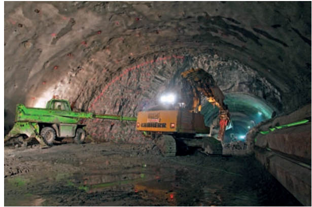
3 Ausbrucharbeiten am Verzweigungsbauwerk in der Weströhre Erstfeld Excavation work on the branch structure in the west bore at Erstfeld
