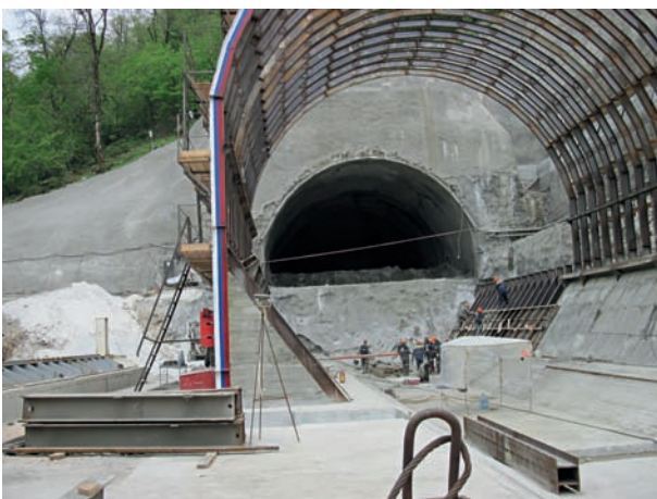
6 Portalbereich vor dem TBM-Start (links) und mit TBM-Bohrkopf (rechts) The portal zone prior to the TBM start (left) and with the TBM cutter head (right)
