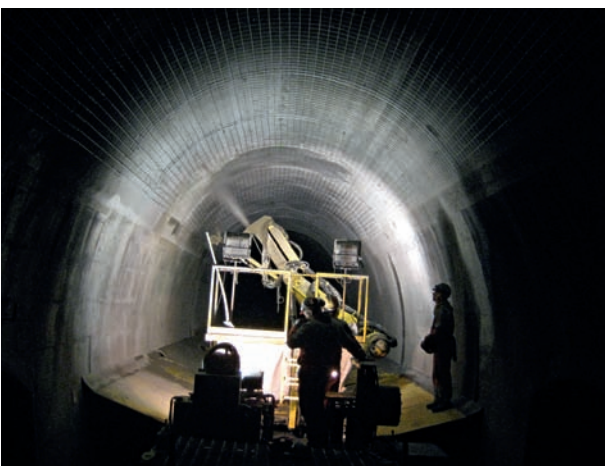
9 Gewölbesanierungskomposition mechanische Sanierung Lining-repair train formation, mechanical repair
