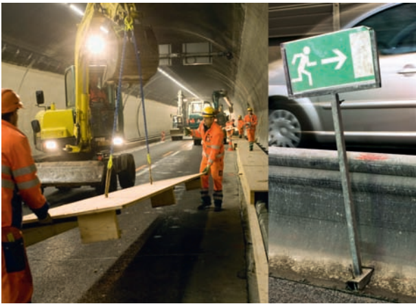
8 Abdecken der offenen Längsgräben vor Verkehrsfreigabe, Fluchtwegsignalisierung Covering of open longitudinal trenches prior to reopening to traffic, escape-route signposting
