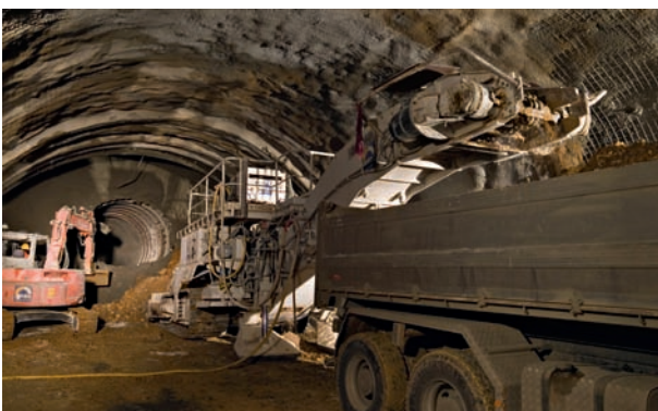
4 Pneubetrieb: Verlad TSM auf Lkw, Baustelle Tunnel de Serrière – Radlader-Dumper-Verlad Aeschertunnel Wheeled-vehicle operation: loading from road header to lorry, Tunnel de Serrière site; wheel loader-to-dumper loading, Aescher Tunnel
