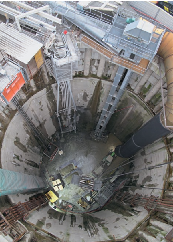
2 Förderbänder – Streckenbänder und Elevator – Baustelle Weinbergtunnel Belt conveyors – horizontal conveyors and elevator – the Weinberg Tunnel site
