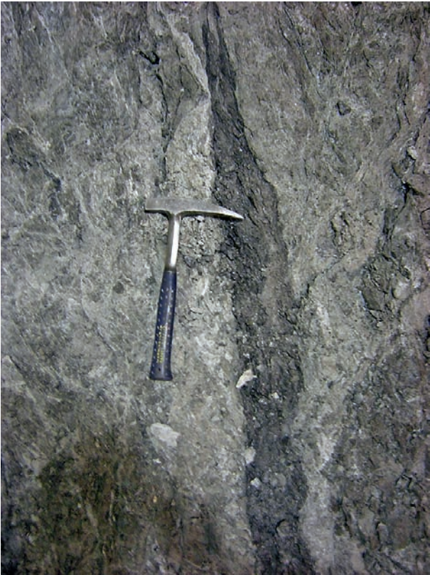
2 Öfital-Störung: Graphitlage in kataklastisch bis kakiritischem Gneis (km 103.863) The Öfital Fault: graphite stratum in cataclastic to kakiritic gneiss (km 103.863) (Foto/photo: S. Bucher)
