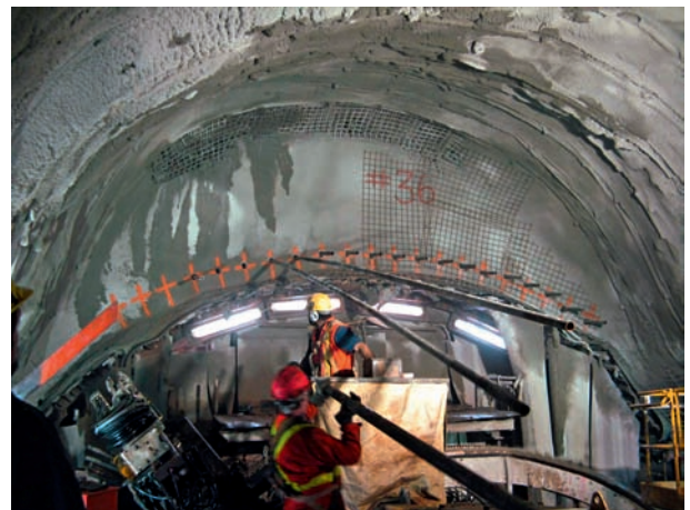
7 Zustand des Gebirges 2008 mit Rohrschirm Rock conditions 2008 – with pipe umbrella
