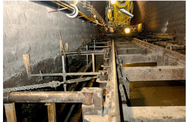
7 Arbeitsabschnitt 3, Sohlensanierungsarbeiten Phase 3: floor repair work
