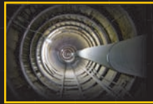
A16, Tunnel du Neu-Bois (JU)
