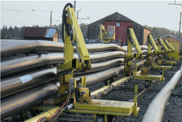
6 Rohrverlegezug auf der Rohrfertigungsstrasse Pipe-installation train at the pipe-fabrication station
