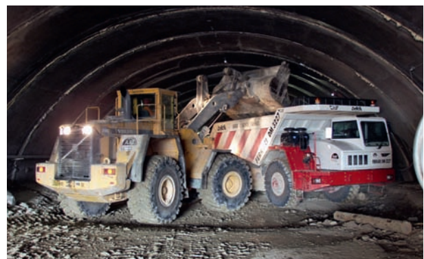
4 Pneubetrieb: Verlad TSM auf Lkw, Baustelle Tunnel de Serrière – Radlader-Dumper-Verlad Aeschertunnel Wheeled-vehicle operation: loading from road header to lorry, Tunnel de Serrière site; wheel loader-to-dumper loading, Aescher Tunnel
