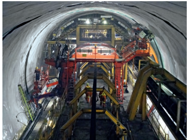
9 Abdichtungsarbeiten Waterproofing works
