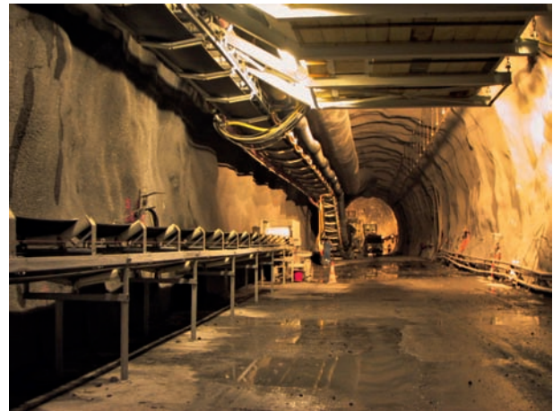
8 Hoch mechanisierter Sprengvortrieb – Brecher, Hängebühne mit den Infrastruktur-Aufbauten, Schleppband und Streckenband (Lötschberg-Basistunnel – Los Mitholz) Highly mechanized drill and blast heading – crusher, suspension platform with infrastructure installations, towing conveyor and continuous conveyor (Lötschberg Base Tunnel – Mitholz section)
