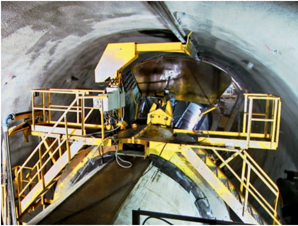
6 Spritzbetonmanipulator im Konsolidierungsbereich (Gotthard-Basistunnel – Los Amsteg) Shotcrete manipulator in consolidation area (Gotthard Base Tunnel – Amsteg section)
