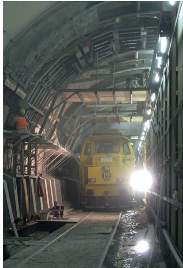
12 Schutzwand, verschiebbare Arbeitsbühne, Gewölbeschalung Safety wall, movable work platform, lining formwork
