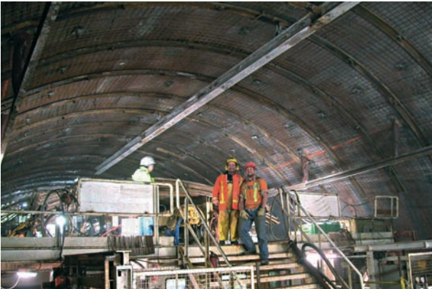
3 Vortrieb des Tunnels Tunnel construction
