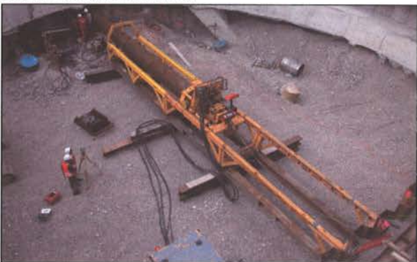
Bild 5: Pressbohrverfahren
