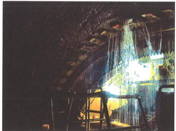
Bild 2: Zufluss im Bristner Granit am 12.10.2003 bei Tm 108'430
