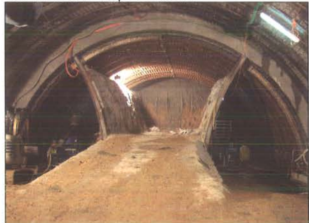
Bild 10: Vortrieb Teilquerschnitt IIIa
