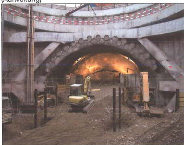
Bild 8: Vortrieb unter Bahnhofsgebäude St. Johann (Aufweitung)
