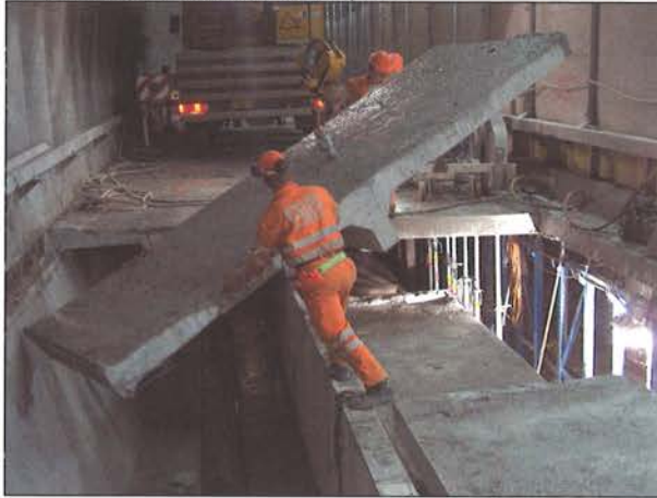
Bild 5: Abbruch der Fahrbahnplatte
