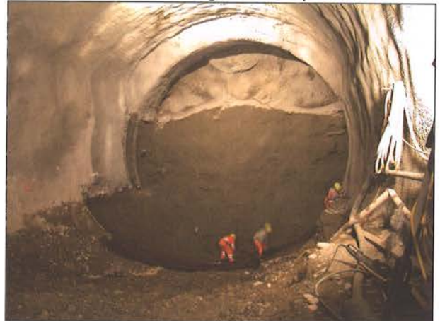
Bild 13: Ausbruchsicherung Sohle Einspurröhre
