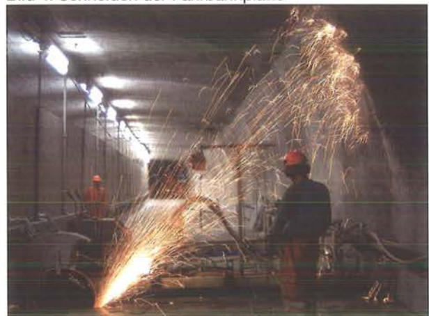
Bild 4: Schneiden der Fahrbahnplatte
