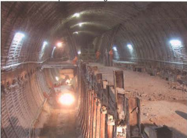
Bild 12: Abbruch prov. Innenbögen
