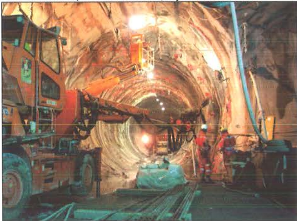
Bild 4: Sedrun, Weströhre Süd, Injektionsarbeiten
