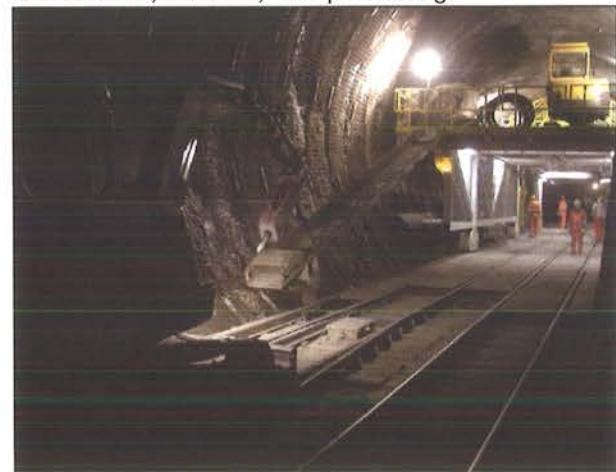
Bild 6: Bodio, Oströhre, Nachprofilierung
