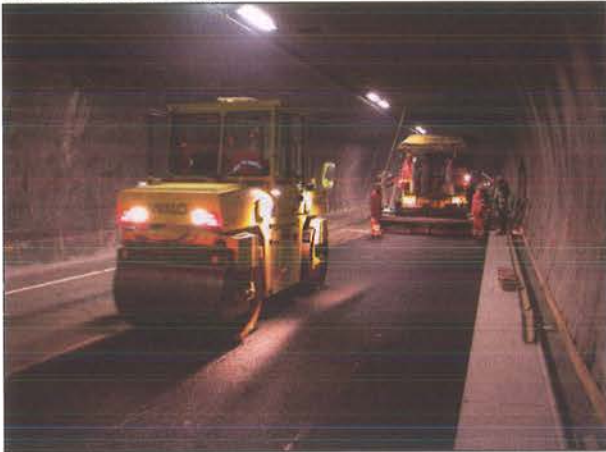
Bild 8: Einbau Belag
