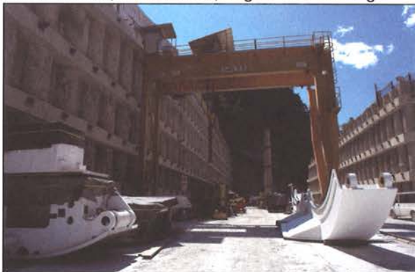
Bild 2: Erstfeld, Voreinschnitt, Beginn TBM Montage
