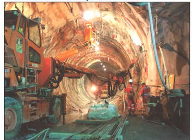
Bild 23: Arbeitsbereich Injektionsarbeiten
