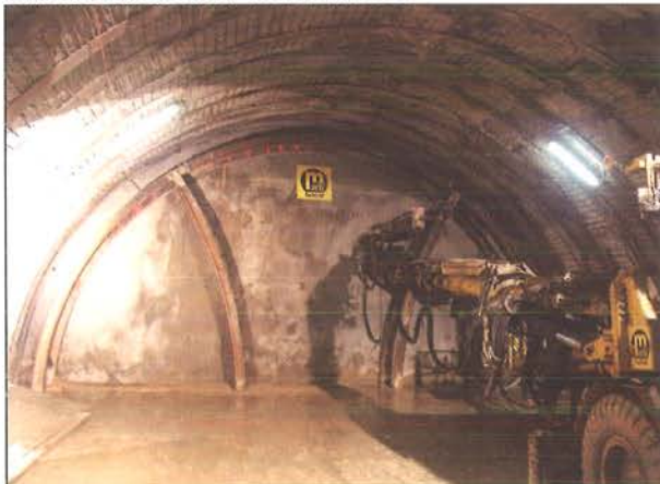
Bild 8: Start Vortrieb Kernbauweise
