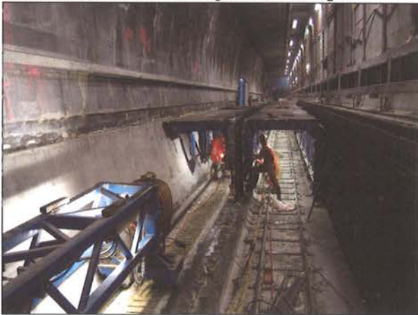
Bild 6: Vorrücken und Montage der Schalungen
