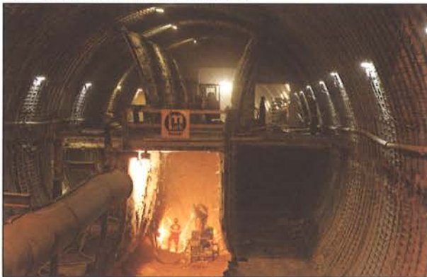
Bild 11: Vortrieb unterer Kern (IV)
