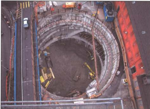
Bild 4: Startschacht neben dem bestehenden Bahnhofsgebäude St. Johann
