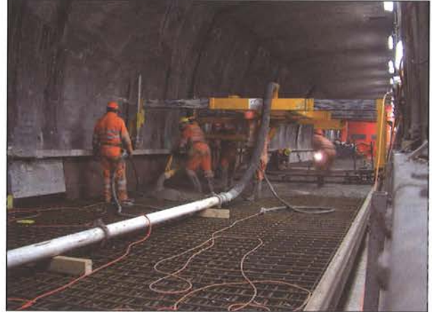
Bild 7: Betonieren der neuen Fahrbahnkonstruktion
