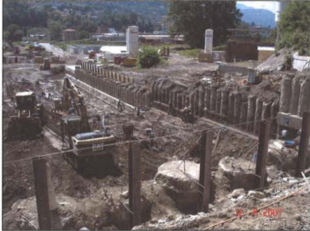
Bild 12: Jetting im Lockergestein
