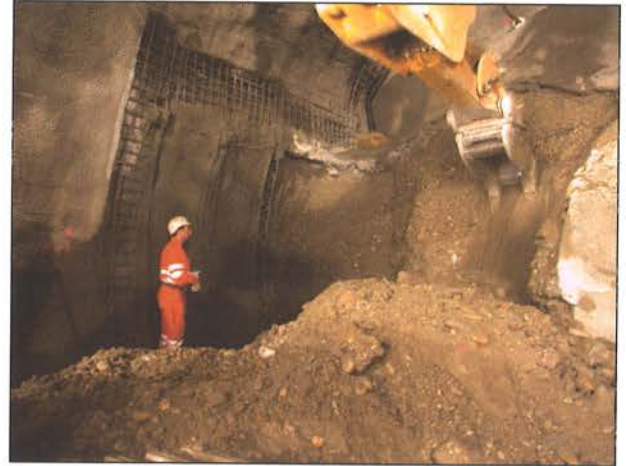
Bild 12: Vortrieb Einspurröhre
