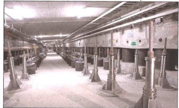
Bild 12: Der Sohlbereich unter der Fahrbahnplatte
