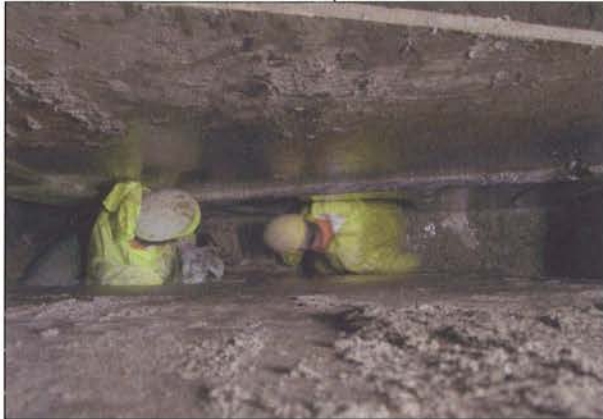
Bild 5: Raum zwischen Bohrkopf und Schild.
