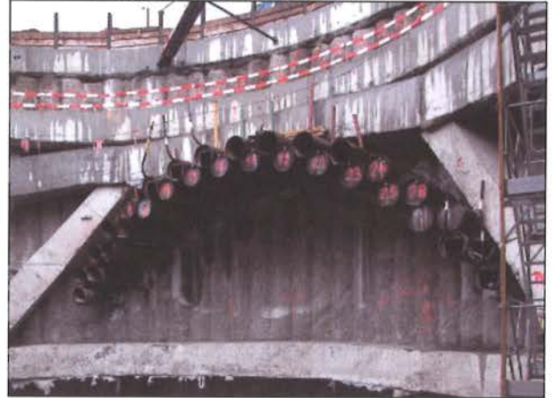
Bild 6: Fertiggestellter Grossbohrschirm
