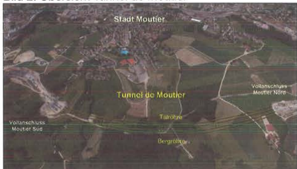
Bild 2: Übersicht Tunnel de Moutier
