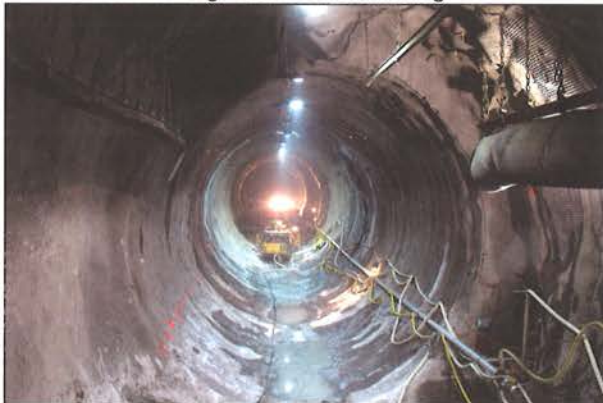
Bild 10: Verstärkung Ausbruchssicherung
