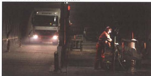
Bild 1: Arbeiten unter Verkehr
