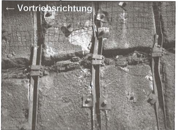
Bild 6: Infolge schiefe Einfallen der Schichtung schief gestellte Einbaubogen
