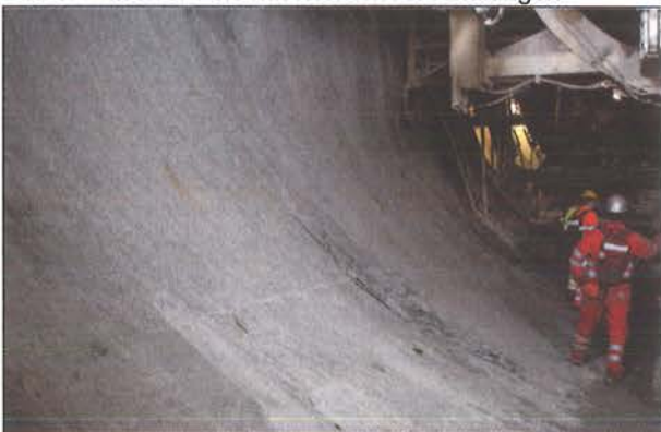
Bild 8: Massiver Fels mit leichten Abschalungen
