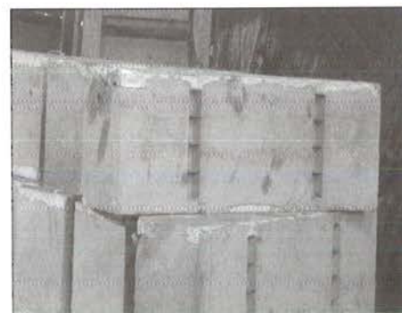
Bild 8: Stauchelemente Typ HYC
