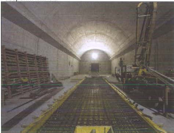
Bild 3: Innenausbauarbeiten in der Betriebszentrale Ost, Fusspunkt Mitholz
