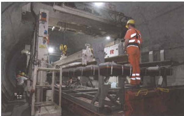
Bild 10: Mit dem Portalkran werden die 18 m langen Montagejoche verlegt
