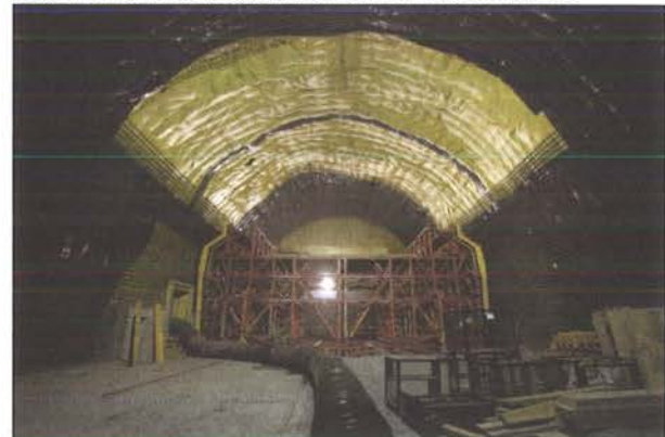
Bild 4: Innenausbauarbeiten in den Relaisräumen
