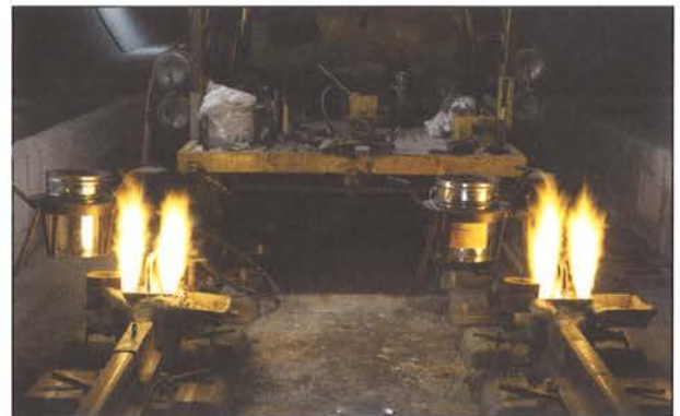
Bild 11: Verschweissen der definitiven 120 m langen Schienen
