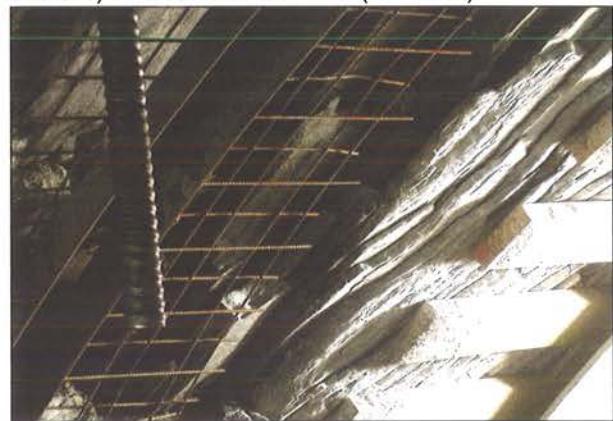
Bild 6: a) TBM-Vortrieb Oströhre (Tm 1'051)
