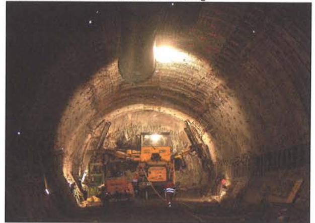
Bild 7: Weströhre Faido, Überfirstung
