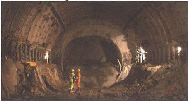
Bild 11: Aufgeweiteter Tunnelabschnitt mit altem kleinerem Profil im Hintergrund
