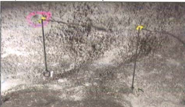
Bild 8: Anker mit Ösen. Die vorstehende Ankerlänge entspricht dem effektiven Überprofil.
