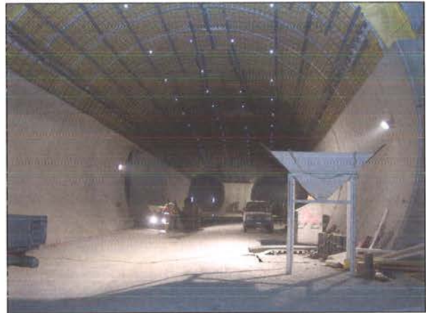
Bild 18: Kalotte mit Messpunkten während dem Einfüllen des Kies. Die gemessenen Verformungen lagen alle unter 10 mm.
