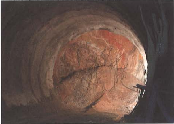
Bild 8: Teilabschnitt Sedrun, Vortrieb in der Röti-Serie; Sicherung: Stahleinbau, Ortsbrustanker
