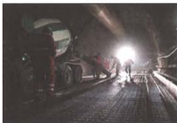
Bild 6: Eingesetzte Baumaschinen unter Tage
