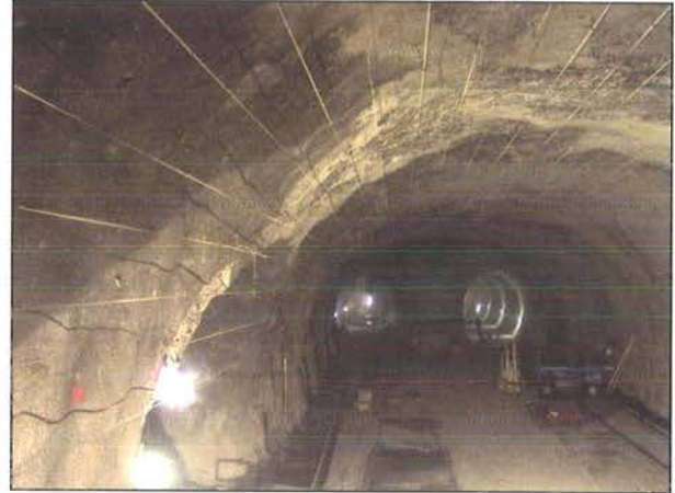
Bild 9: Ansicht der Spurwechselkaverne mit den durch die Ösen gezogenen Spannbändern.
