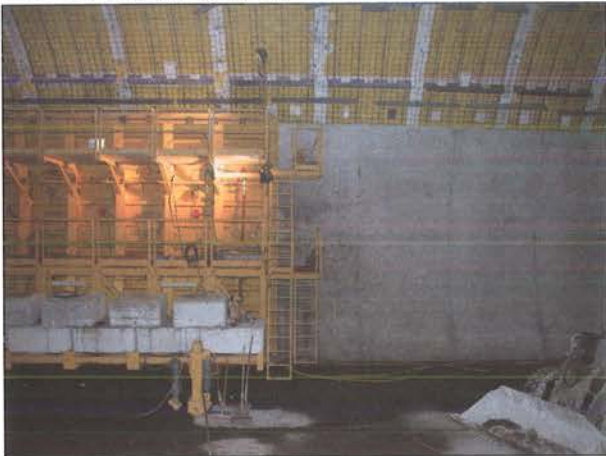
Bild 16: Paramentschalung
