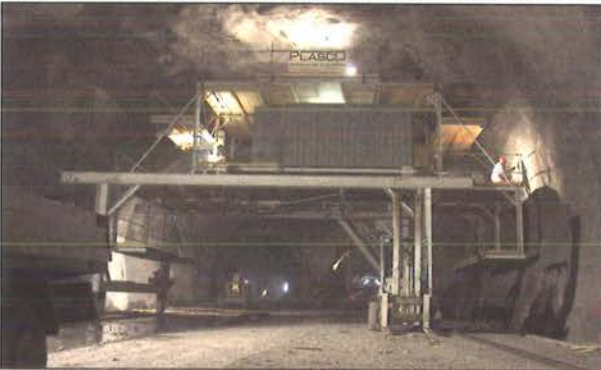
Bild 7: Fahrbares Gerüst mit seitlich ausfahrbaren Konsolen
