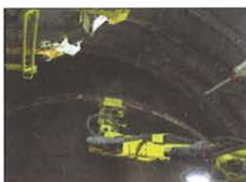
Foto 7: Streckenausbaumaschine im Einsatz: Versetzen der Stahlbogen
