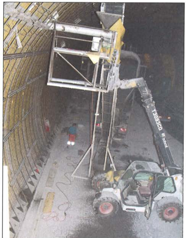
Bild 14: Installationseinrichtung für das Einbringen von Kies seitlich in die Paramente
