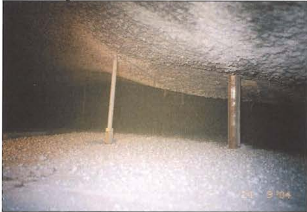
Bild 20: Rechts Kontrollrohr zum Feststellen der satten Hinterfüllung
