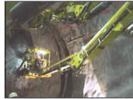
Foto 8: Streckenausbaumaschine im Einsatz: Ablängen der Brustanker
