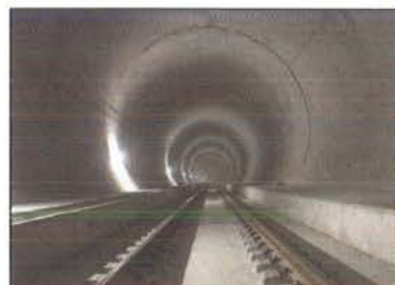
Bild 3: Einspurige Bahntunnelröhre nach dem Einbau der Fahrbahn und der Geleise
