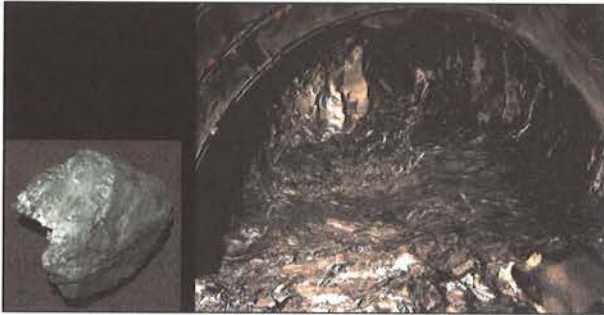
Bild 3: Die Aufnahme rechts zeigt die Ortsbrust bei km 30.485 im Tunnel West. Bei den glänzenden Flächen in der Kalotte handelt es sich um spiegelige Schicht- oder Scherflächen. Die kleine Aufnahme links zeigt ein Handstück Karbonschiefer.
