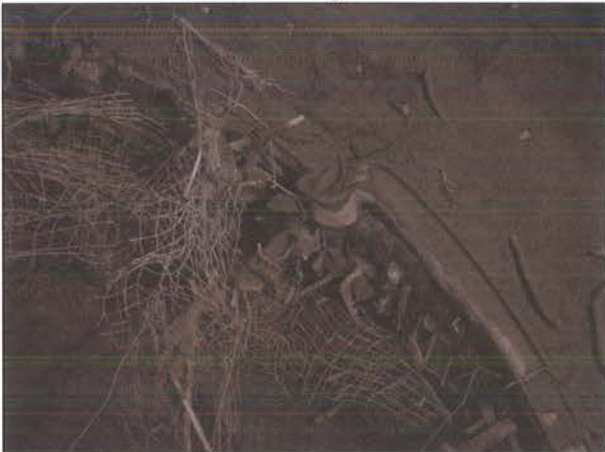
Bild 8: Deformierte und abgescherte Stahlbögen im EST West-Nord
