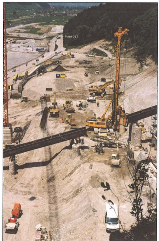
Bild 2: Baustelle Erstfeld Tagbaustrecke mit Voreinschnitt
