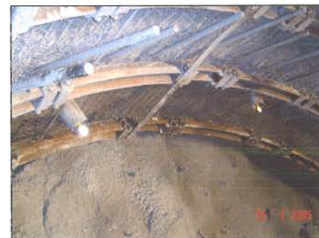
Foto 1: Ausbruchsicherung
