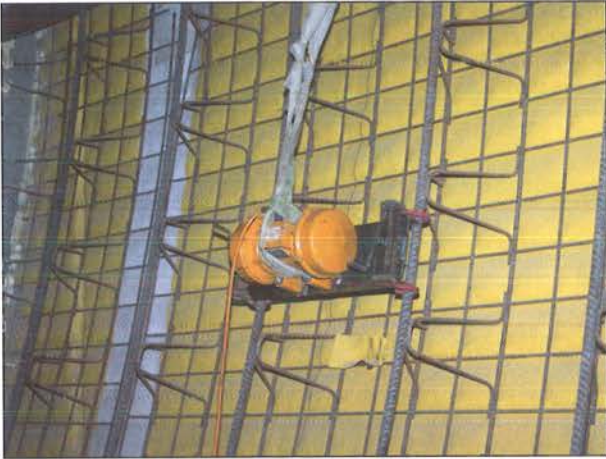
Bild 15: Vibrator zum Verdichten der Kieshinterfüllung
