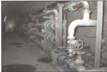
Bild 14: Kühleinrichtungen im Fusspunkt Ferden bestehend aus einem System von Wasserleitungen im Abluftstollen Fystertellä (Bild oben) und Kühlaggregate an den kritischen Stellen im Tunnel Ost und West zur zusätzlichen Kühlung der Tunnelluft (Bild unten)
