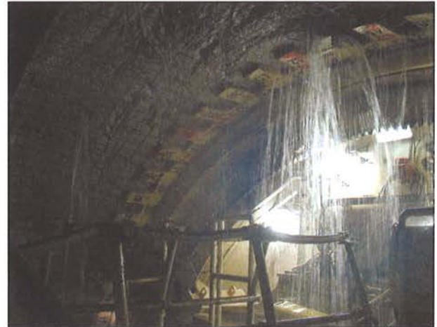
Bild 11: Wassereinbruch
