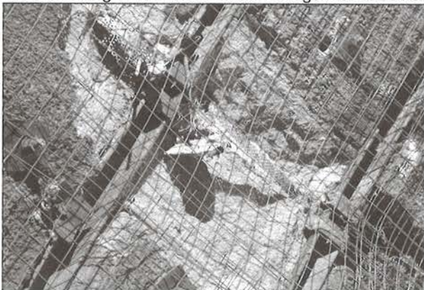
Bild 10: Deformiertes Stauchelement Typ HYC. Die als Querarmierung dienenden Lochbleche liegen teilweise frei.
