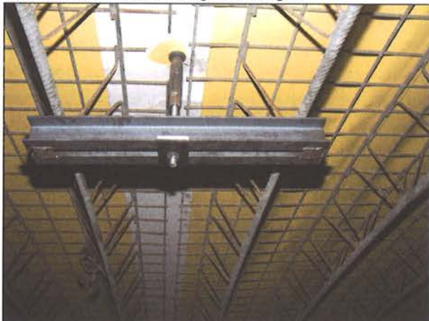
Bild 12: Detail Verankerung Gitterbogen
