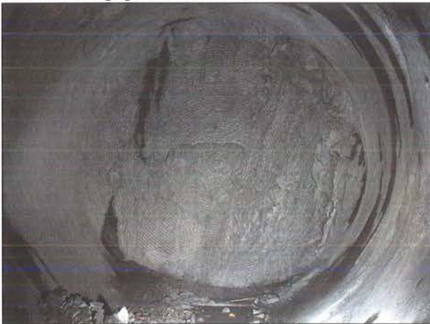
Bild 4: Amsteg, gefräste Ortsbrust
