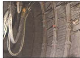
Foto 9: Bettung der Bogen mit Spritzbeton
