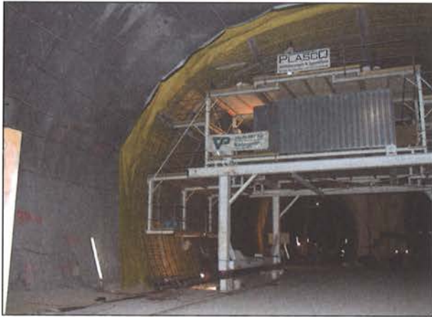
Bild 11: Ansicht der Dichtungsbahn- und Gitterbogenmontage
