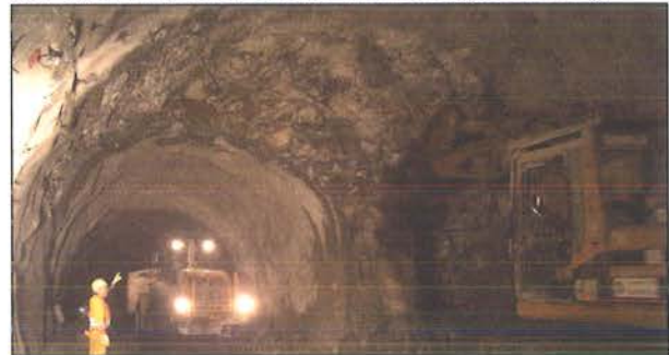
Bild 19: Aufweitung des Seitenstollen West zum Einziehen einer Zwischendecke für die Rauchgasableitung
