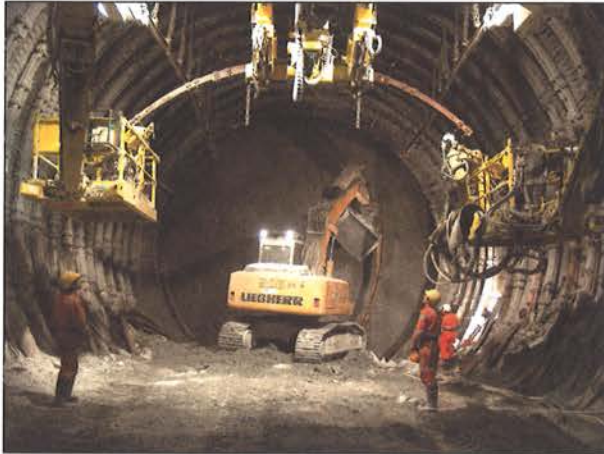
Bild 6: Stahleinbau Sedrun
