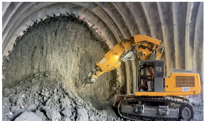
6 Excavation à la pelle hydraulique et godet ripper
