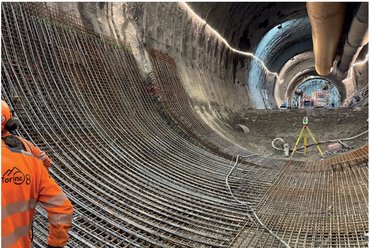
13 Einbau der Armierung Sohle
