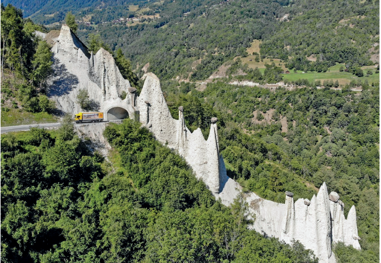
1 Photo du site et de l'ancien tunnel
