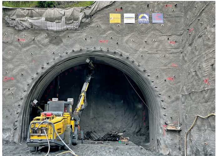
5 Forage voûte parapluie en tunnel
