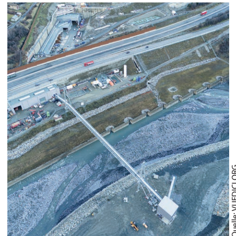
7 Luftbild Installationsplatz mit Betonanlage, Lagerflächen und Voreinschnitt
