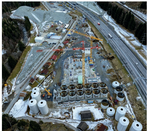
9 Zweite Gotthardröhre: Bau Aufbereitungsanlage in Airolo/Stalvedro
