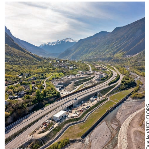
5 Übersicht Installationen und Voreinschnitt
