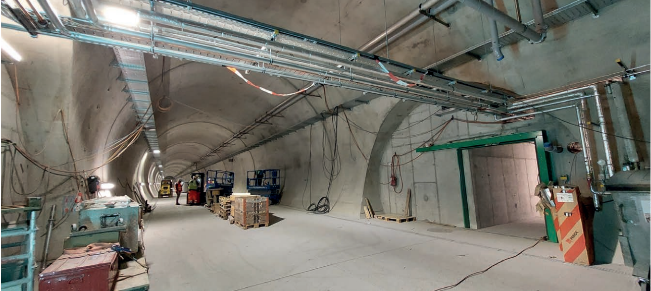
8 Unterirdischer Evakuierungs- und Rettungspunkt/Installationsarbeiten
