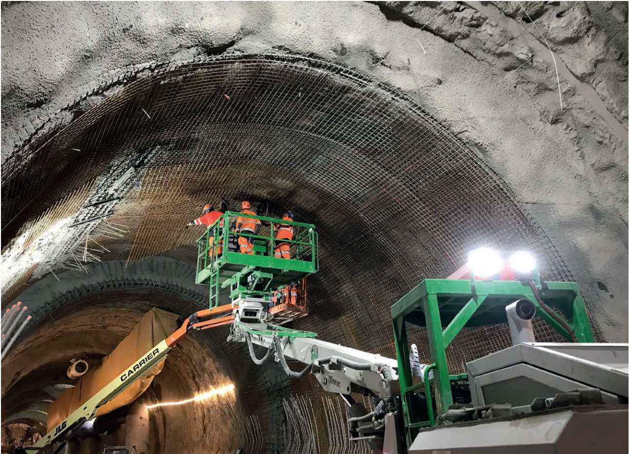
14 Einbau Armierung Kalotte
