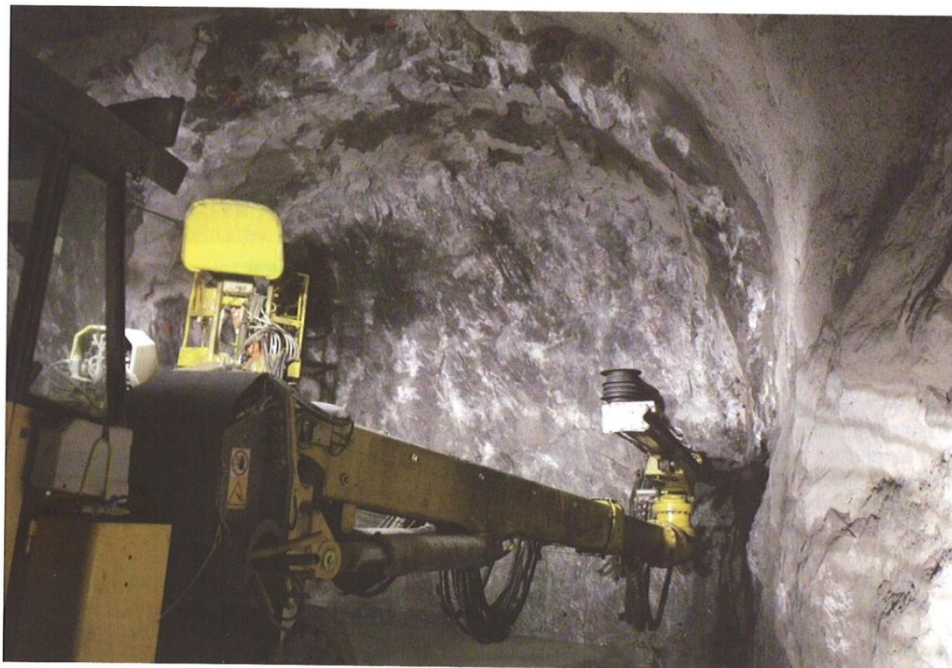
Photo 8 : Nant-de-Drance, avancement par minage Nant-de-Drance, sprengvortrieb
