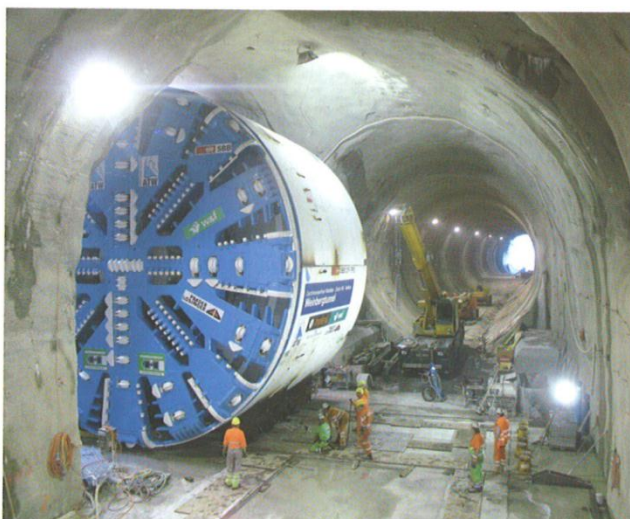
Photo 6 : Transformation du tunnelier au tunnel de Weinberg / Umbau Hydroschild beim Weinbergtunnel
