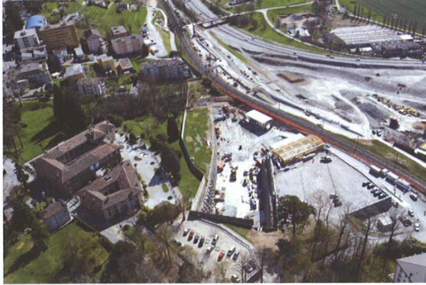
Photo 3 : Attaque Sud (Vezia) du tunnel de base du Ceneri / Angriff Süd (Vezia) des Ceneri Basistunnel
