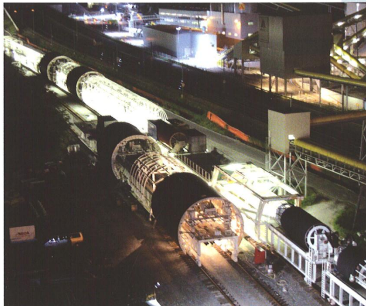
Photo 2 : Logistique sur le tunnel de base du Gothard / Logistik beim Gotthard Basistunnel
