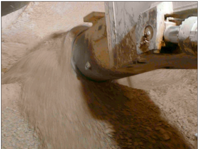
TSM Vortrieb Tunnel du Neu Bois
