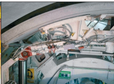
Versetzen der Tübbinge im Tunnel de Bure
