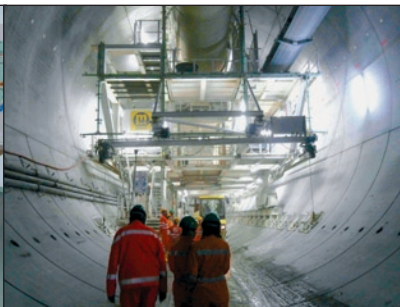
Tunnelbohrmaschine im Tunnel de Bure
