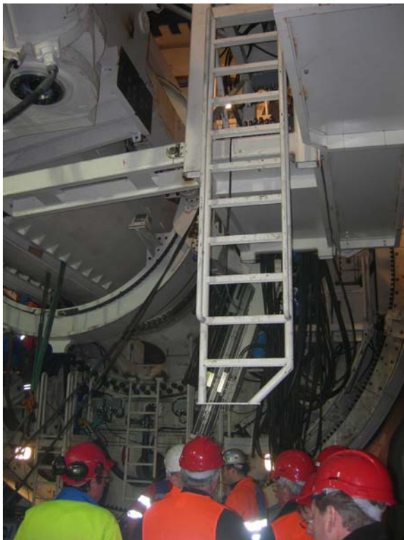
Photo n° 3: Explications techniques derrière la tête du tunnelier
