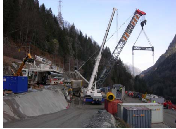
Photo n° 2: Installation de chantier pour le montage du tunnelier à Châtelard
