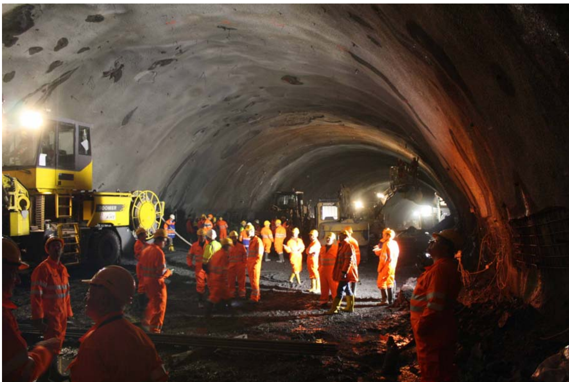
Tunnel Eyholz: Besichtigung Südvortrieb
