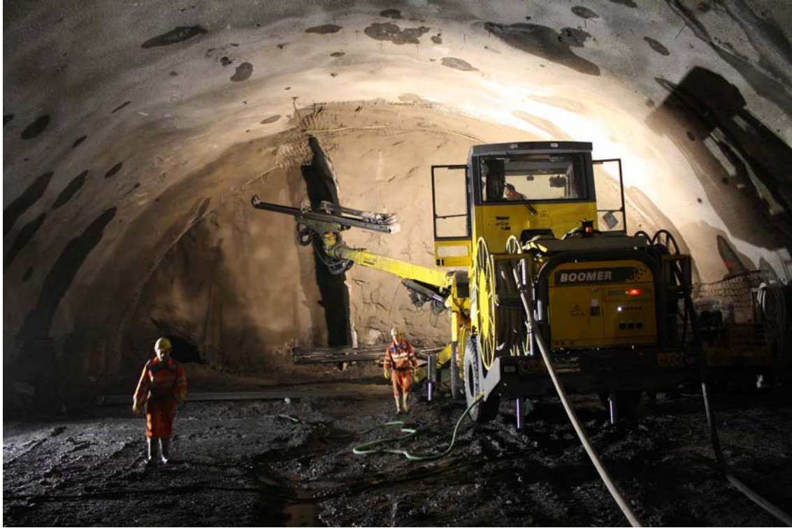
Tunnel Eyholz: Besichtigung Südvortrieb
