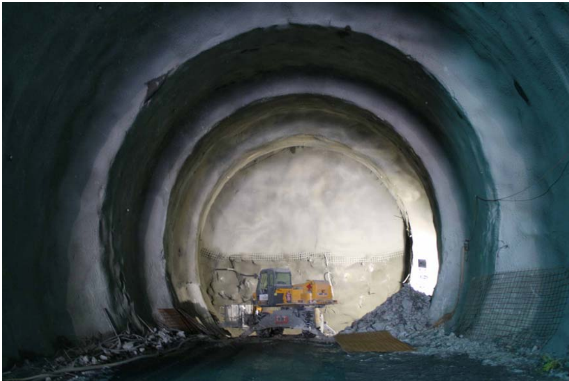
Tunnel Eyholz: Jettingvortrieb Nordvortrieb
