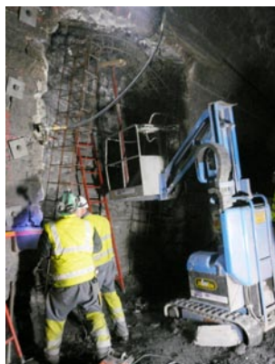
Tunnel ferroviaire du Fréjus – Réalisation de niche de sécurité supplémentaire
