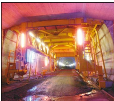
Schalung der Zwischendecke
