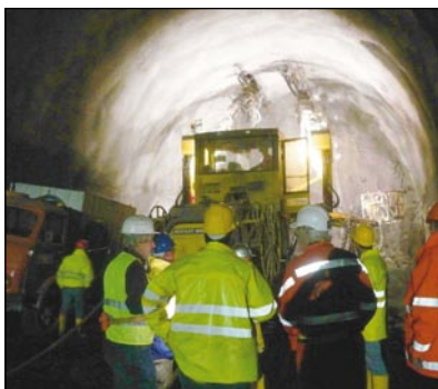
Konventioneller Vortrieb mit Tamrock Rocket Boomer
