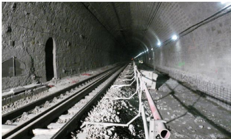
Tunnel ferroviaire du Fréjus – Abaissement du radier
