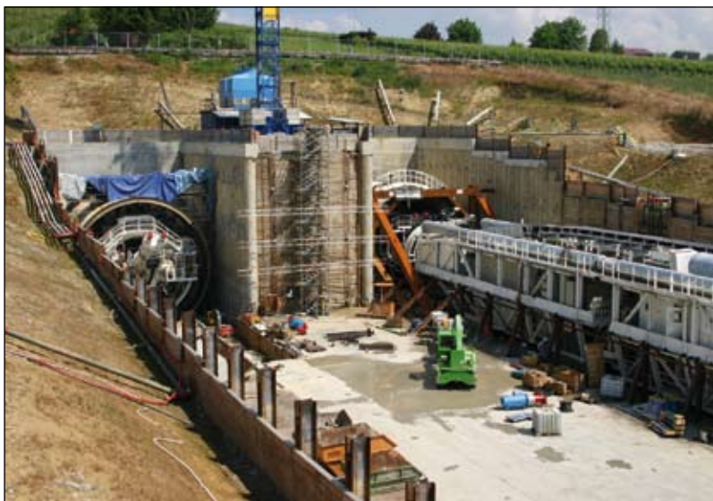
TBM Startröhren Süd, rechts Oströhre, links die Weströhre, TBM Ausbruchdurchmesser 11.16 m
