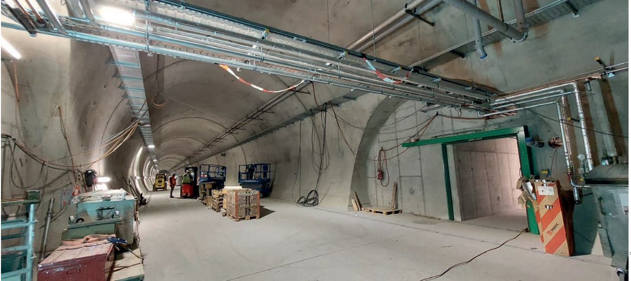
8 Unterirdischer Evakuierungs- und Rettungspunkt/Installationsarbeiten
