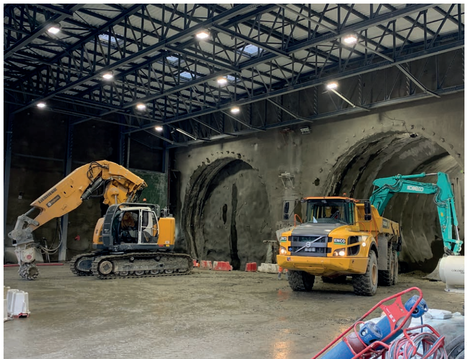
21 Vortriebsbeginn im Dezember 2022 im injizierten Baugrund im Schutz des Hangars Acoustique
