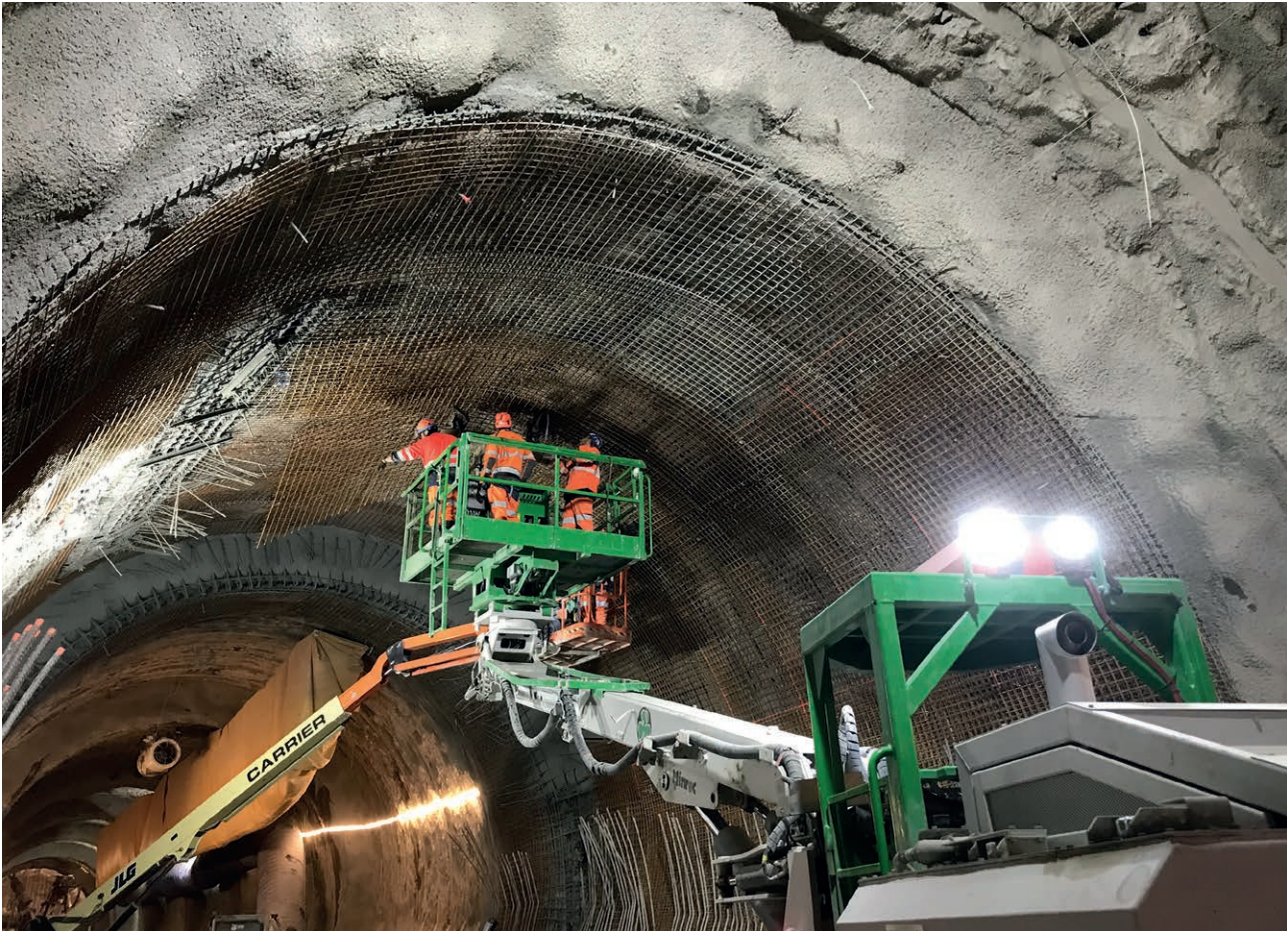
14 Einbau Armierung Kalotte
