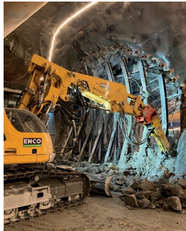
11 Bogenrückbau
